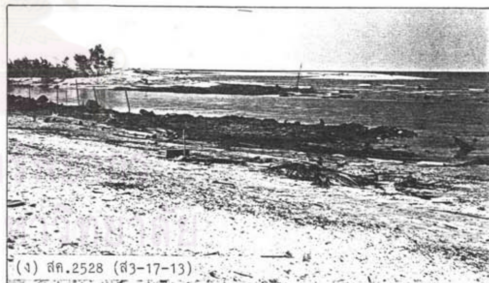
- คั้งซำยปากแม่น้ำตากใบ (แหลมทรายด้านนอก) ถูกกัดเซาะหดสั้นลงไปมาก และชายฝั่งด้านใน (ฝั่งขวาแม่น้ำตากใบ) ถูกเปิดออกรับแรงคลื่นโดยตรงทำให้พื้นที่ถูกกัดเซาะหายเร็วไปมาก
