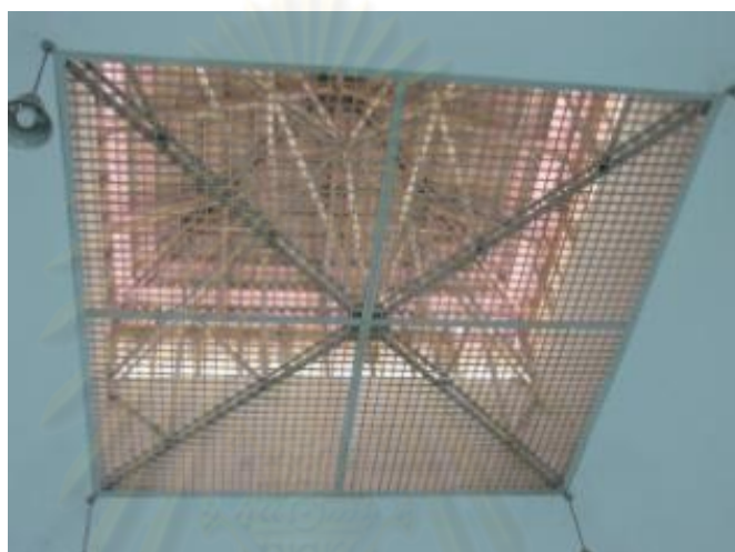
ภาพที่ 1.3 บริเวณช่องแสงด้านบนของอาคารห้องสมุดที่ใช้ประโยชน์ของแสงธรรมชาติ อย่างไม่คุ้มค่า
