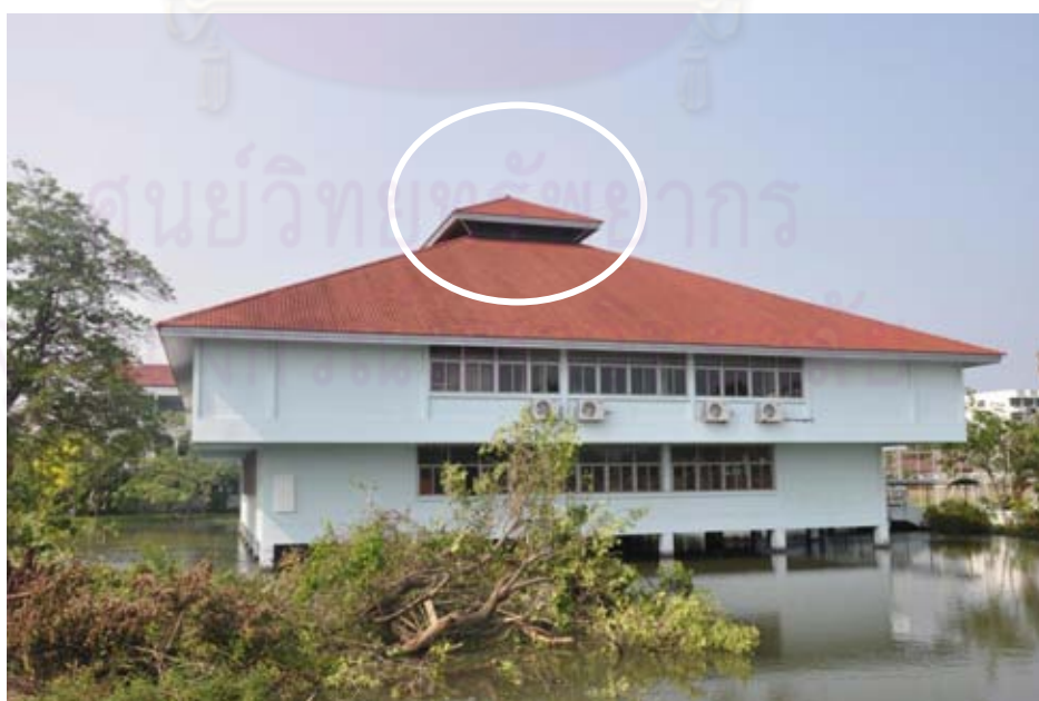
ภาพที่ 1.4 บริเวณช่องแสงด้านบนของอาคารห้องสมุดปัจจุบันที่ใช้สำหรับระบายอากาศ
