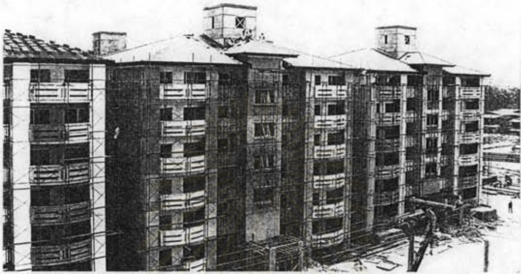
การประกอบชิ้นส่วนขั้นสุดท้ายคือการมุงหลังคา
