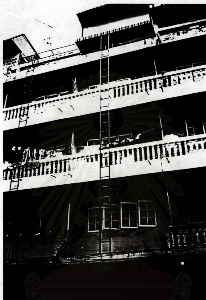
ภาพที่ 10 ทางหนีไฟซึ่งไม่น่าที่จะเชื่อถืออำนวยความสะดวกการใช้ประโยชน์ในกรณีฉุกเฉินได้
