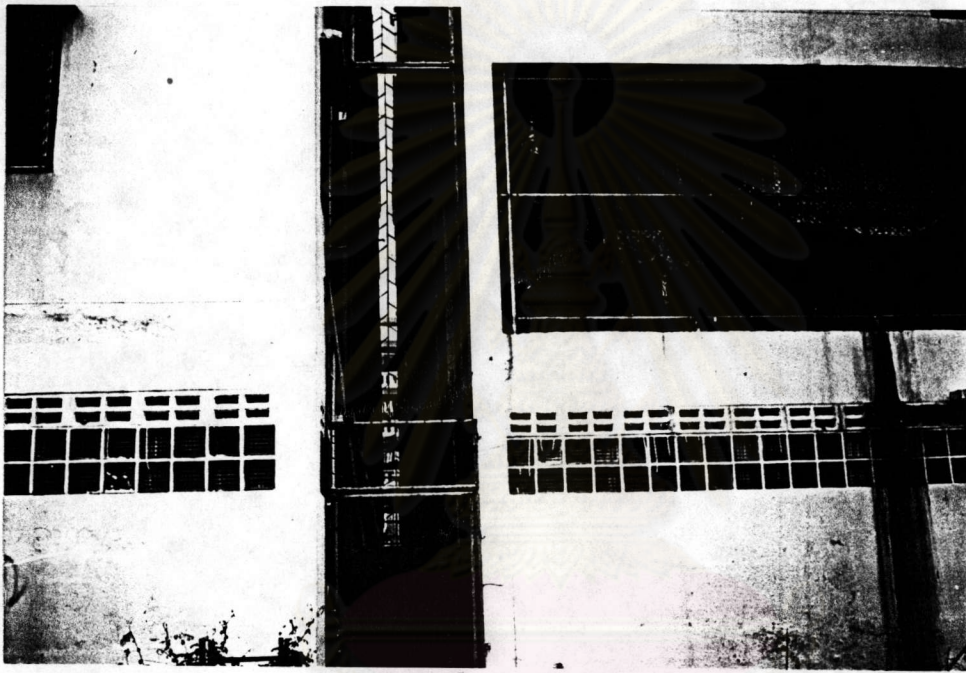
ภาพที่ 12 ช่องว่างระหว่างตัวอาคารหอพักสองหลัง ที่แคบมากขัดต่อ พ.ร.บ.ควบคุมอาคาร
