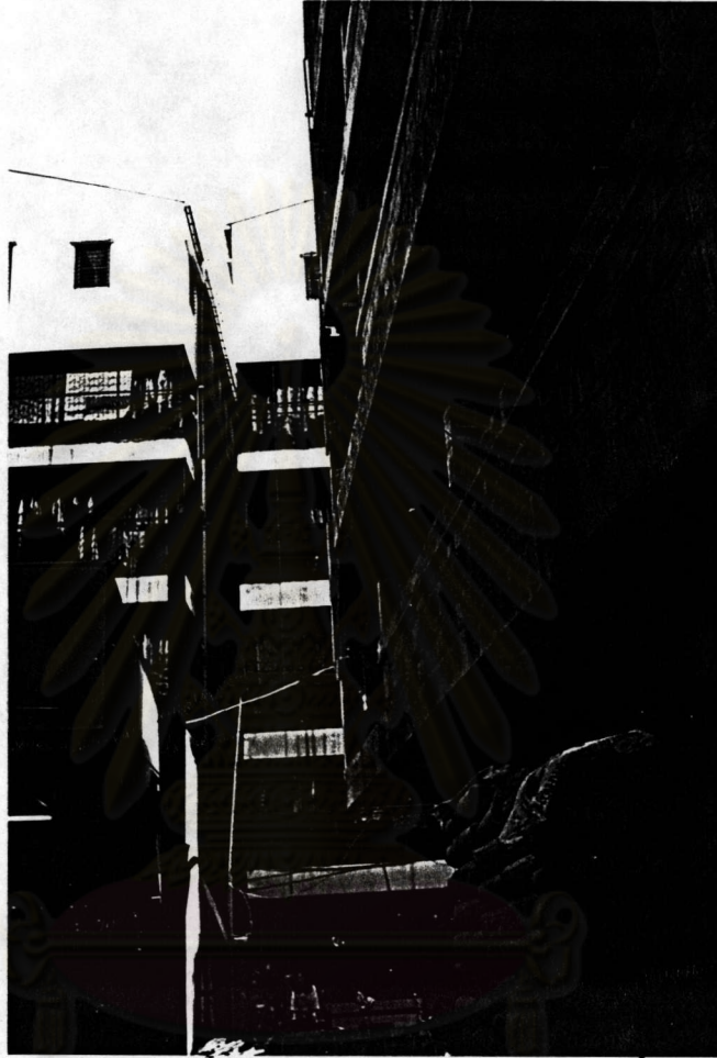
ภาพที่ 11 ลูกกรงเหล็กคัตที่สร้างขึ้นปิดเต็มพื้นที่ และใช้สำหรับเป็นที่ตากเสื้อผ้าด้วย
