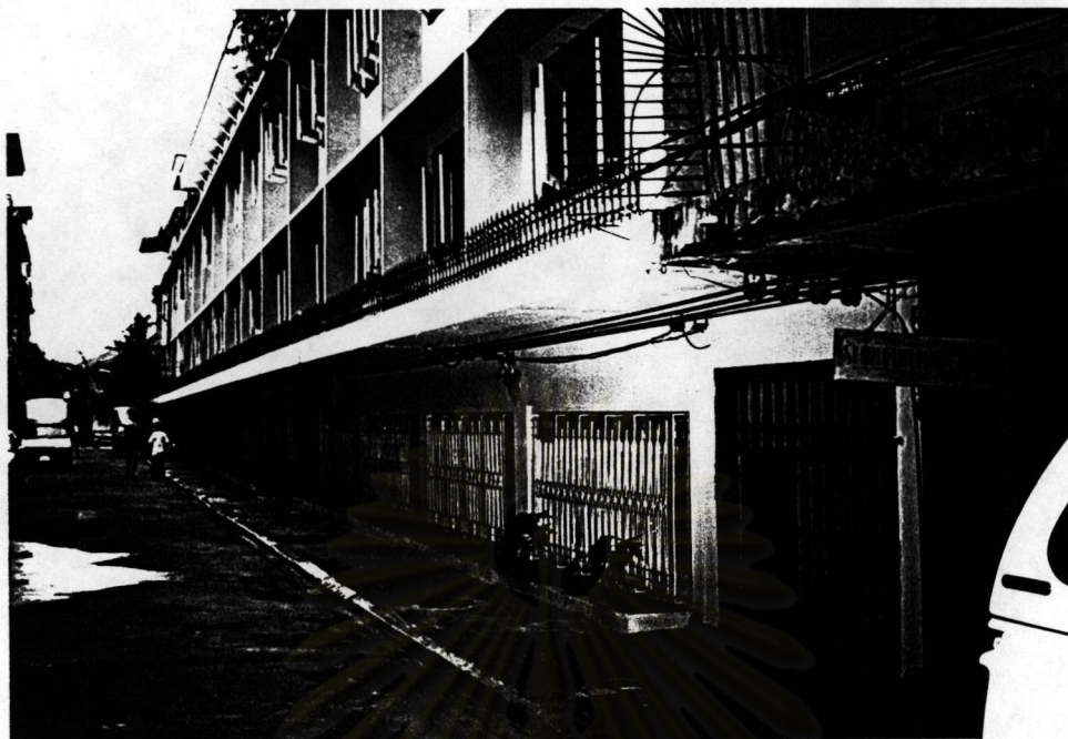
ภาพที่ 3 อาคารที่พักอาศัยแบบหอพักรุ่นแรกๆ และต่อมาได้มีการยกระดับถนนให้สูงขึ้นจนทำให้พื้นชั้นล่างอยู่ต่ำกว่าระดับถนนมาก
