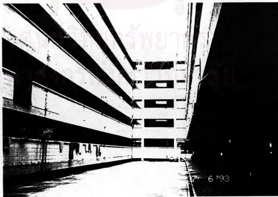
ภาพที่ 4.112 ทิศนี้สภาพบริเวณคอร์ตกลางอาคารของแฟลต
