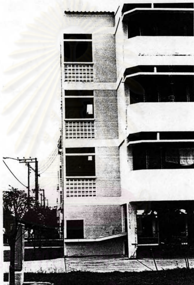
ภาพที่ 4.94 ปล่องทิ้งขยะ บริเวณ บันไดทางขึ้นของอาคาร
