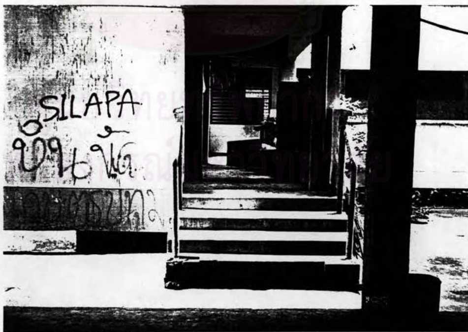
ภาพที่ 4.119 บันไดทางขึ้นอาคาร
