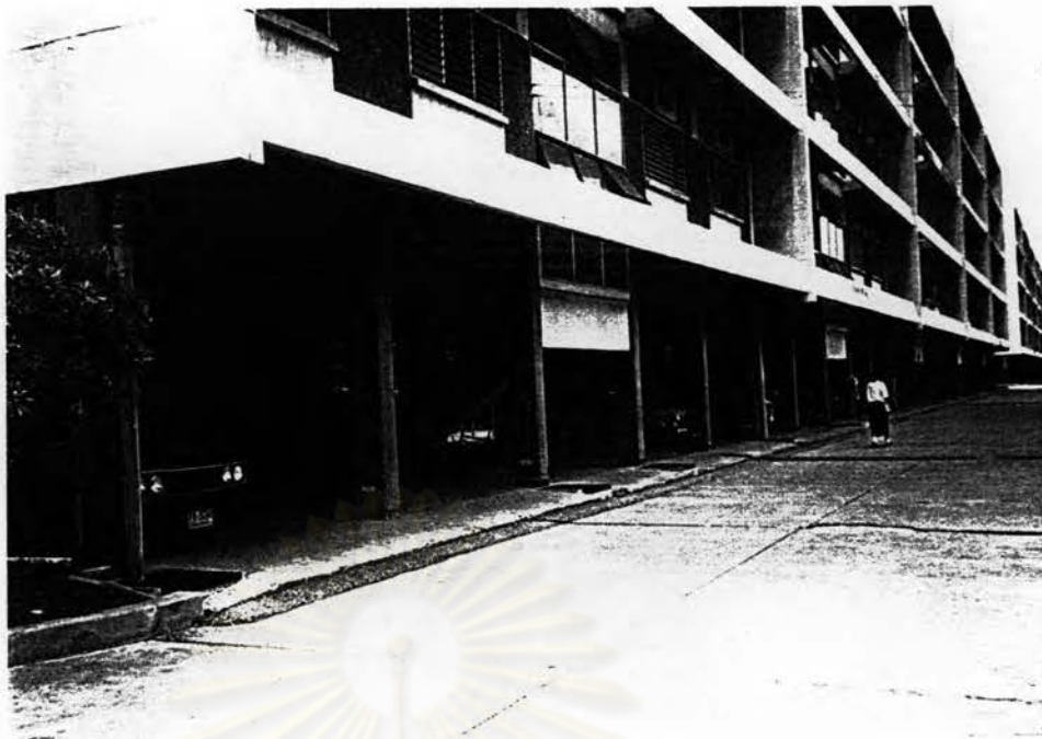
ภาพที่ 4.61 บริเวณชั้นล่างของอาคาร ซึ่งเป็นใต้ถุนโล่ง ใช้สำหรับจอดยานพาหนะและเป็นที่นั่งพักผ่อน
