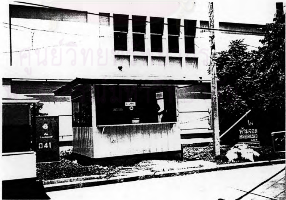
ภาพที่ 4.6 ป้อมยาม รักษาความปลอดภัย บริเวณทางเข้าโครงการ
