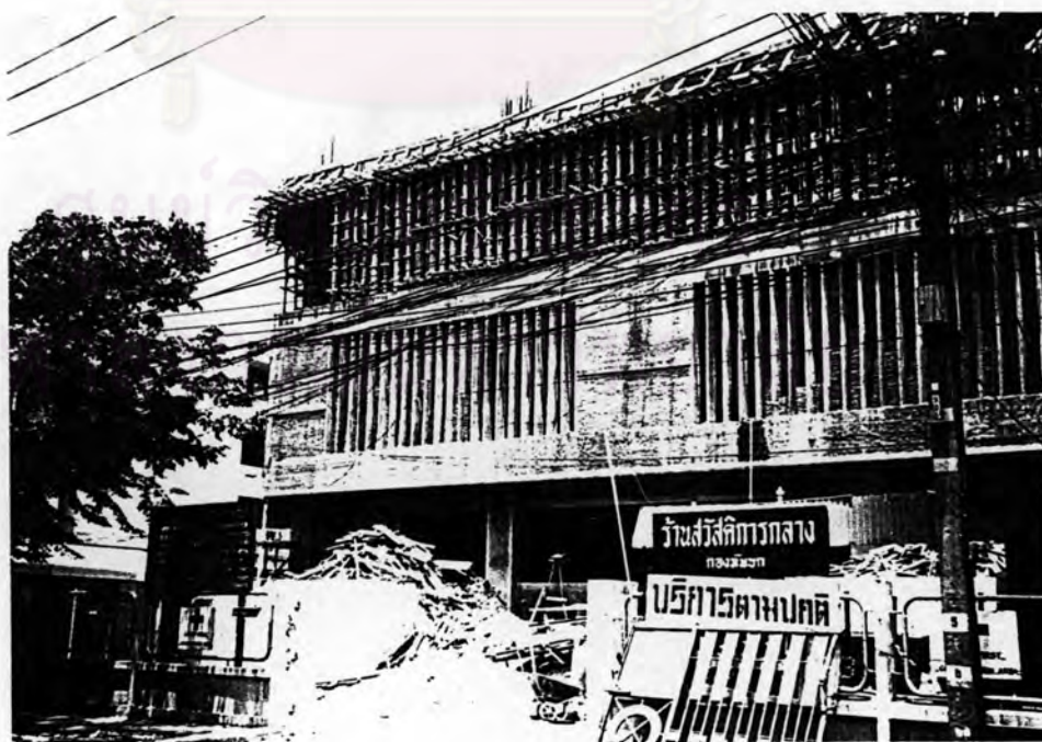
ภาพที่ 4.44 อาคาร ร้านสวัสดิการกองทัพบก หลังใหม่ กำลังดำเนินการก่อสร้าง เป็นอาคารสูง 5 ชั้น ซึ่งตั้งอยู่ภายในโครงการฯ คลองประปาสามเสน
