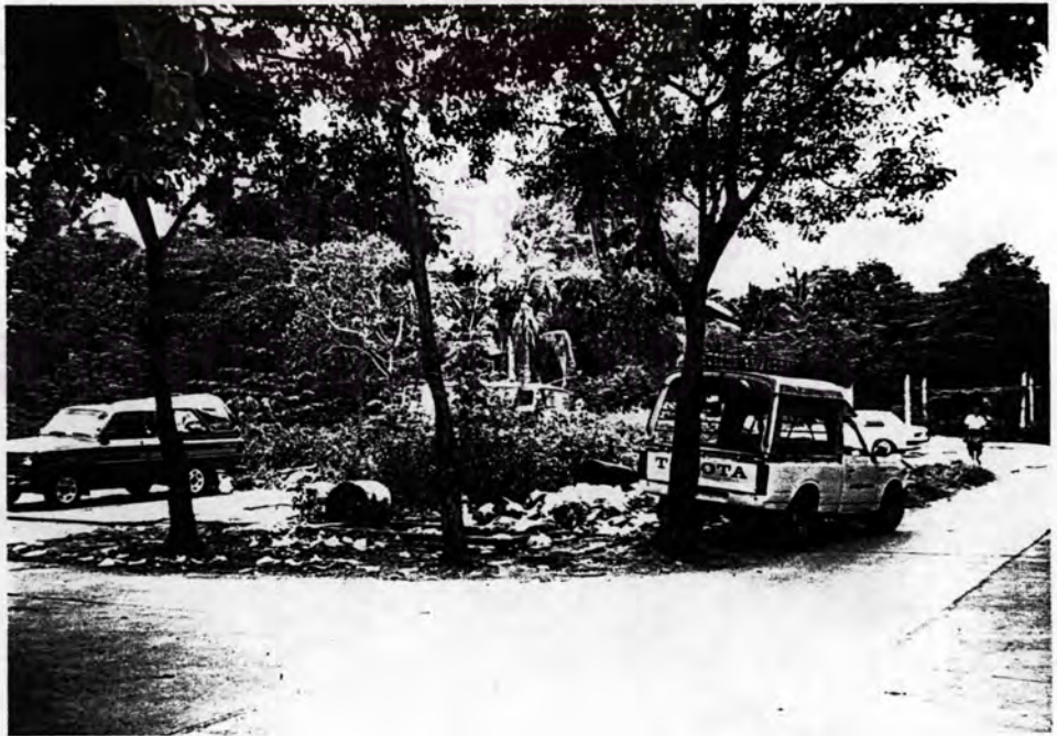
ภาพที่ 4.125 พื้นที่ว่าง ด้านหลังโครงการ ประมาณ 1 ไร่ ซึ่งทางหน่วยงานผู้รับผิดชอบ กำลังดำเนินการก่อสร้าง เป็นตลาดสดและร้านค้าสวัสดิการ
