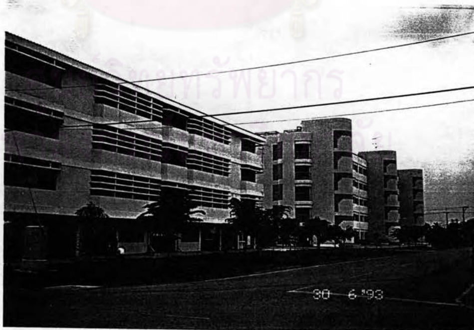
ภาพที่ 4.73 ทศนียภาพอาคารสูง 4 ชั้นใต้ถุนโล่งและอาคารครอบครัวสูง 5 ชั้นใต้ถุนโล่ง
