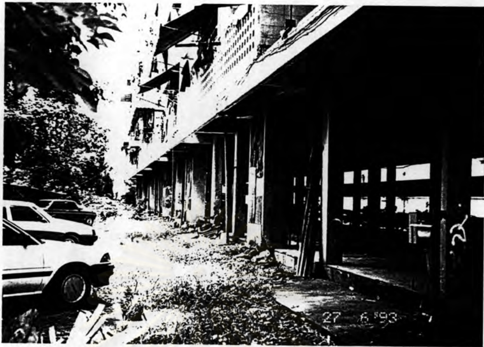
ภาพที่ 4.113 สภาพบริเวณด้านหลังอาคาร ชั้นล่าง ซึ่งมีสภาพชำรุดทรุดโทรม
