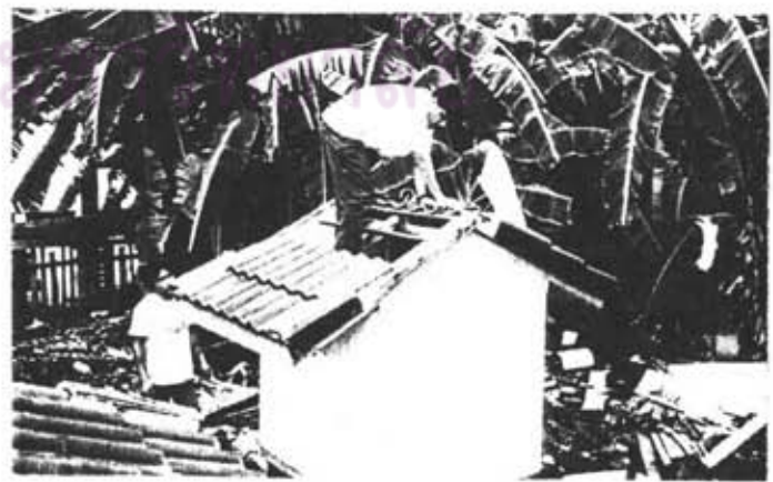
ภาพที่ 3.4.4 : การเปิดกระเบื้องหลังคาจาก การทดลองชุดที่ 1 เพื่อติดตั้งฉนวน ในการทดลองชุดที่ 2
