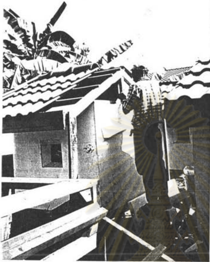
ภาพที่ 3.3.1 และ 3.3.2 : การกรุโพน ที่หน้าจั่วเพื่อป้องกันการถ่ายเทความร้อน (การทดลองชุดที่ 1 )
