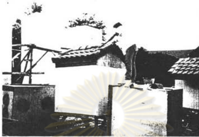
ภาพที่ 3.5.3 : การมุงกระเบื้องหลังคาแบบไม่มีชายคาสำหรับทดสอบวัสดุผนัง
