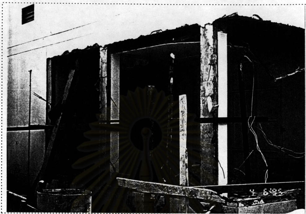
รูปที่ 33 แสดงการก่อสร้าง Test Unit ขนาดใกล้เคียงของจริง เพื่อติดตั้งผนังทดสอบ
