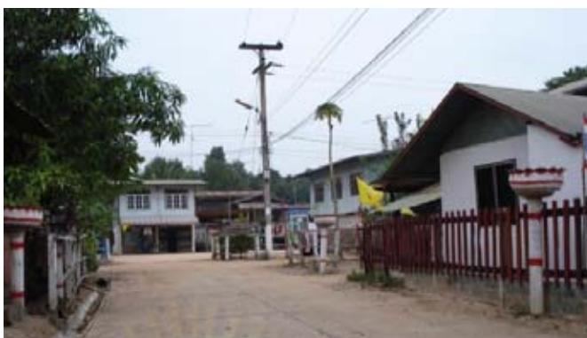
ภาพที่ 4.41 เส้นทางสัญจรภายในบริเวณหมู่บ้านกุ้งตันตันซึ่งมีการปรับปรุงพื้นผิวถนนจากเดิมเป็นถนนลูกรังมาเป็นถนนคอนกรีตเสริมเหล็ก เซาะร่องด้านข้างทำรางระบายน้ำ
