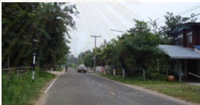
ภาพที่ 4.42 เส้นทางสัญจรที่เชื่อมต่อระหว่างไปยังหมู่บ้านดงสวรรค์ ไปยังหมู่บ้านหนองเปลือยน้อยซึ่งมีการพัฒนาพื้นให้เป็นพื้นผิวที่มี ความถาวรโดยการบดอัด และลาดยางมะตอยตลอดสาย
