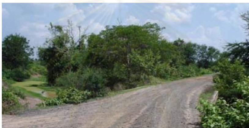
ภาพที่ 5.13 เส้นทางสัญจรที่เชื่อมโยงระหว่างหมู่บ้านกุ้งไปยังหมู่บ้านสระบัวที่มีปัจจุบันเป็นเส้นทางเดียวที่เชื่อมระหว่างหมู่บ้าน มีสภาพผิวถนนที่ทรุดโทรมและคับแคบ ซึ่งอาจจะต้องมีการตัดถนนใหม่หรือต้องขยายเส้นทางเพื่อให้เดินทางเข้าสู่พื้นที่ได้สะดวกมากขึ้น
