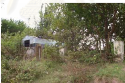
ภาพที่ 4.58 สถานีเก็บน้ำบาดาลของชุมชนบ้านเปือยน้อยที่มีสภาพทรุดโทรม
