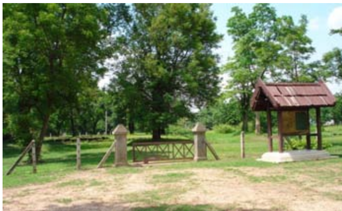
ภาพที่ 6.17 การกำหนดขอบเขตของโบราณสถานกู่น้อยในปัจจุบัน ที่ประสบปัญหาด้านการนำสัตว์เลี้ยงเข้าไปเลี้ยงในเขตโบราณสถาน เนื่องจากว่ารั้วที่นำมาใช้ ประกอบด้วยประตูนั้นไม่หนาแน่นพอ
