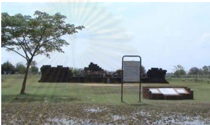
ภาพที่ 4.27 พื้นที่โบราณสถานในฤดูฝนที่มีน้ำท่วมขังพื้นที่ เนื่องจากโบราณสถานที่อยู่ต่ำกว่าพื้นที่บ้านเรือนชุมชน ซึ่งอาจจะต้องมีการวางท่อรองรับน้ำโดยรอบพื้นที่เพื่อเป็นการดักน้ำก่อนที่น้ำจะเข้ามาท่วมในพื้นที่
