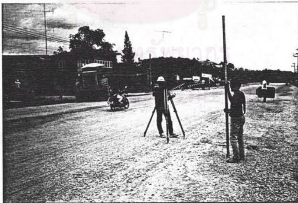
รูป 2.24 การตรวจสอบระดับชั้นพื้นทาง
