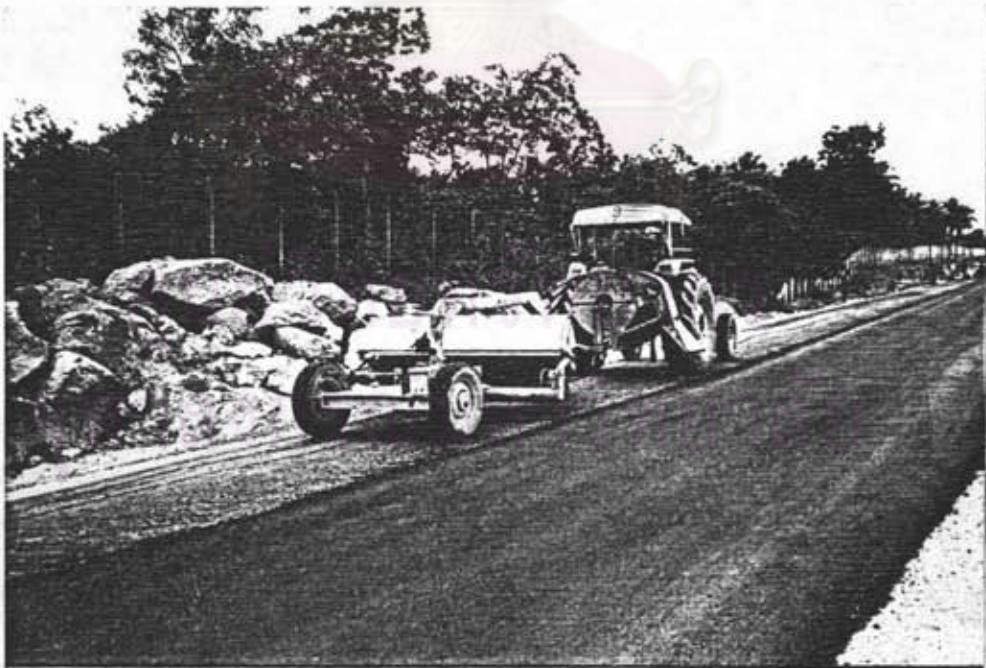
รูป 2.26 การทำความสะอาดชั้นพื้นทางด้วยเครื่องกวาดฝุ่นและเครื่อง เป่าลม
