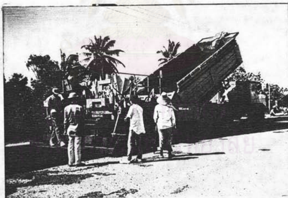
รูป 2.29 การเทวัสดุผลัมนำจากบรรทุกทุกชั้นลงบนเตียงรับวัสดุของ เครื่องปูผิว
