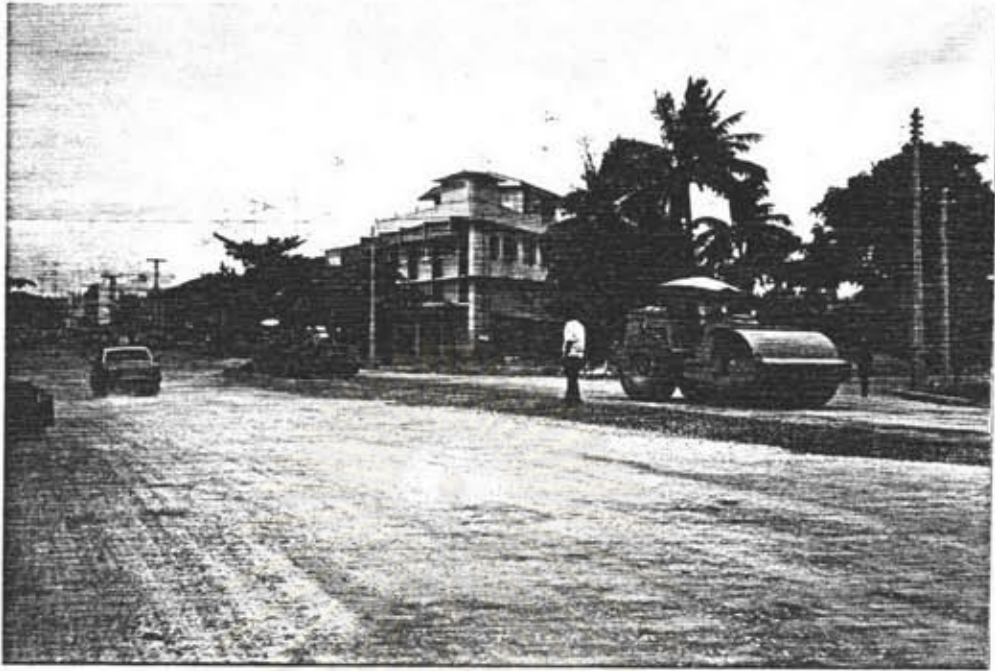
รูป 2.25 การปรับระดับชั้นพื้นทางให้ถูกต้องตามรูปตัดที่กำหนด
