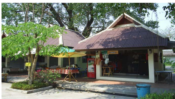
รูปภาพที่ 5 แสดงกลุ่มอาคารร้านค้า บริเวณอาคารศูนย์ข้อมูลและพิพิธภัณฑ์
