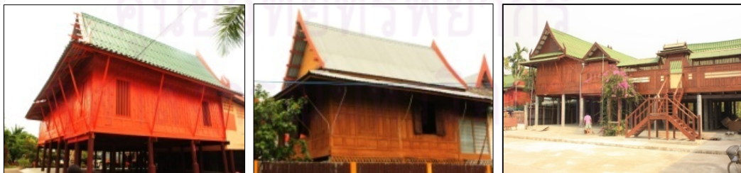
รูปที่ 5.3 แสดงบ้านที่มีการซ่อมแซมทั้งหลัง
