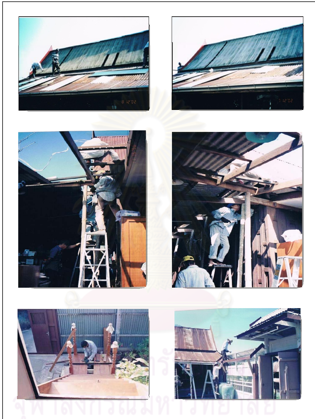
รูปที่ 5.15 แสดงการซ่อมแซมบ้านส่วนต่างๆ
