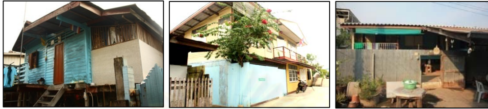
รูปที่ 5.4 แสดงบ้านที่มีการต่อเติมการต่อเติม
