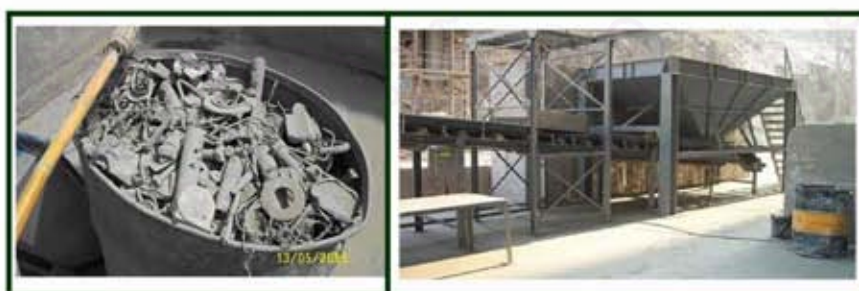
รูปที่ 5.1 เครื่องคัดแยกเศษเหล็กที่ PLANT CEMENT MILL LINE 1
