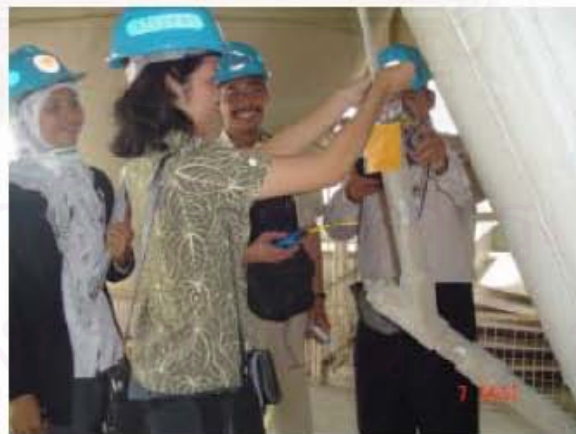
รูปที่ ข.17 การติดแผ่นป้ายพลาสติกบอกระดับการรั่วไหล
