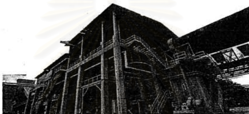
รูปที่ 3.23 Cooler
