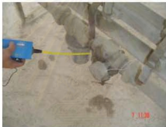
รูปที่ ข.13 การใช้สารเหลวในการตรวจจับการรั่วไหลของอากาศอัด
