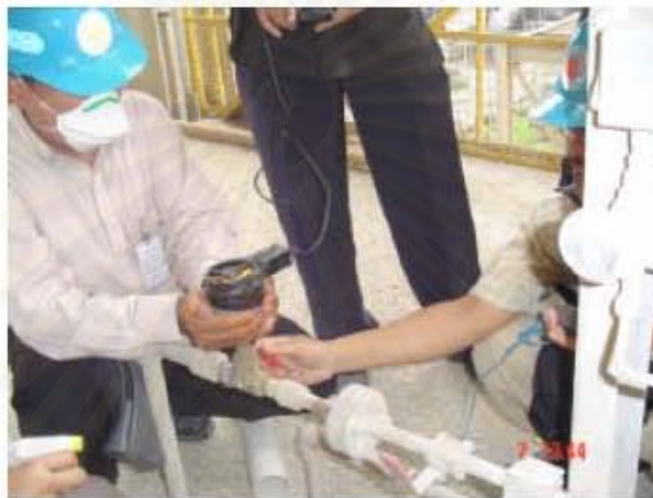
รูปที่ ข.16 การวัดการรั่วไหลของอากาศอัด
