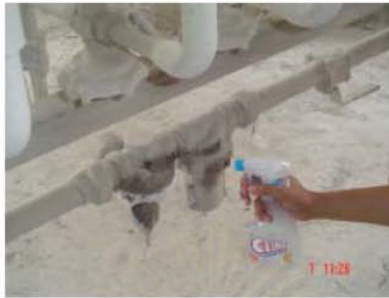
รูปที่ ข.13 การใช้สารเหลวในการตรวจจับการรั่วไหลของอากาศอัด
