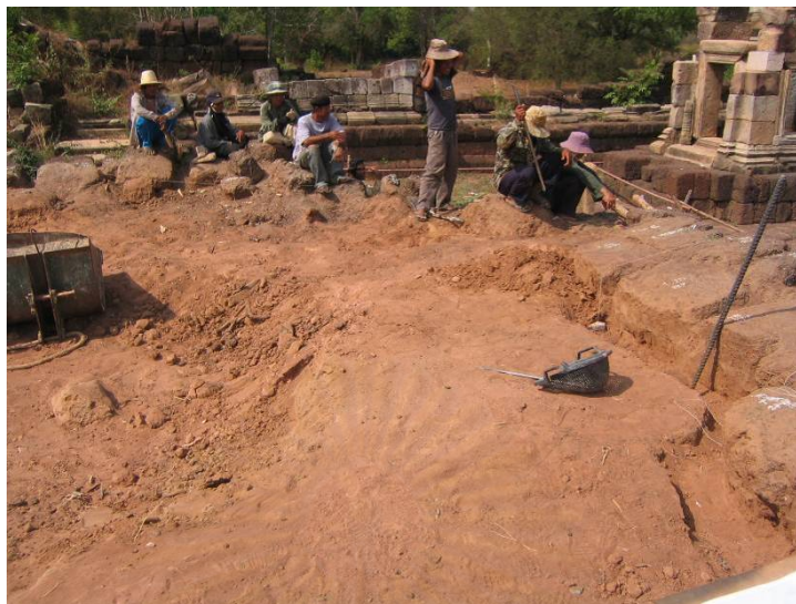
รูป 3-38 การขุดทรายอัดแน่นที่เป็นโครงสร้างภายในฐานศิลาแดงเดิมออก
