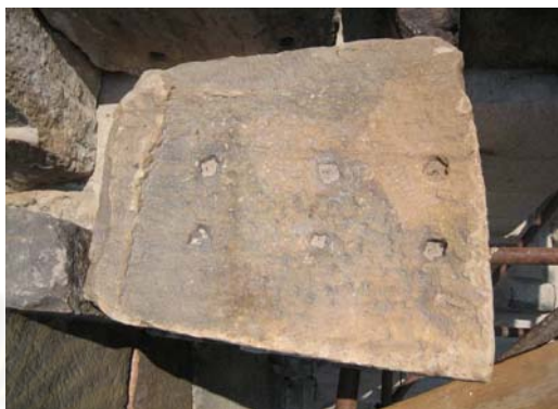
รูป 4-45 การนำหินรีจากเรือธามาทดลองเรียงก่อนการนำกลับสู่ที่ตั้งเดิมและเสริมหินใหม่ในที่ตั้งจริง
