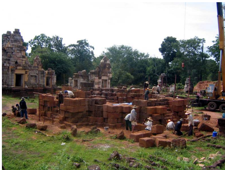
รูป 3-45 การนำศิลาแลงเดิมกลับมาเรียงที่ส่วนฐานปราสาท พร้อมด้วยการเสริมด้วยศิลาแลงใหม่ในส่วนที่ขาดหายไป
