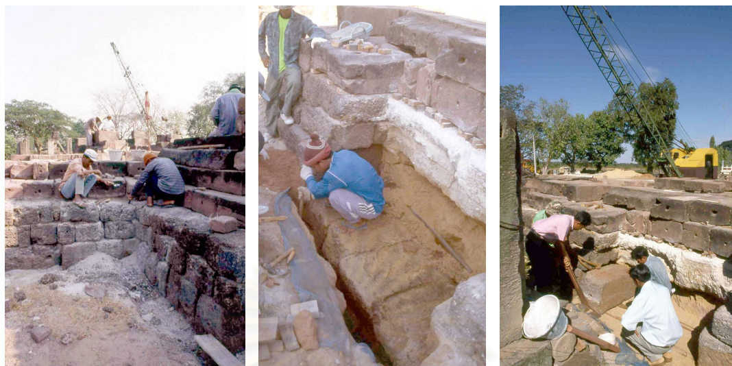
รูป 1-22 ถึง 1-24 การฝึกอบรมและการใช้โครงสร้างปูนชาวหมักที่ปราสาทพนมวัน
