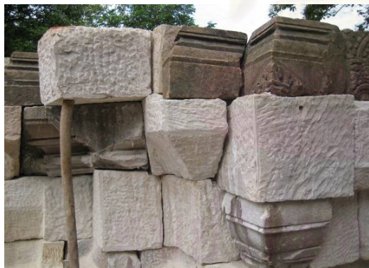
รูป 4-49 การทดลองเรียงที่ไม่ได้ซ่อมต่อหินก่อนจึงต้องค้ำยันไว้ รูป 4-50 หินใหม่ที่สกัดผิดควรเปลี่ยนใหม่ตั้งแต่การทดลองเรียง
