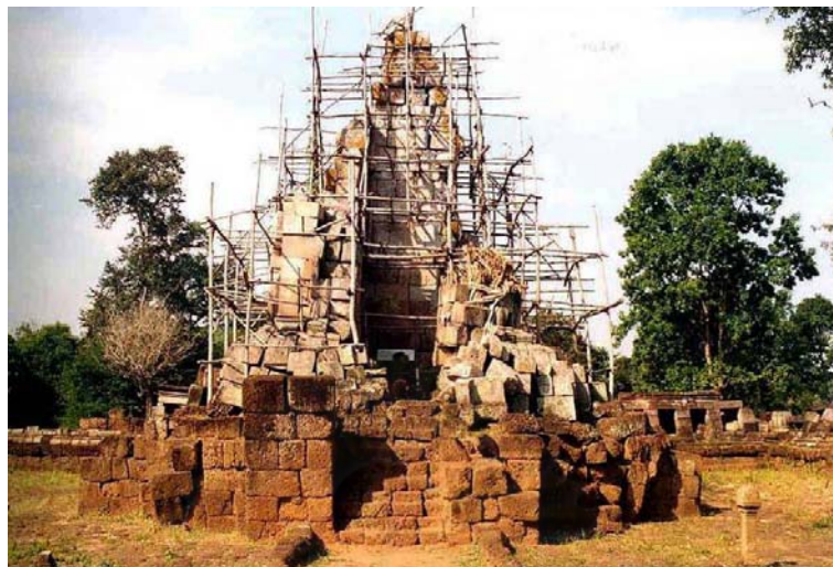
รูป 3-10 ปราสาทประธานหลังการขุดแต่ง
