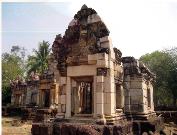
รูป 5-1 แบบบูรณะบรรณาลัยใต้ ผลการทดลองประกอบหินหล่นหน้าบันส่วนบนที่ไม่ได้นำชิ้นสู่ที่เดิมในช่วงแรก
