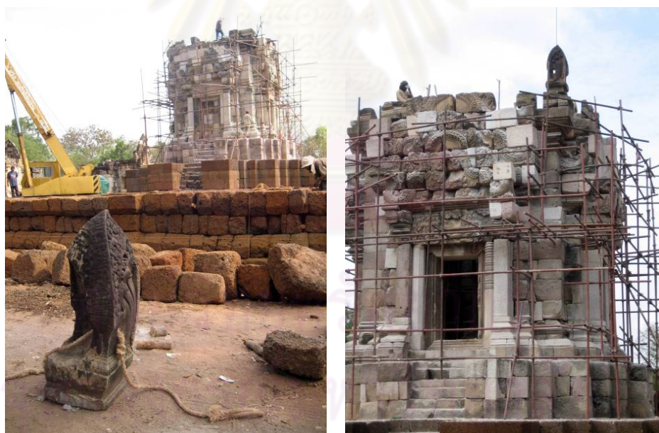
รูป 3-72 และ 3-73 การนำหินชุดหน้าบัน นาคบึก ของเรือนธาตุกลับเข้าสู่ที่ตั้งเดิมพร้อมด้วยการเสริมด้วยหินทรายใหม่
