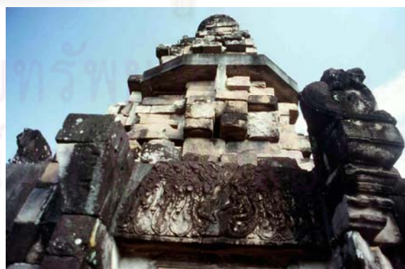
รูป 4-30 การเสริมโครงสร้างรับหินส่วนยอดที่ปราสาทนารายณ์เจงเวง
