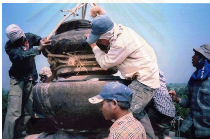
รูป 3 – 82 และ 3-83 การนำหินขึ้นไปประกอบยังที่ตั้งดั้งเดิมจนแล้วเสร็จถึงชั้นยอดสุด
