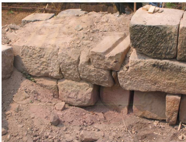
รูป 3-38 การขุดทรายอัดแน่นที่เป็นโครงสร้างภายในฐานศิลาแดงเดิมออก
