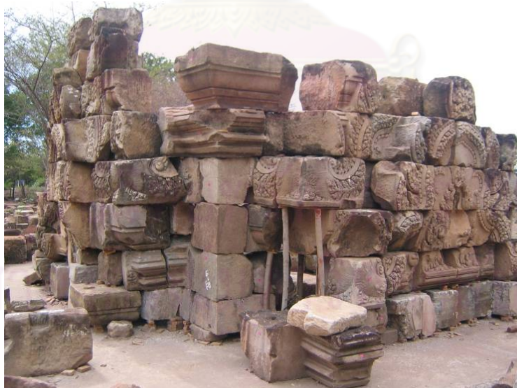
รูป 3-47 และ 3-48 หินเดิมที่รื้อออก นำมาทดลองประกอบกับหินหล่นเตรียมนำกลับคืนที่เดิมอีกครั้ง
