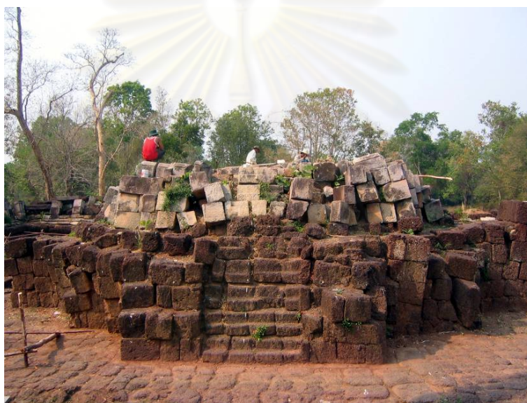
รูป 3- 36 และ 3- 37 ปราสาทประจัน ขณะดำเนินการถอดอิฐหินที่คงอยู่ในที่ลง
