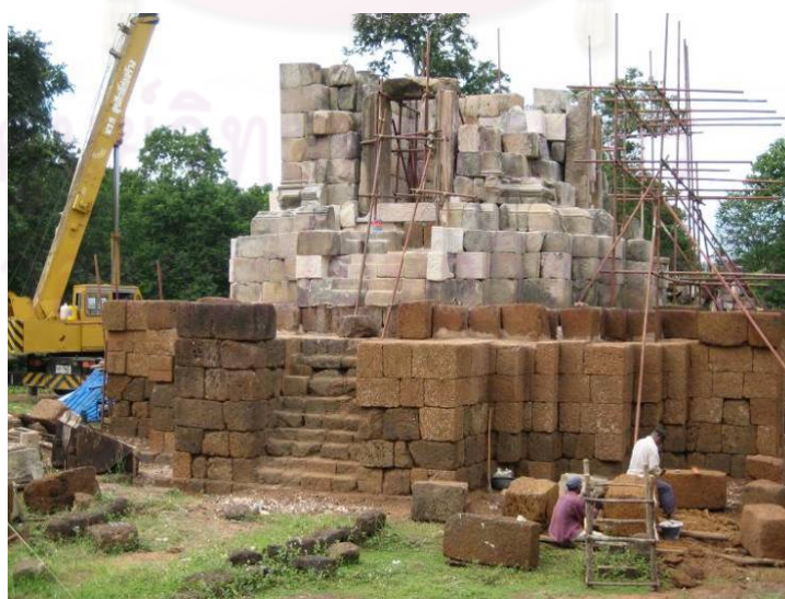
รูป 3-66 และ 3-67 เมื่อก่อเรียงส่วนฐานศิลาแลงเรียบร้อยก็ต่อกด้วยส่วนฐานหินทราย ในการดำเนินการต้องใช้ศิลาแลงและหินทรายใหม่มาทดแทนส่วนที่เสื่อมสภาพไป
