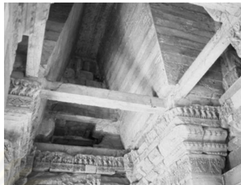
รูป 4-28 การเสริมโครงสร้างหลังคาที่ปราสาทพิมาย
