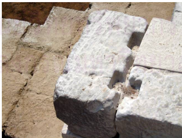
รูป 4-55 การใส่หินใหม่ ให้คำนึงถึงลักษณะพิเศษของหินก้อนที่ถูกแทนที่ ควรสกัดหินใหม่ให้เป็นร่องสำหรับเหล็กตัวปลิงด้วย
