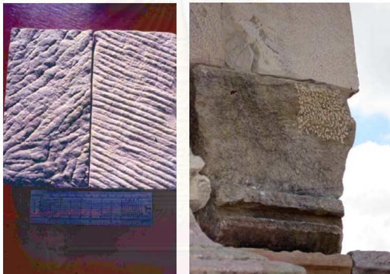
รูป 4-64 ด้านซ้ายคือฝีมือช่างขอม ด้านขวาคือข้อเสนอที่ปราสาทพนมวัน
