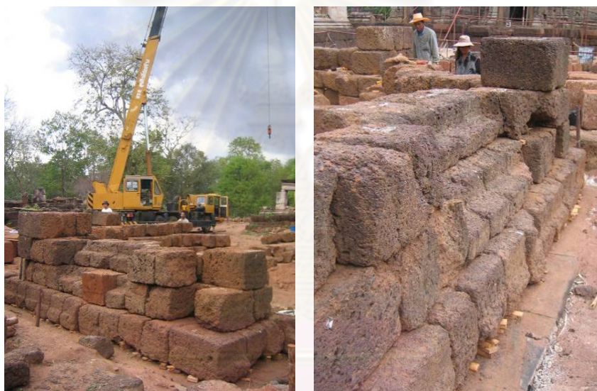
รูป 3-43 และ 3-44 การนำศิลาแลงเดิมกลับมาเรียงที่ส่วนฐานปราสาท
