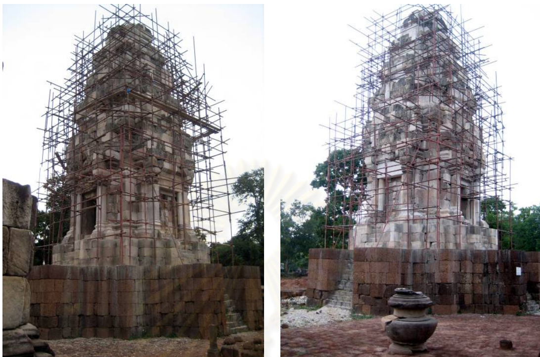
รูป 3-80 และ 3-81 การนำหินกลับขึ้นไปประกอบในส่วนยอดปราสาทจนถึงชั้นบน
