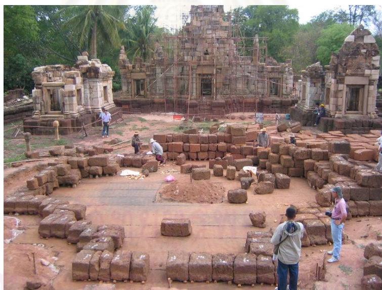
รูป 3-42 ฐานรากแม่ คสล. ปูทับด้วยแผ่นยางกันซึมก่อนนำศิลาแลงส่งฐานกลับมาเรียง
