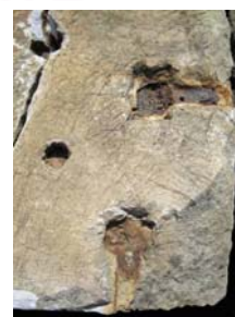
รูป 4-37 ถึง 4-39 ในการทำผังหินให้เก็บข้อมูลร่องรอย ตำแหน่งเหล็กยึด และข้อมูลอื่นๆ เป็นข้อมูลทางวิชาการด้วย
