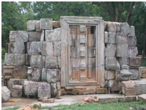
รูป 4-45 การนำหินรีจากเรือธามาทดลองเรียงก่อนการนำกลับสู่ที่ตั้งเดิมและเสริมหินใหม่ในที่ตั้งจริง
