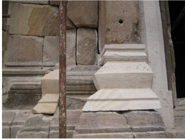
รูป 4-61 การสลักลวดบัวในลักษณะโกลนในช่วงแรกที่ได้เปลี่ยนแปลงให้มีความกลมกลืนมากขึ้น
