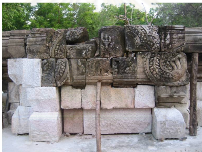
รูป 3-74 การทดลองเรียงหินและใส่หินใหม่ตาม shop drawing ที่พื้นดินก่อนไปประกอบในที่จริง
