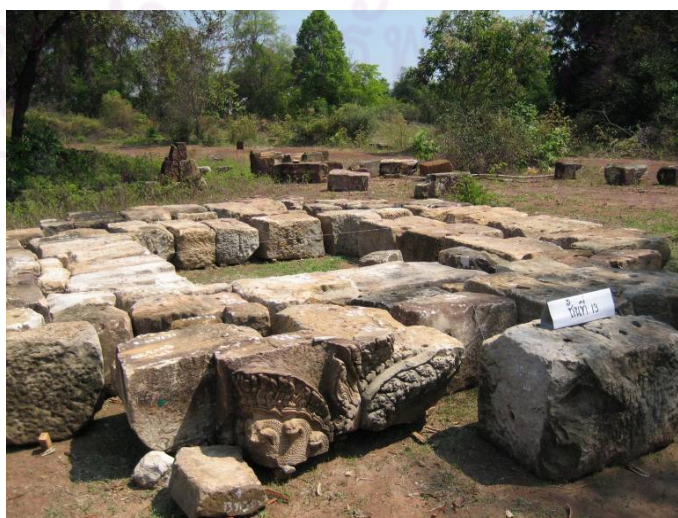
รูป 3-59 และ 3-60 การนำหินหน้าบันและจากการทดลองประกอบหินเพิ่มเติม มาทดลองเรียงกับหินหรือที่ละชั้นเพื่อทำ shop drawing
