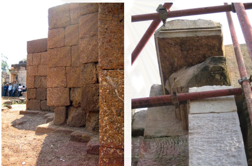
รูป 4-53 และ 4-54 ตัวอย่างกรณีที่ไม่ได้ซ้อมต่อหินก่อนนำขึ้นสู่ที่เดิม
