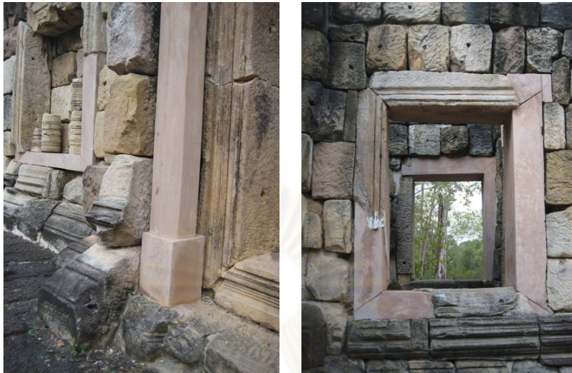
รูป 4-58 และ 4-59 การใช้ปูนแต่งสีให้ดูคล้ายหินทดแทนส่วนที่ขาดหายไปที่โคปุระตะวันออกชั้นนอก
