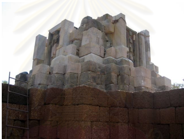
รูป 4-56 การปล่องหินใหม่ที่นำขึ้นไปประกอบไว้ในลักษณะโกลนก่อนสกัดแต่งในที่
