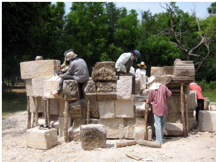
รูป 3-74 การทดลองเรียงหินและใส่หินใหม่ตาม shop drawing ที่พื้นดินก่อนไปประกอบในที่จริง
