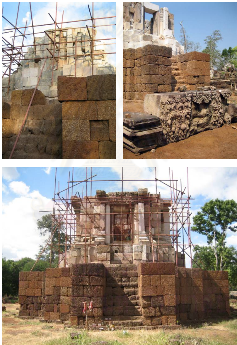
รูป 3-68 ถึง 3-70 การบูรณะผนังส่วนเรือนธาตุ นำทับหลังไปติดตั้งยังที่ตั้งเดิม
