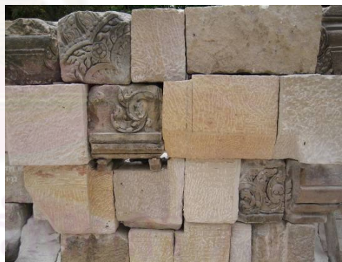
รูป 4-49 การทดลองเรียงที่ไม่ได้ซ่อมต่อหินก่อนจึงต้องค้ำยันไว้ รูป 4-50 หินใหม่ที่สกัดผิดควรเปลี่ยนใหม่ตั้งแต่การทดลองเรียง
