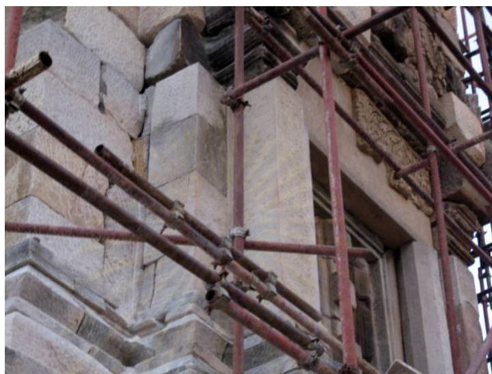
รูป 3-71 การติดตั้งทับหลังจำลองแบบจากส่วนชิ้นส่วนทับหลังจากพิพิธภัณฑสถานแห่งชาติ ปราจีนบุรี
