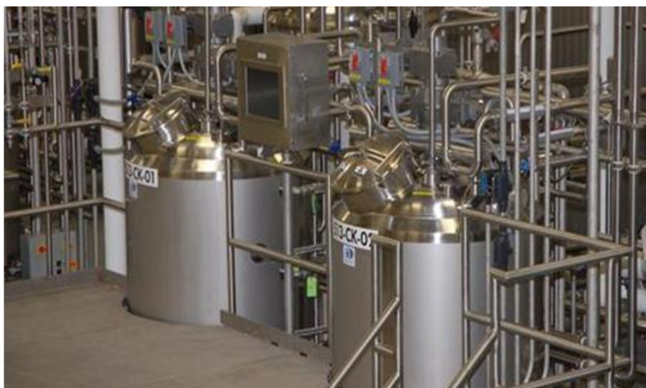
ภาพที่ 4.2 ชั้นโครงเหล็กรองรับถังผสม และถังจัดเก็บน้ำยา
