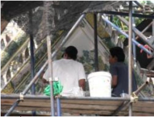
ภาพที่ จ.70 การแสดงขณะติดเศษถ้วยชาม กระเบื้องเคลือบหน้าบ้าน มณฑลพระพุท ธาบาทจำลอง
