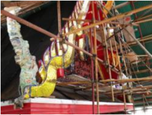
ภาพที่ ๑.61 การแสดงบูรณะซ่อฟ้า ไบระกา และหางหงส์ บูรณะเสร็จทำการปิดกระจกสี
