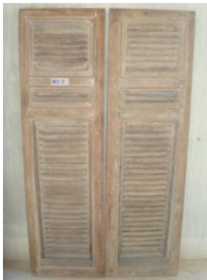
ภาพที่ 7.4 การแสดงผิวหน้าไม้บานประตูผุ เล็กน้อย
