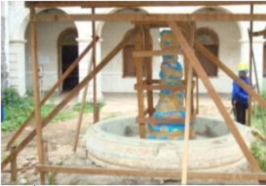
ภาพที่ ข.37 การแสดงป้องกันและเตรียมย้ายโบราณวัตถุ น้ำพุหินอ่อนเกาะสลักก่อนการบูรณะ
