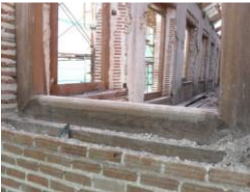
ภาพที่ ง.4 การแสดงไม้เหนือช่องเปิดที่ได้ทำการเปลี่ยนทดแทนไม้เดิมที่เสียหาย
