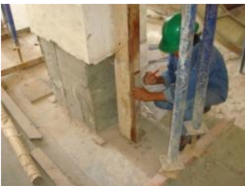
ภาพที่ ช.35 การแสดงซ่อมแซมวงกบไม้ เฉพาะส่วน
