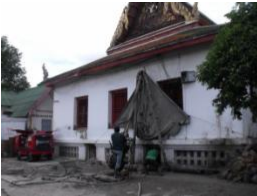
ภาพที่ ค.22 การแสดงเครื่องมือขุดเจาะ ดินด้านนอกอาคาร
