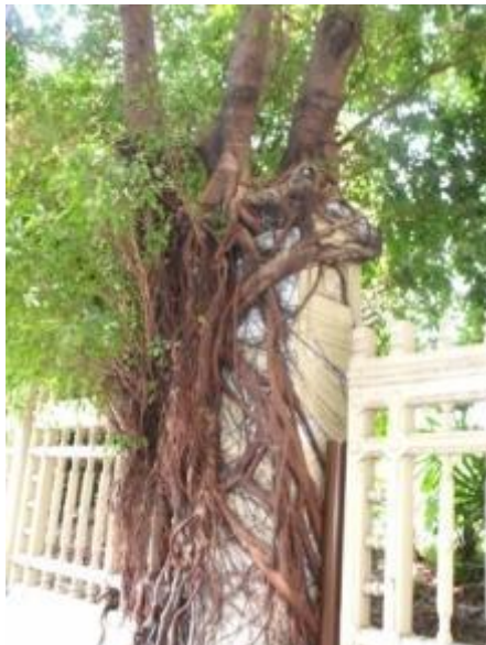
ภาพที่ ข.29 การแสดงรากต้นโพธิ์บนรางน้ำ หลังคาด้านนอกชอนไชรากเข้ามาในตัวอาคารตามร่องแตกร้าของผนังและทำลายผนังเพิ่ม
