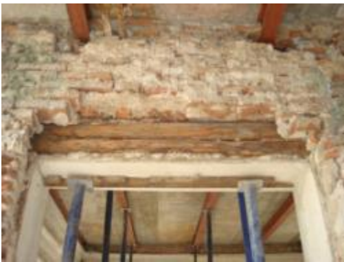
ภาพที่ ช.25 แสดงการติดตั้งคานไม้เหนือช่องเปิดบานประตูในอาคารโบราณสถาน
