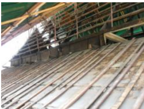
ภาพที่ ๑.50 การแสดงเปลี่ยนไม้จันทันและคานอะเสใหม่เพื่อทดแทนส่วนที่เสียหาย
