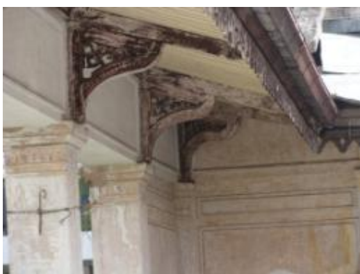
ภาพที่ 6.12 การแสดงความเสียหายของโครงหลังคาไม้
