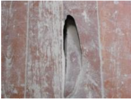
ภาพที่ 5.11 การแสดงความเสียหาย เนื่องจากตาไม้หลุดแตก
