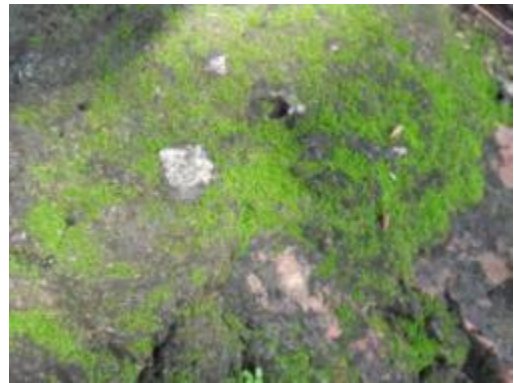
ภาพที่ 4.60 การแสดงผิวปูนฉาบผุกร่อน และมีพืชชั้นต่ำเจริญเติบโต
