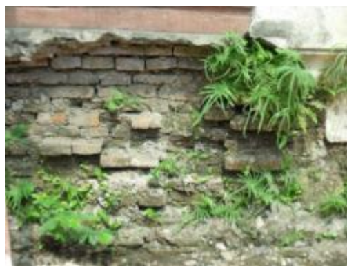
ภาพที่ ข.22 การแสดงลักษณะต้นไม้ขนาดเล็กเจริญเติบโตบนผนังก่ออิฐที่มีความชื้นสูง
