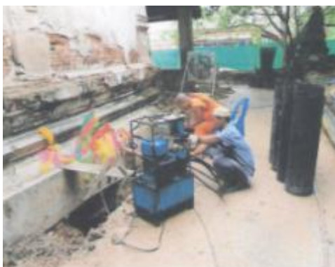
ภาพที่ ค.34 การแสดงเครื่องมือไฮดรอลิกกัดเสาเข็มเหล็กท่อนสั้น ๆ ท่อนละ 1-2 เมตร (ที่มา: บริษัทพีเนสต์ ซอยล์ เทสติ้ง จำกัด, 2554)
