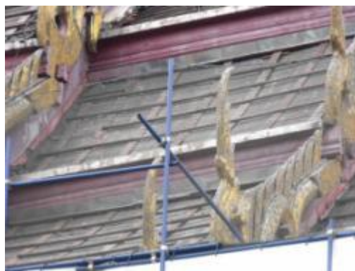
ภาพที่ ๕.77 การแสดงหลังจากรื้อถอน กระเบื้องหลังคาเสร็จ
