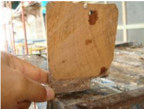
ภาพที่ ฉ.108 การแสดงปลายไม้เชิงชายส่วนที่เสียหายเนื้อไม้ภายในยังมีสภาพที่แข็งแรง
