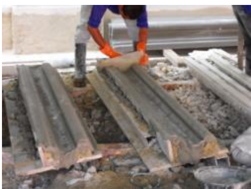
ภาพที่ ง.89 การแสดงกดแผ่นอะคริลิค ลง บนปูนเหลวแล้วลากพร้อมเติมปูนส่วนที่ไม่ สมบูรณ์
