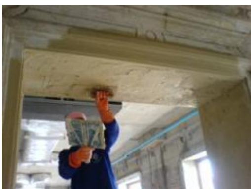
ภาพที่ ง.63 การแสดงฉาบปูนซ่อมบูรณะรอบช่องเปิด
