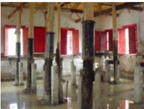
ภาพที่ ๑.19 การแสดงการรื้อถอนพื้นไม้และ คานไม้เดิมออกไปทั้งหมดก่อนบูรณะ
