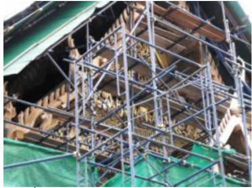
ภาพที่ ๑.10 การแสดงชุดลอกกระจกประดับ และยางรัดออกจาก ช่อฟ้า ใบระกา ทางหงส์ เพื่อไปตกแต่งผิวไม้
