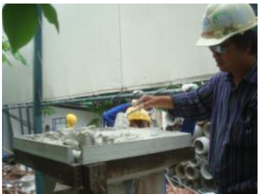
ภาพที่ ง.108 การแสดงติดตั้งบัวปูนปั้นสำเร็จ เทปูนแล้วตกแต่งให้ได้รูปร่างตามแบบ
