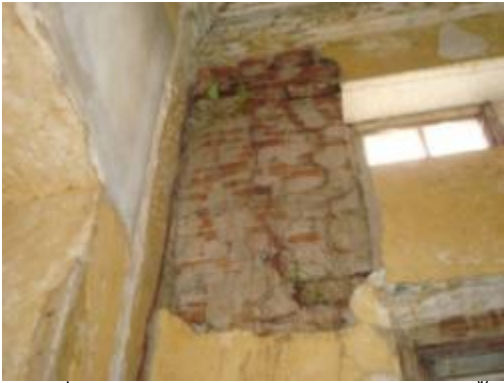
ภาพที่ ข.29 การแสดงรากต้นโพธิ์บนรางน้ำ หลังคาด้านนอกชอนไชรากเข้ามาในตัวอาคารตามร่องแตกร้าของผนังและทำลายผนังเพิ่ม
