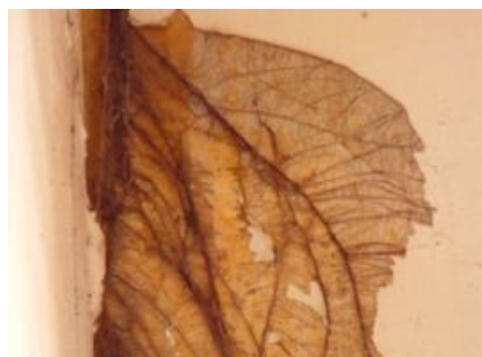
ภาพที่ ข.27 การแสดงรากของต้นโพธิ์แผ่แขนงรากฝอยซอนไขใต้แผ่นสีทาผนังปรากฏให้เห็นสีและผนังถูกทำลาย
