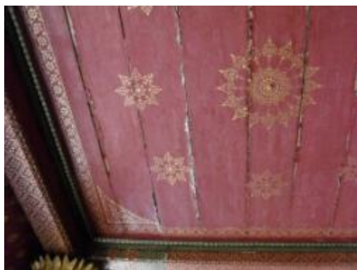
ภาพที่ 6.18 การแสดงวัสดุโป๊วผิวไม้เสื่อมสภาพ สีฝ้าเพดานซีด
