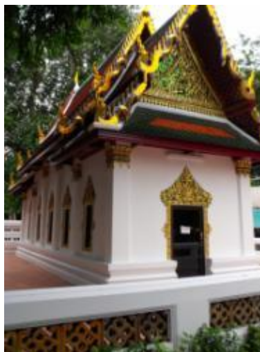
ภาพที่ ๑.71 การแสดงอาคารบูรณะแล้วเสร็จ
