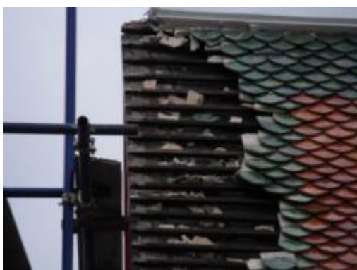
ภาพที่ ฉ.21 การแสดง การร้อยข้อฟ้า ไบระกาหางหงส์และกระเบื้องหลังคา
