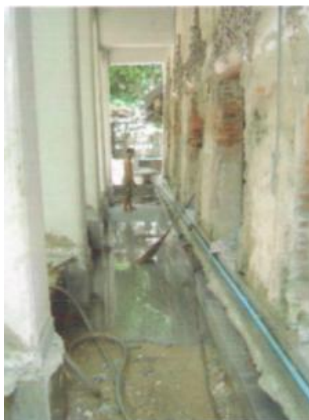
ภาพที่ ค.27 การแสดงเจาะพื้นรอบอาคารและขุดดินเพื่อดำเนินงานเสาเข็มและโครงสร้าง(ที่มา: บริษัทพีเนสต์ ซอยล์ เทสติ้ง จำกัด, 2551)
