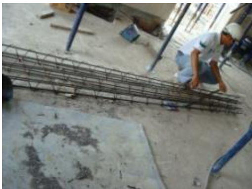
ภาพที่ ค.16 การแสดงเหล็กเส้นเสริมคอนกรีตภายในเสาเข็มเหล็ก โดยผู้กมัดเตรียมไว้ก่อนติดตั้ง
