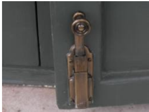
ภาพที่ ช.22 การแสดงติดตั้งอุปกรณ์ประตูใหม่ ผลิตภัณฑ์เลียนแบบอุปกรณ์เดิม
