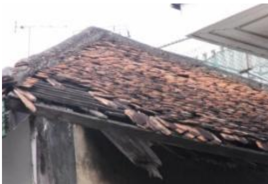
ภาพที่ 2.12 โครงหลังคาไม้ผุเสียหายอย่างรุนแรงเนื่องจากสาเหตุหลังคารั่ว
