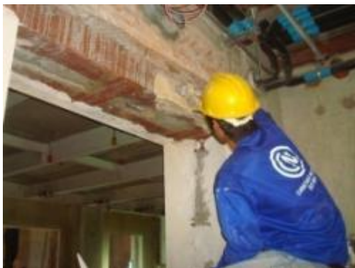
ภาพที่ ง.10 การแสดงฉาบปูนปิดหุ้มเหล็ก รูปพรรณที่เสริมแทนไม้เดิมที่ผู้
