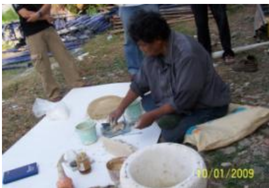
ภาพที่ ง.70 การแสดงทำปูนดำเพื่อใช้ซ่อมงานปูนปั้นที่เสียหาย
