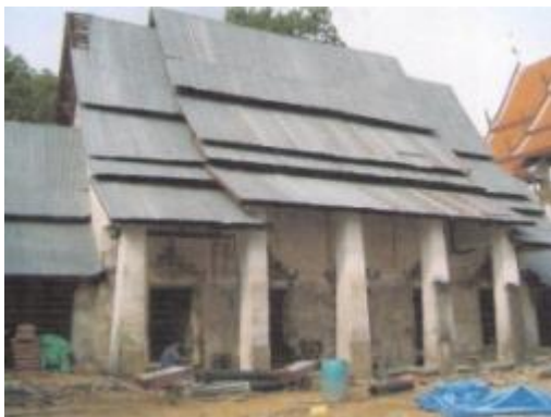
ภาพที่ 3.27 การแสดงรูปด้านข้างพระอุโบสถก่อนทำการยกอาคาร (ที่มา: บริษัทพีเนสต์ ซอยล์ เทสติ้ง จำกัด, 2551)
