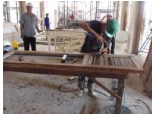
ภาพที่ ช.31 การแสดงซ่อมเกล็ดไม้บานประตูใช้เกล็ดไม้ใหม่เพื่อทดแทนไม้เดิมที่เสียหาย
