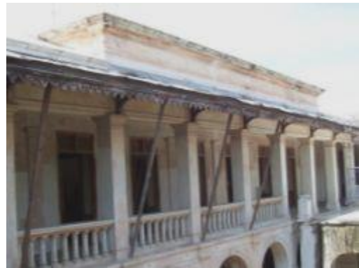
ภาพที่ ข.9 การแสดงค้ำยันโครงหลังคาชั่วคราวก่อนบูรณะเนื่องจากสภาพโครงหลังคาเดิมมีสภาพไม่แข็งแรง
