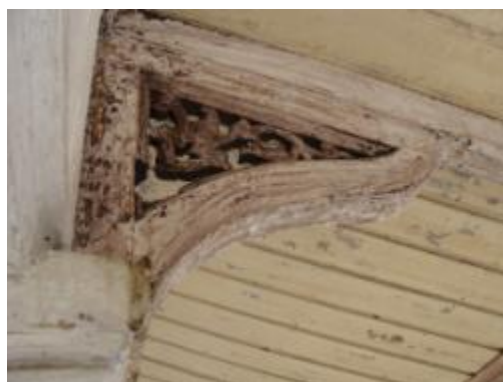
ภาพที่ 6.14 การแสดงความเสียหายของจันทัน
