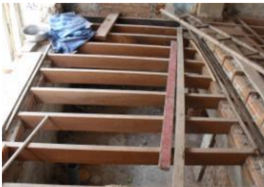
ภาพที่ จ.32 การแสดงประกอบคานไม้ใหม่ ตามรูปแบบและเทคนิคดั้งเดิมยึดคานไม้ ด้วยการก่ออิฐมอญค้ำยันด้านข้าง
