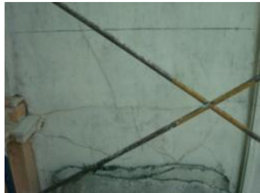
ภาพที่ 4.39 การแสดงลักษณะความ เสียหายของผนังฉาบปูนมีรอยร้าวเล็กน้อย
