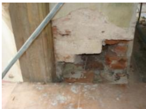
ภาพที่ ง.12 การแสดงสกัดอิฐรับแรงที่เสียหายออกไปเพื่อเปลี่ยนอิฐก้อนใหม่
