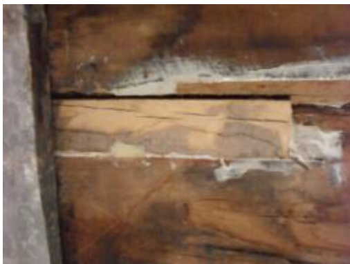
ภาพที่ จ.27 การแสดงวิธีการซ่อมไม้กระดาน พื้นที่เสียหายบางส่วน โครงการบูรณะหอ พระไตรปิฎก วัดเทพธิดารามวรวิหาร
