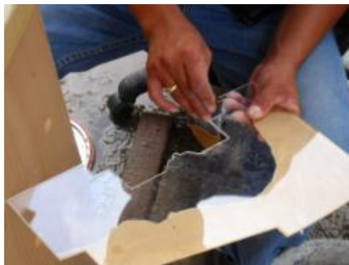
ภาพที่ ง.85 การแสดงตัดแผ่นอะคริลิคตามขนาดบัวปูนปั้นเดิมเพื่อใช้เป็นแบบหล่อบัวปูนปั้น
