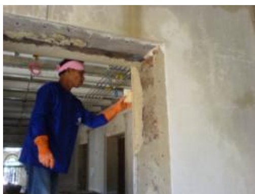
ภาพที่ ง.59 การแสดงจับเชื่อมรอบช่องเปิด
