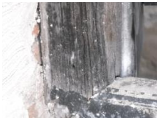
ภาพที่ 7.32 การแสดงวงกบประตูเนื้อไม้ผู้เสียหายมาก
