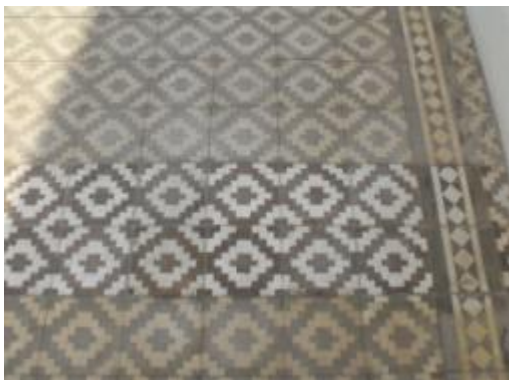
ภาพที่ ๑.45 การแสดงซ่อมเปลี่ยนกระเบื้องพื้นเฉพาะตำแหน่งที่เกิดความเสียหาย
