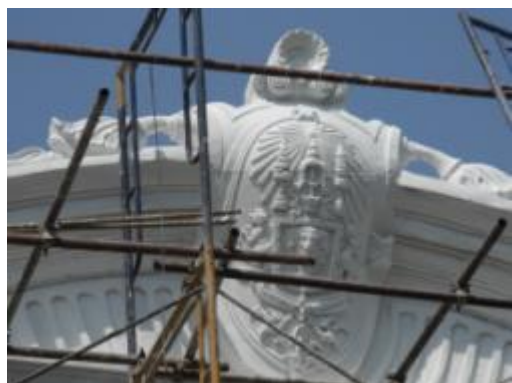
ภาพที่ ง.99 การแสดงติดตั้งปูนปั้นหล่อสำเร็จรูป
