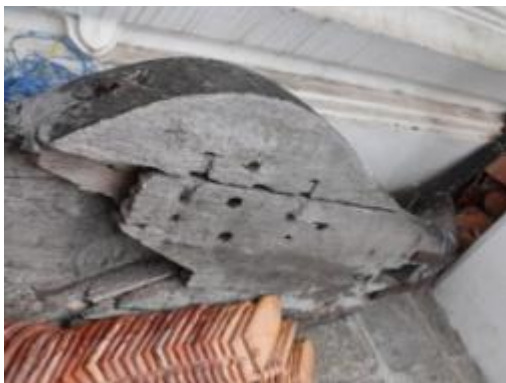
ภาพที่ 6.9 การแสดงข้อฟ้า ฝุเสียหาย ทั้งหมด
