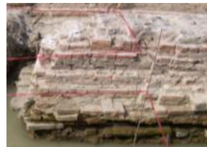
ภาพที่ ๑๗.20 การแสดงฐานรากก่ออิฐวางบนไม้กระดานใต้ไม้กระดานเป็นเสาเข็มไม้ ฐานรากอาคารพระราชวังสราญรมย์ เริ่มก่อสร้างในสมัยรัชกาลที่ 4
