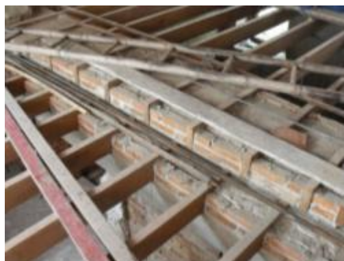
ภาพที่ จ.31 การแสดงประกอบคานไม้ใหม่ ตามรูปแบบและเทคนิคดั้งเดิม
