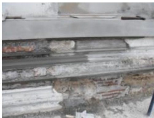
ภาพที่ ง.15 การแสดงก่ออิฐใหม่เสริม ทดแทนอิฐเดิมที่เสียหาย
