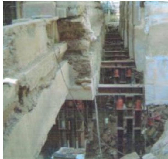
ภาพที่ ค.52 การแสดงเครื่องมือไฮดรอลิกขณะทำการยกอาคาร (ที่มา: บริษัทพีเนสต์ ซอยล์ เทสติ้ง จำกัด, 2551)
