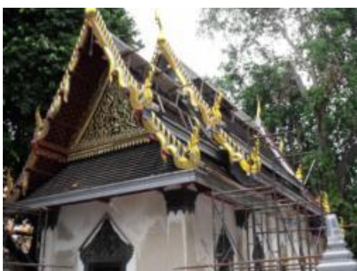
ภาพที่ ๑.69 การแสดงภายหลังการซ่อมบูรณะ ซ่อฟ้า ไบระกา และหางหงส์
