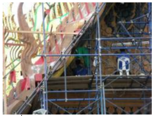
ภาพที่ ๗.๘๓ การแสดงบูรณะข้อฟ้า ไบระกา และหน้าบันไม้แกะสลัก
