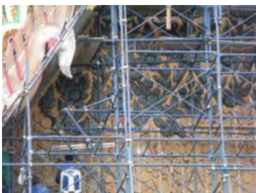
ภาพที่ ๘.๘๕ การแสดงทาสีไม้แกะสลัก หน้าบัน
