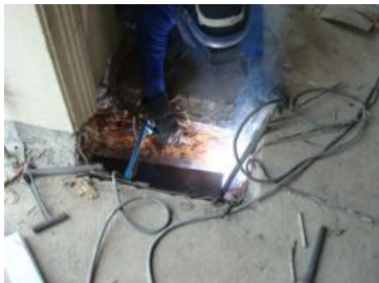
ภาพที่ ค.18 การแสดงเชื่อมติดตั้งคานเหล็กบนหัวเสาเข็ม
