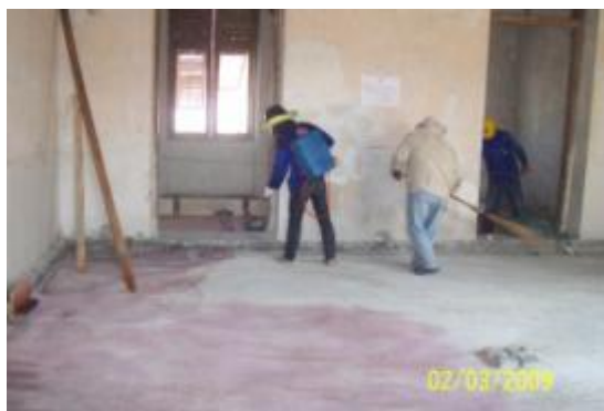
ภาพที่ จ.44 การแสดงเทคอนกรีตพื้นเสร็จ และทำการพ่นน้ำยาบ่มคอนกรีต
