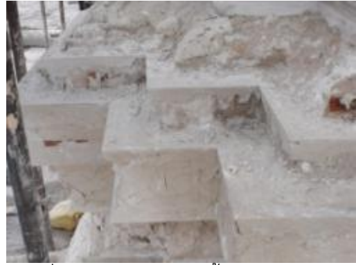
ภาพที่ ง.128 การแสดงเชื่อมโครงร่างก่อน ฉาบตกแต่งฐานซุ้มประตู
