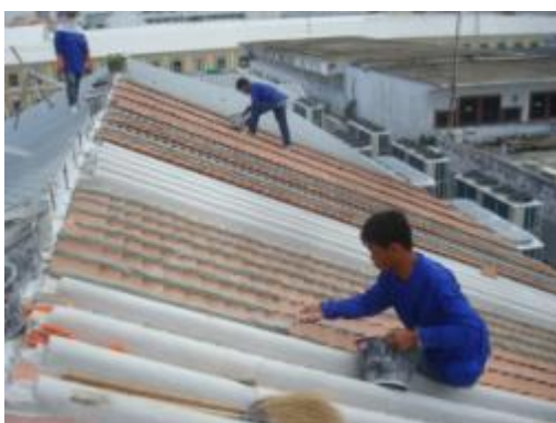
ภาพที่ ฉ.134 การแสดงปูนปั้นรอยต่อกระเบื้องดินเผา
