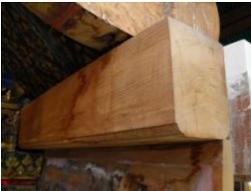
ภาพที่ ๑.14 การแสดงไม้คานอะเสเปลี่ยน ไม้ใหม่ทดแทนไม้เดิมที่ผุเสียหาย
