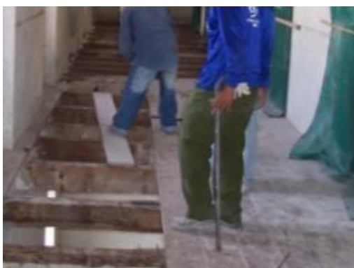
ภาพที่ จ.36 การแสดง การรื้อถอนคานไม้เนื่องจากผุเสียหายและปลวกกัดกิน
