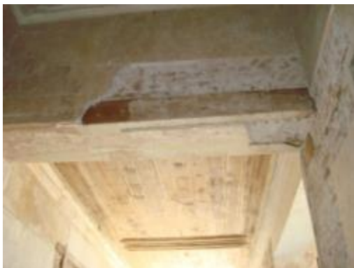
ภาพที่ 4.55 การแสดงปูนฉาบทับบนท่อนไม้ ปูนฉาบหลุดร่วง
