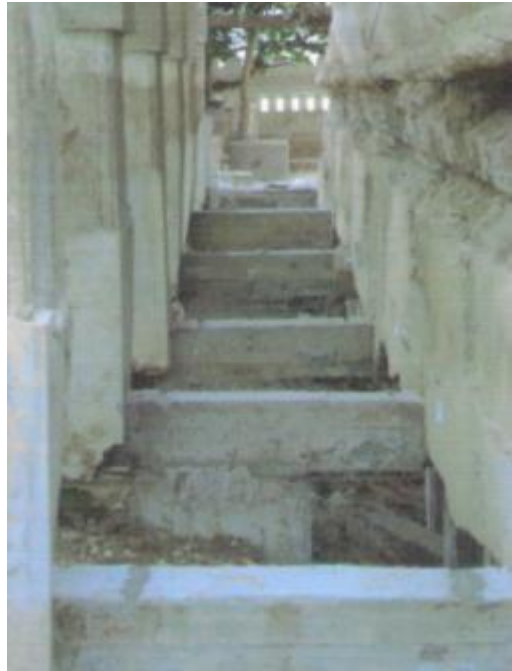
ภาพที่ ค.56 การแสดงต่อม่อและคานเหล็ก ภายหลังเทคอนกรีตป้องกันสนิม (ที่มา: บริษัทพีเนสส์ ซอยล์ เทคโนโลยี จำกัด, 2551)
