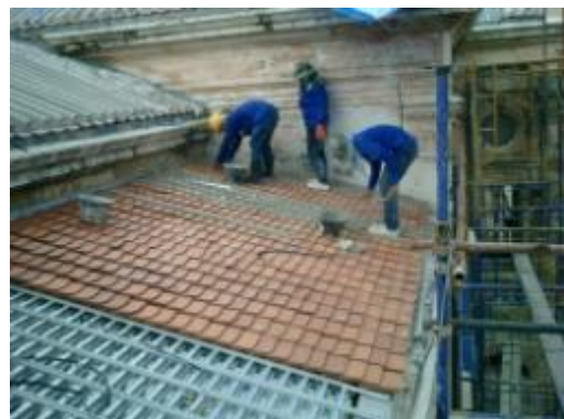
ภาพที่ ฉ.132 การแสดงติดตั้งแปสำเร็จรูป เหล็กชุบสังกะสีและมุงกระเบื้องดินเผา
