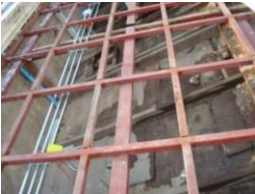
ภาพที่ ฉ.114 การแสดงเสริมเหล็กรูปพรรณ กับโครงไม้เดิม
