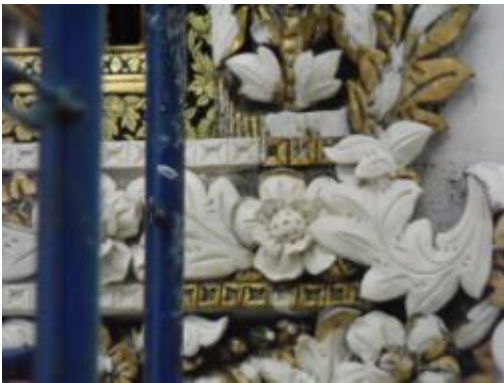
ภาพที่ ง.75 การแสดงช่อมแซมปูนปั้น บางส่วนที่เสียหาย
