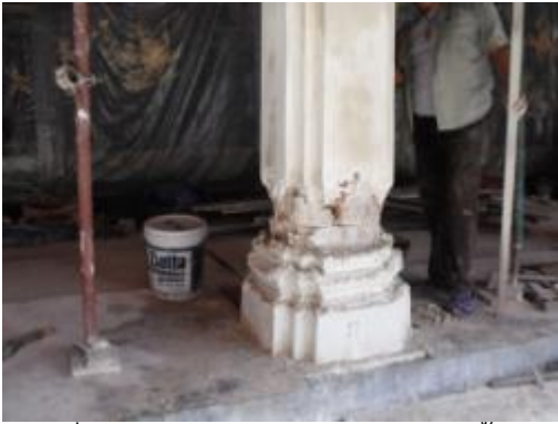
ภาพที่ ง.121 การแสดงฉาบปูนและปั้นบัว เสาส่วนบนด้วยการเชื่อมปูนและฉาบในที่
