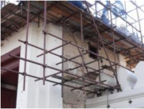
ภาพที่ ง.49 การแสดงสกัดปูนฉาบที่ เสื่อมสภาพออกไป
