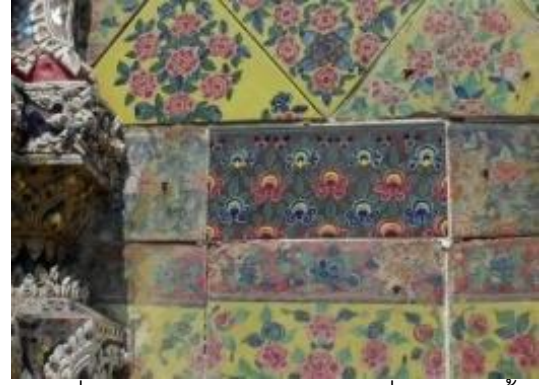
ภาพที่ จ.65 การแสดงซ่อมเปลี่ยนกระเบื้อง เฉพาะตำแหน่งที่เสียหาย
