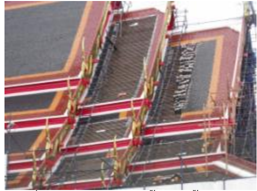
ภาพที่ ๗.๘๑ การแสดงติดตั้งกระเบื้องหลังคา
