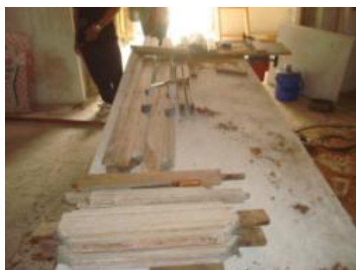
ภาพที่ ข.25 การแสดงถอดชิ้นไม้บานประตูเดิมเพื่อซ่อมบูรณะใหม่ เปลี่ยนไม้ที่เสียหายด้วยไม้ใหม่
