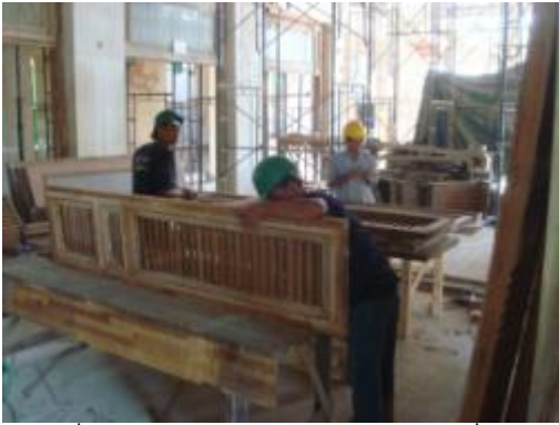
ภาพที่ ช.33 การแสดงตอกยึดไม้เพิ่มเติม ภายหลังการประกอบเกล็ดไม้เสร็จ
