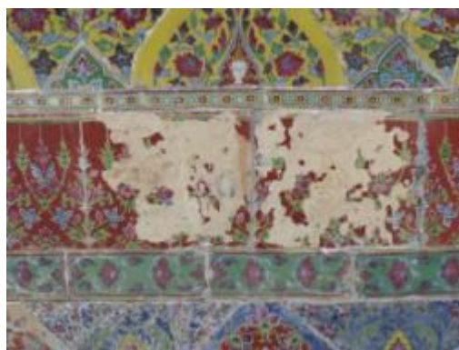
ภาพที่ 5.42 การแสดงผิวกระเบื้องเซรามิค ผิวหน้าสีกร่อนเสียหาย
