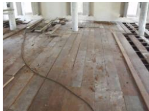
ภาพที่ ๑.20 การแสดงไม้เดิมติดตั้งใหม่ โครงการบูรณะการเปรียญวัดมหารวมพาราม
