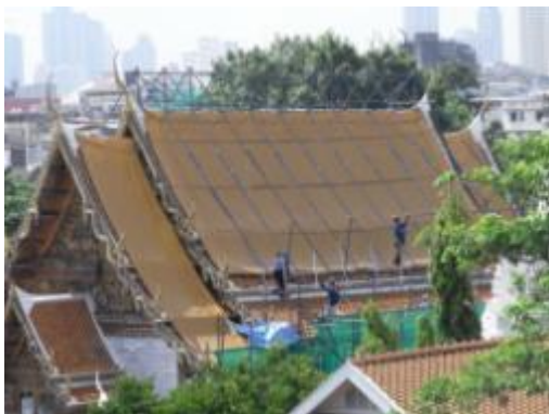
ภาพที่ ๑.4 การแสดงคลุมผ้าใบไว้ชั่วคราว เพื่อป้องกันน้ำฝนก่อนบูรณะอาคาร
