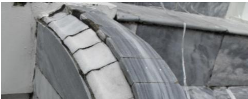
ภาพที่ 5.32 การแสดงหินอ่อนที่อยู่ด้านนอกอาคารเกิดการสีกร่อนที่ผิวเนื่องจากฝนกรด
