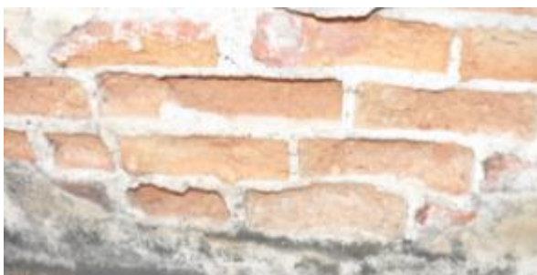
ภาพที่ 4.14 การแสดงลักษณะความเสียหายของผนังก่ออิฐรับแรงเนื้ออิฐกร่อนเป็นผง
