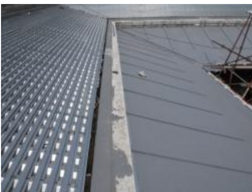
ภาพที่ ฉ.115 การแสดงติดตั้งแผ่นไฟเบอร์ ซีเมนต์เพื่อป้องกันน้ำรั่วจากกระเบื้องหลังคา และทาเคมีภัณฑ์กันซึมผิวด้านบนให้ทั่วทุก บริเวณ
