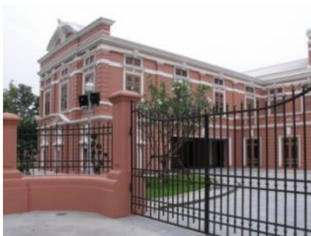
ภาพที่ 6.17 การแสดงโครงสร้างส่วนมุขทิศใต้ดำเนินการก่อสร้างขึ้นมาใหม่ทั้งหมด
