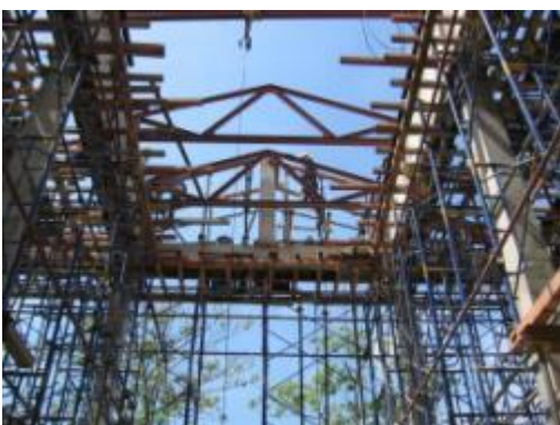
ภาพที่ จ.125 การแสดงติดตั้งโครงเหล็ก
