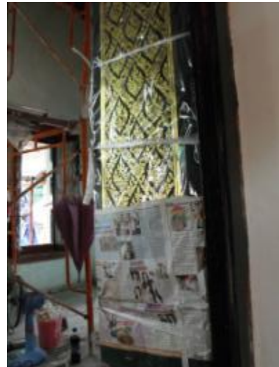
ภาพที่ ช.17 การแสดงบานประตูลายรดน้ำ บูรณะแล้วเสร็จ
