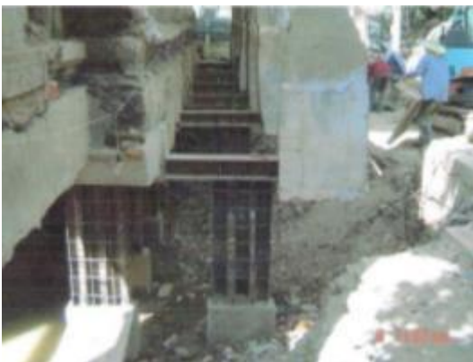
ภาพที่ ค.53 การแสดงดมเหล็กเมื่อยกอาคารแล้วเสร็จ (ที่มา: บริษัทพีเนสต์ ซอยล์ เทสติ้ง จำกัด, 2551)
