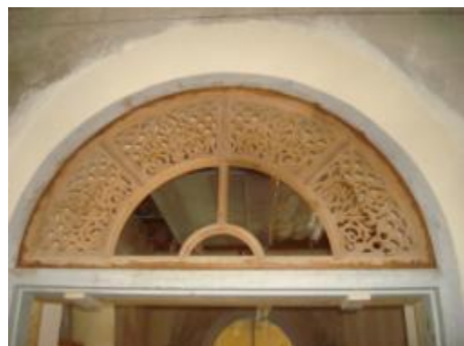
ภาพที่ ช.38 การแสดงติดตั้งลายไม้ฉลุ
