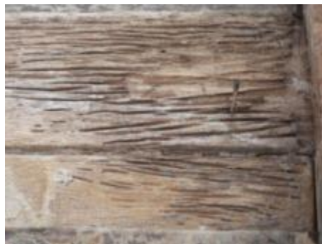
ภาพที่ 5.28 การแสดงลักษณะผิวไม้ที่ เสียหายมากเนื่องจากปลวกกัดกิน
