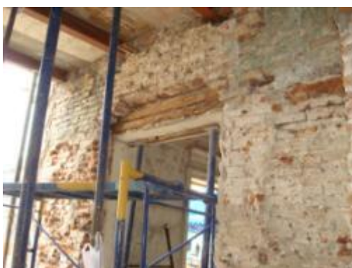
ภาพที่ ข.8 การแสดงค้ำยันผนังช่องเปิดและพื้นโครงสร้างอาคารเพื่อป้องกันการพังทลายก่อนบูรณะ
