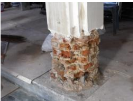
ภาพที่ ง.123 การแสดงสกัดฐานเสาปูน เสื่อมสภาพออกไปเพื่อบูรณะใหม่
