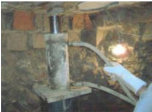
ภาพที่ ค.33 การแสดงใช้แม่แรงกัดเสาเข็ม เหล็กใต้ผนังอาคาร (ที่มา: บริษัทพีเนสต์ ซอยล์ เทสติ้ง จำกัด, 2551)
