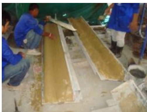
ภาพที่ ง.86 การแสดงเททรายในกล่องไม้เพื่อเป็นแบบหล่อบัวปูนปั้นสำเร็จ
