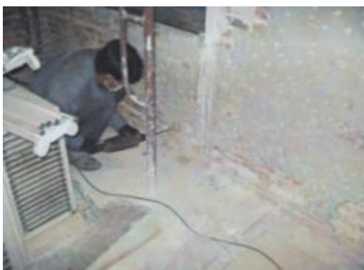
ภาพที่ ง.1 การแสดงเจาะผนังเพื่อฉีดสารเคมีลดความชื้นของผนัง (ที่มา: ศิวกร การช่าง จำกัด, 2552)
