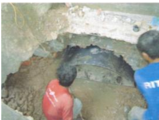
ภาพที่ ค.29 การแสดงเจาะและติดตั้งแผ่นเหล็กบางโครงสร้างถ่ายแรง(Arch) (ที่มา: บริษัทพีเนสต์ ซอยล์ เทสติ้ง จำกัด, 2551)
