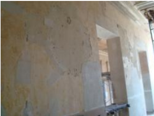
ภาพที่ 4.36 การแสดงผนังฉาบปูนผิวหน้า ล่อนสีกร่อนเล็กน้อยและมีรอยร้าวเล็กน้อย
