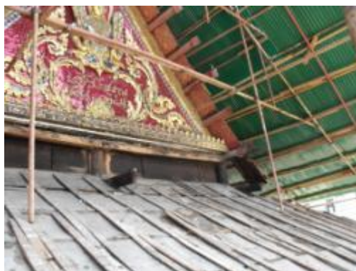
ภาพที่ ๓.๔๑ การแสดงโครงหลังคา ก่อนการ บูรณะ
