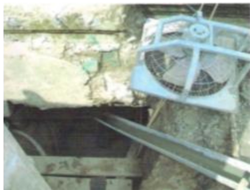
ภาพที่ ค.35 การแสดงเทคอนกรีตในท่อ เสาเข็มเหล็ก (ที่มา: บริษัทพีเนสต์ ซอยล์ เทสติ้ง จำกัด, 2551)
