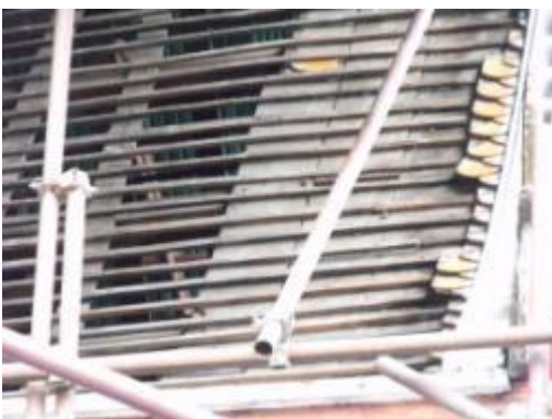
ภาพที่ ๑.65 การแสดงรั้วกระบือองมุงหลังคาและเตรียมติดตั้งแผ่นกันซึม
