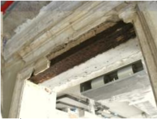
ภาพที่ 4.62 การแสดงปูนฉาบตกแต่งบนผิวไม้หลุดร่วงเสียหายเนื่องจากไม้ผุเสียหายมาก
