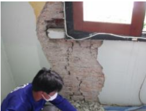
ภาพที่ ค.5 การแสดงสกัดปูนฉาบเดิมรอบรอยร้าวออกไป ตำแหน่งผนังชั้นที่ 2
