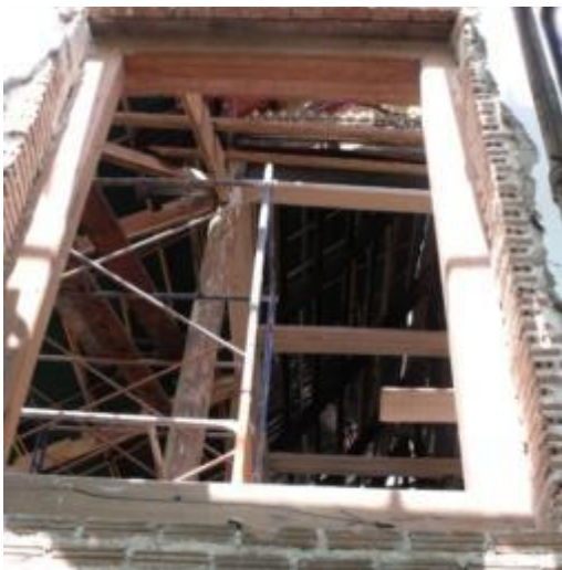
ภาพที่ ข.43 การแสดงติดตั้งวงกบไม้ใหม่
