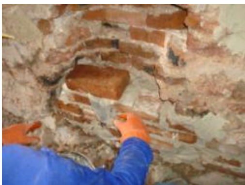
ภาพที่ ง.14 การแสดงก่ออิฐใหม่เสริม ทดแทนอิฐเดิมที่เสียหาย
