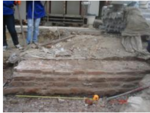
ภาพที่ ข.73 การแสดงแนวคลองฐานรากอาคาร เก่า ทำการศึกษาด้านโบราณคดีก่อนก่อสร้าง อาคารใหม่บริเวณฐานรากเดิม
