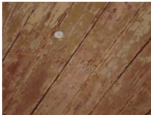
ภาพที่ 6.23 การแสดงฝ้าเพดานมีร่องไม้ เนื่องจากการกัดตัวของไม้เพราะสูญเสีย ความชื้น
