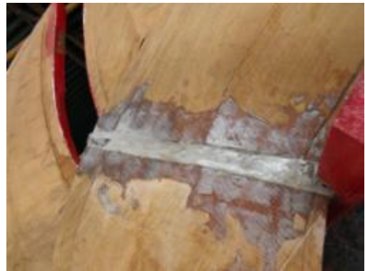
ภาพที่ ฉ.59 การแสดงรอยต่อไม้ด้วยวัสดุ โป๊วไม้
