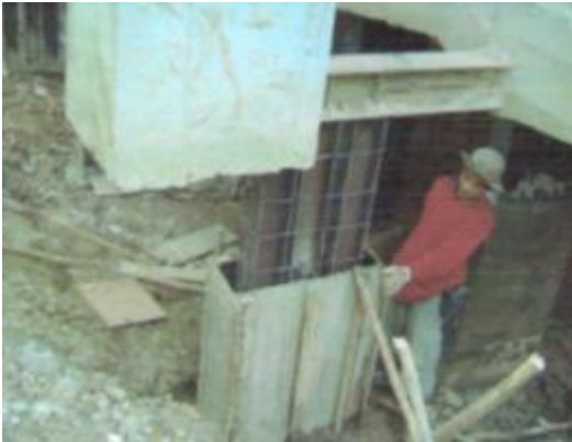
ภาพที่ ค.54 การแสดงการเข้าแบบเตรียมเทคอนกรีตต่อม่อป้องกันสนิม (ที่มา: บริษัทพีเนสส์ ซอยล์ เทคโนโลยี จำกัด, 2551)
