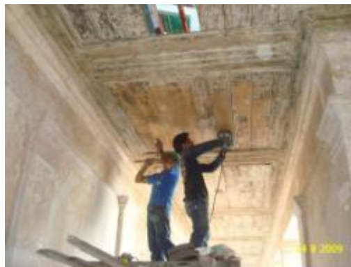
ภาพที่ ฉ.156 การแสดงตัดผิวไม้ด้วยเครื่องขัดสายพาน
