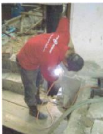
ภาพที่ ค.41 การแสดงต่อเสาเข็มเหล็กกลมเส้นผ่าศูนย์กลาง 20 เซนติเมตร(ที่มา: บริษัทพีเนสส์ ซอยล์ เทคโนโลยี จำกัด, 2551)
