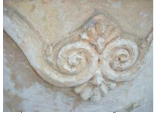
ภาพที่ 4.75 การแสดงผิวหน้าปูนปั้นสี กร่อน ตำแหน่งผนังด้านนอกอาคาร โบราณสถาน
