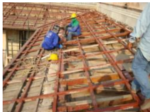
ภาพที่ ฉ.112 การแสดงเสริมเหล็กรูปพรรณกับโครงไม้เดิม
