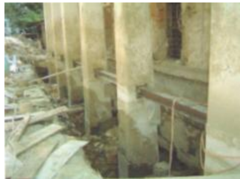
ภาพที่ ค.45 การแสดงยึดเสาดิมให้มั่นคงระหว่างการยกอาคาร (ที่มา: บริษัทพีเนสส์ ซอยล์ เทคโนโลยี จำกัด, 2551)
