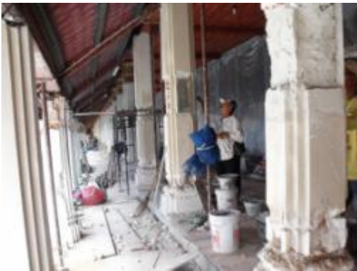
ภาพที่ ง.122 การแสดงฉาบปูนและปั้นบัว เสาส่วนบนด้วยการเชื่อมปูนและฉาบในที่
