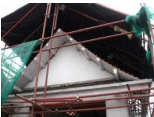
ภาพที่ ๑.๙๘ การแสดงหลังคาภายหลังการเปลี่ยนไม้จันทัน คานอะเสและติดตั้งแประแนงเสร็จ
