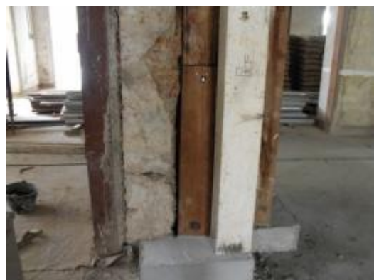
ภาพที่ ง.9 การแสดงเหล็กรูปพรรณเสริมทดแทนไม้และการใช้เสาไม้เชื่อมต่อไม้ส่วนที่ดีไว้เพื่อเป็นหลักฐานทางโบราณคดี
