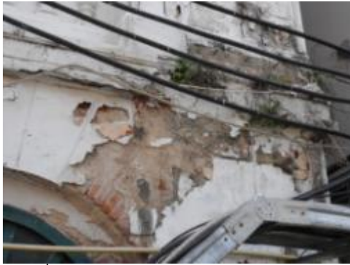
ภาพที่ 4.56 การแสดงผิวปูนฉาบผุกร่อน และมีพืชเจริญเติบโต
