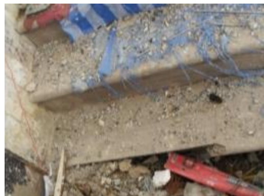
ภาพที่ ๑.16 การแสดงความเสียหายของไม้แตกหัก
