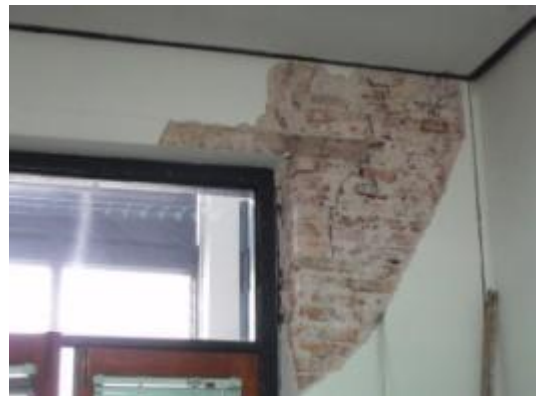
ภาพที่ ค.6 การแสดงสกัดปูนฉาบเดิมรอบรอยร้าวออกไป ตำแหน่งผนังชั้นที่ 2
