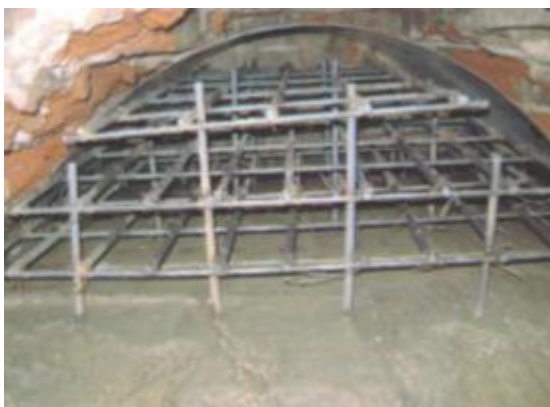
ภาพที่ ค.30 การแสดงติดตั้งเหล็กเสริมโครงสร้างถ่ายแรง(Arch) (ที่มา: บริษัทพีเนสต์ ซอยล์ เทสติ้ง จำกัด, 2551)
