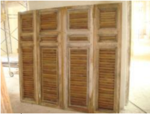
ภาพที่ ช.13 การแสดงไป้วแต่งและซัดผิว เสร็จเตรียมติดตั้งบานประตู
