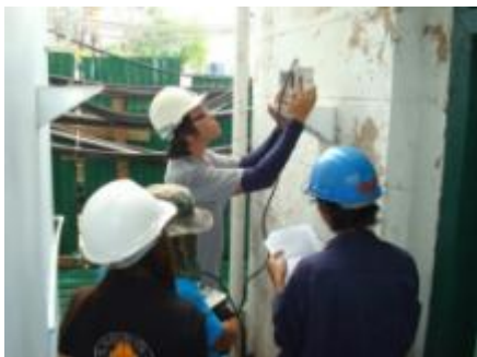
ภาพที่ 2.17 อุปกรณ์ Tiltmeter ขณะวัดค่าการเอียงตัวของอาคารโบราณสถาน อาคารวิภาค ภูวดล
