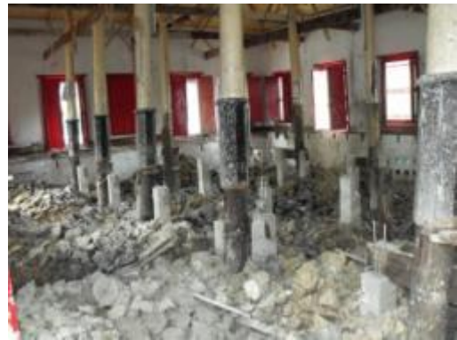
ภาพที่ ค.24 การแสดงดินจากการเจาะ เสาเข็มปริมาตรหลายลูกบาศก์เมตร มีการ ขนย้ายออกไปภายหลัง
