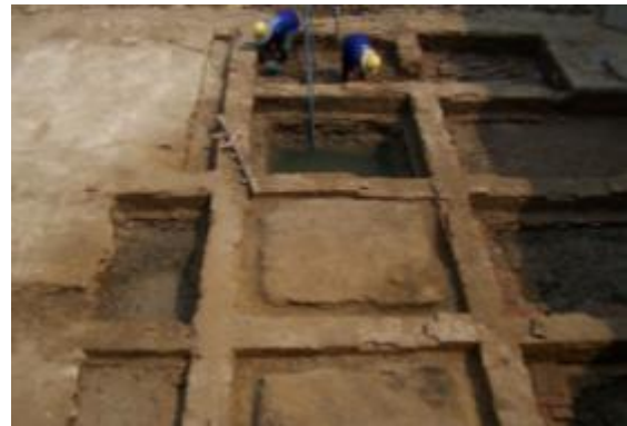
ภาพที่ ข.80 การแสดงแนวฐานรากอาคารเดิมที่ชุดสำรวจเป็นหลักฐานทางโบราณคดีก่อนบูรณะอาคารและก่อสร้าง
