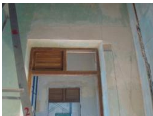
ภาพที่ 4.53 การแสดงการกำหนดตำแหน่งปูนฉาบที่เสียหายแตกร้าวและล่อนเพื่อสกัดแล้วฉาบใหม่
