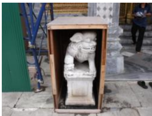
ภาพที่ ข.35 การแสดงกล่องไม้อัดป้องกันโบราณวัตถุหินแกรนิตแกะสลักก่อนการบูรณะ
