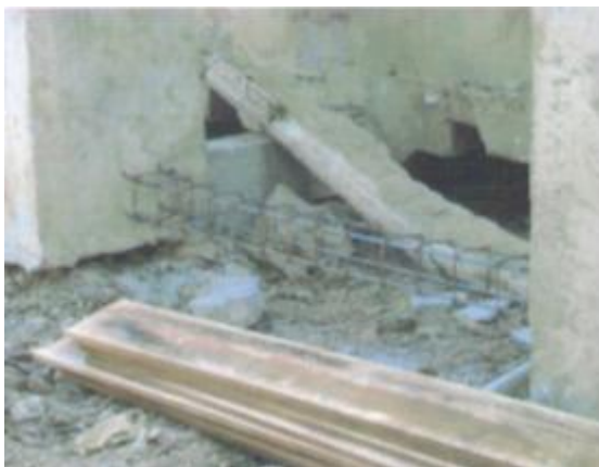
ภาพที่ ค.57 การแสดงเจาะเสียเหล็กเสริมทำ โครงสร้างยึดคอนกรีตรอบอาคาร (ที่มา: บริษัทพี เนสส์ ซอยล์ เทคโนโลยี จำกัด, 2551)
