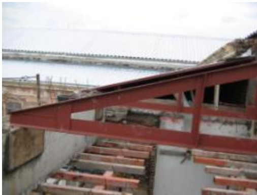
ภาพที่ ฉ.128 การแสดงติดตั้งโครงเหล็ก
