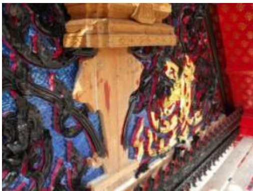
ภาพที่ ๓.๓๗ การแสดงติดตั้งไม้แกะสลักหน้า บันทึทดแทนไม้เดิมที่ผุ
