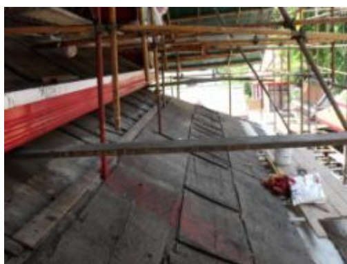
ภาพที่ ๑.54 การแสดงซ่อมไม้กระดานก่อนปูแผ่นกันซึมหลังคา
