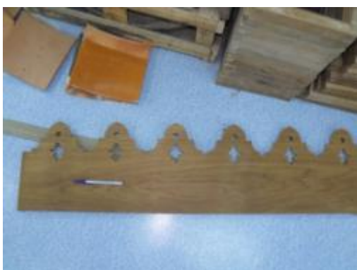
ภาพที่ ฉ.149 การแสดงไม้ฉลุใหม่เพื่อใช้ทดแทนไม้เดิมที่เสียหาย
