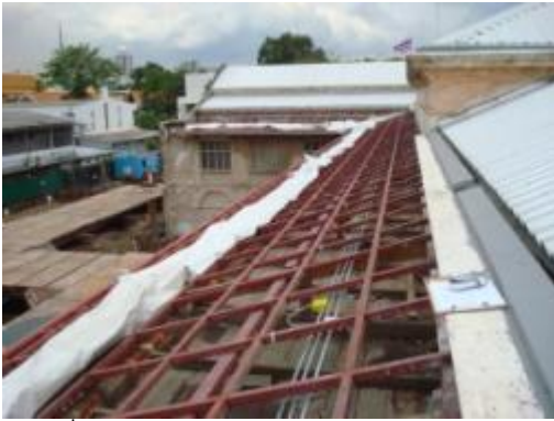
ภาพที่ ฉ.113 การแสดงเสริมเหล็กรูปพรรณ กับโครงไม้เดิม
