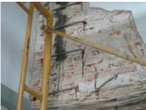
ภาพที่ ค.8 การแสดงอุดรอยร้าวด้วย Cement non shrink grout และเจาะยึดผนังอิฐแนวร้าวด้วยเหล็กเสริมภาพตัว U
