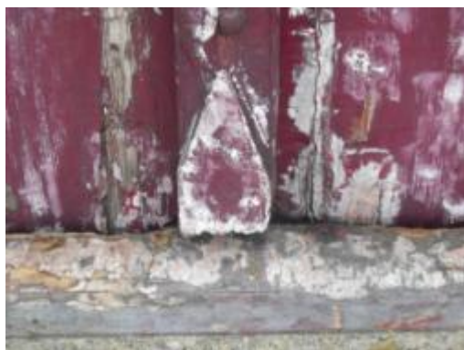
ภาพที่ 7.10 การแสดงประตูและธรณีประตูเสียหายที่ผิวเนื่องจากความชื้น
