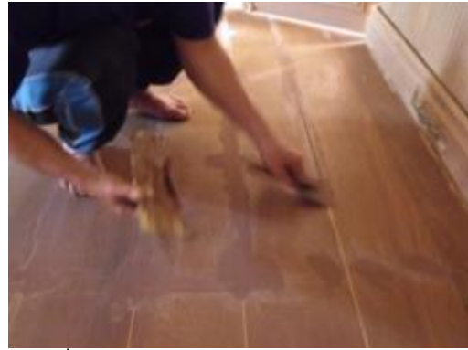
ภาพที่ ๑.8 การแสดงใช้ดินสอพองปิดร่องไม้ และซ่อมผิวไม้ครั้งที่ 2
