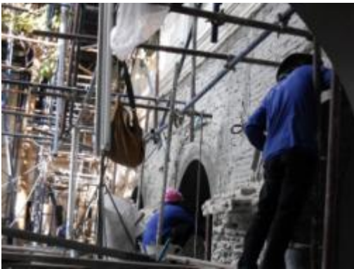
ภาพที่ ง.50 การแสดงสกัดปูนฉาบที่ เสื่อมสภาพออกไป
