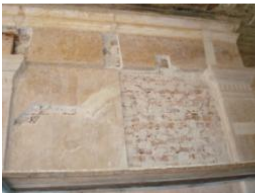
ภาพที่ ง.37 การแสดงสกัดปูนฉาบเดิมที่แตกร้าวและล่อน
