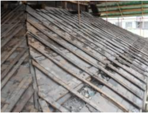
ภาพที่ ๑.43 การแสดงไม้โครงหลังคาและ ปลวกกัดกิน
