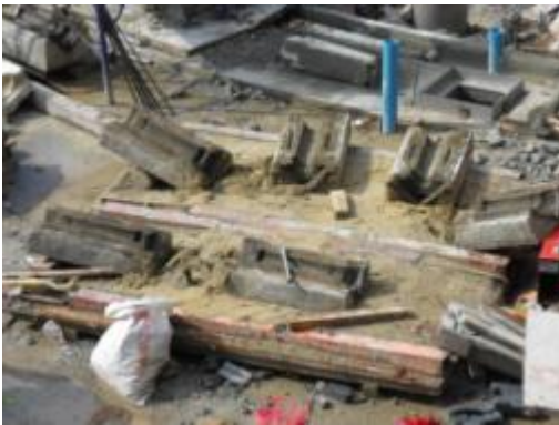
ภาพที่ ง.95 การแสดงแบบหล่อคอนกรีตที่ลานหล่อ
