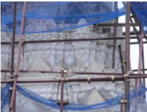
ภาพที่ ง.127 การแสดงติดตั้งปูนปั้นหล่อ สำเร็จ
