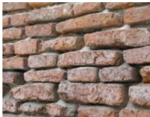
ภาพที่ 4.18 การแสดงความเสียหายของปูนก่อ
