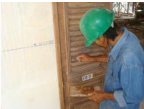
ภาพที่ ข.3 การแสดงใช้กาวไม้ผสมซีลี้อยู่ ปิดร่องรอยต่อไม้เพื่อความมั่นคง และปิด ร่องไม้ของบานประตู
