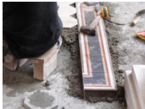
ภาพที่ ๑.58 การแสดงปูกระเบื้องซีเมนต์ผลิตใหม่เลียนแบบของเดิม
