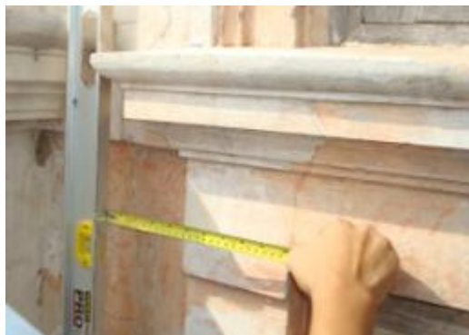
ภาพที่ ข. 6 การแสดงวัดตรวจสอบสภาพ ปัจจุบันของอาคารเพื่อเป็นข้อมูลจัดทำแบบ สภาพปัจจุบันของอาคารโบราณสถาน
