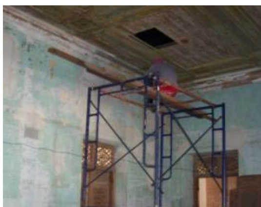
ภาพที่ ข.50 การแสดงอัดฉีดน้ำยากันปลวกบนโครงฝ้าเพดานไม้
