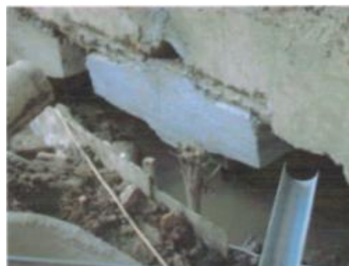
ภาพที่ ค.39 การแสดงโครงสร้างถ่ายแรงชั้น ล่างภายหลังจากเทคอนกรีตเสร็จ อยู่ใต้ ระดับของโครงสร้างถ่ายแรง(Arch) (ที่มา: บริษัทพีเนสต์ ซอยล์ เทคโนโลยี จำกัด, 2551)
