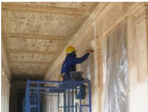
ภาพที่ ง.21 การแสดงจุดผิวหน้าปูนฉาบที่มีสีและปูนเสื่อมสภาพออกไป
