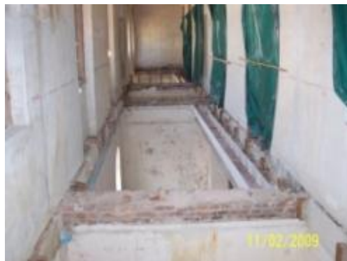
ภาพที่ 5.22 การแสดงการรื้อถอนพื้นไม้ ออกไปแล้วนำไม้เดิมกลับมาบูรณะติดตั้งใหม่
