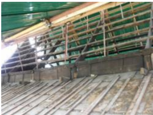
ภาพที่ ๑.49 การแสดงเปลี่ยนไม้อะเสและจันทันเพื่อทดแทนส่วนที่เสียหาย
