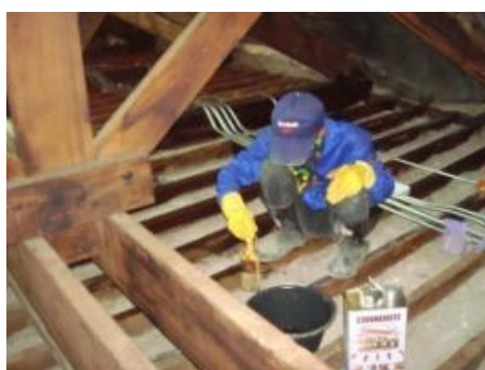
ภาพที่ ข.52 การแสดงทาน้ำยากำจัดปลวกส่วนของฝ้าเพดานไม้และโครงหลังคา
