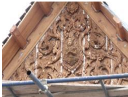
ภาพที่ ฉ.28 การแสดงติดตั้งไม้แกะสลัก ทดแทนของเดิมที่ผุ
