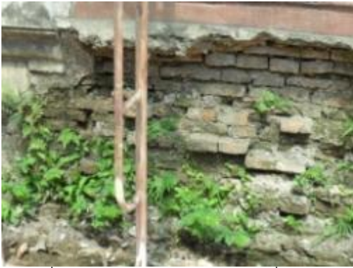
ภาพที่ 4.29 การแสดงผนังเสื่อมสภาพ เนื่องจากเกลือและการย่อยสลายของรากพืช
