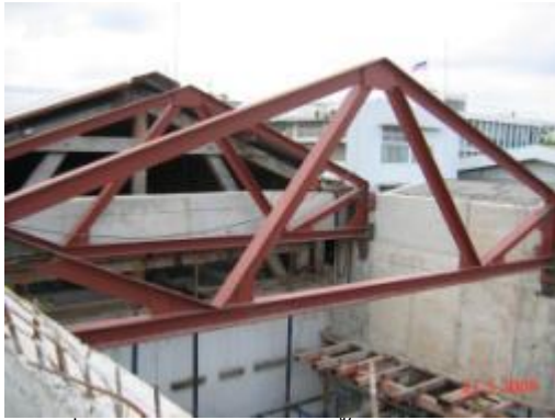
ภาพที่ ฉ.127 การแสดงติดตั้งโครงเหล็ก
