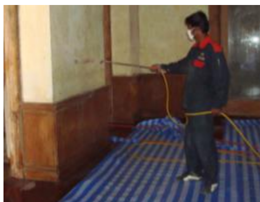
ภาพที่ ข.51 การแสดงฉีดน้ำยากำจัดปลวกผนังตึกแต่งไม้ของอาคารโบราณสถาน
