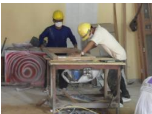
ภาพที่ ข.23 การแสดงตัดไม้ส่วนที่ผุเสียหาย ออกไปเพื่อเสริมทดแทนด้วยไม้ใหม่
