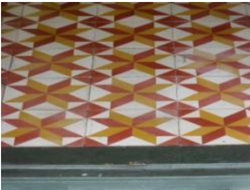
ภาพที่ จ.60 การแสดงกระเบื้องซีเมนต์ที่ปูแล้วเสร็จ
