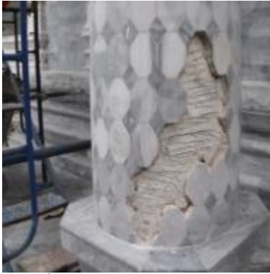
ภาพที่ จ.63 การแสดงซ่อมปูนภายในเสาที่ผู้ กร่อนด้วยปูนใหม่เพื่อให้มีความแข็งแรงก่อน ติดตั้งหินอ่อน
