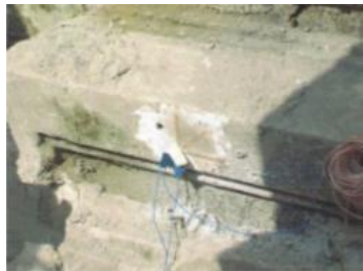
ภาพที่ ค.49 การแสดงติดตั้งอุปกรณ์ตรวจวัดการเปลี่ยนแปลงหน่วยแรง Deviator stresses (ที่มา: บริษัทพีเนสส์ ซอยล์ เทสติ้ง จำกัด, 2551)
