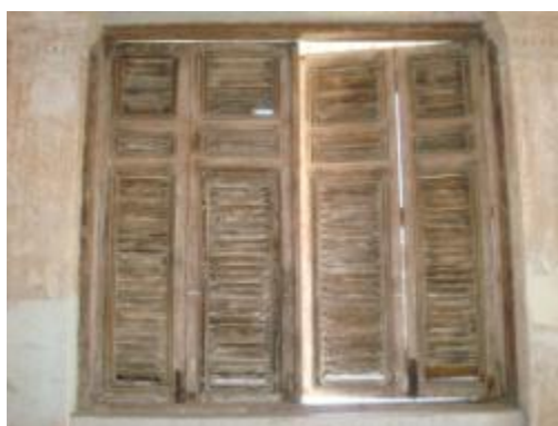
ภาพที่ 7.24 การแสดงบานหน้าต่างเกิดไม้บางส่วนเสียหาย
