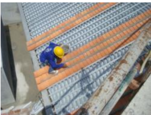
ภาพที่ ข.121 การแสดงติดตั้งกระเบื้องจีนและปูนปั้นระหว่างรอยต่อกระเบื้อง
