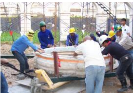
ภาพที่ ข.39 การแสดงขนย้ายอ่างน้ำพุโบราณวัตถุออกจากพื้นที่ก่อนการบูรณะ
