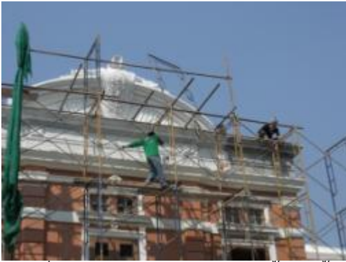
ภาพที่ ง.100 การแสดงการติดตั้งปูนปั้น หล่อสำเร็จ
