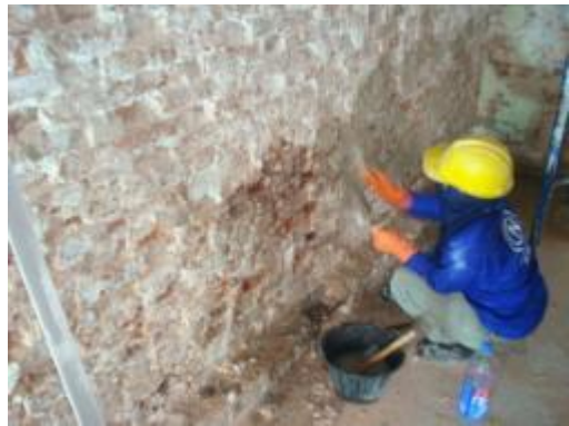
ภาพที่ ง.53 การแสดงซ่อมแซมผนังก่อนฉาบ ปูนด้วยการอุดปูนตามตำแหน่งที่เสียหาย
