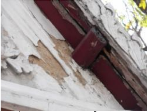
ภาพที่ 4.73 การแสดงปูนปั้นเสื่อมสภาพผู้ กร่อนตำแหน่งหน้าบ้านของหลังคาอาคาร โบราณสถาน
