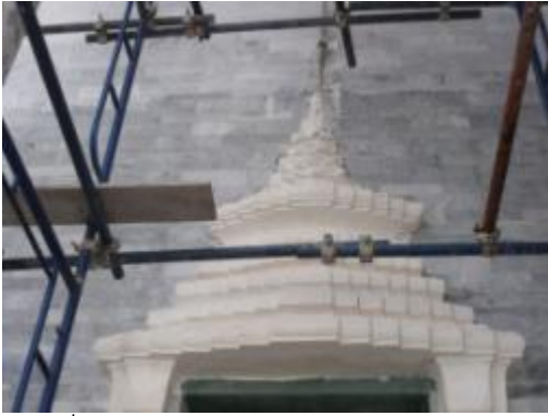
ภาพที่ ง.111 การแสดงฉาบตกแต่งโครงร่างให้เรียบร้อยก่อนปั้นรายละเอียด
