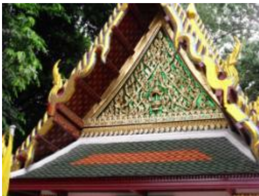
ภาพที่ ๕.73 การแสดงอาคารบูรณะแล้ว เสร็จ
