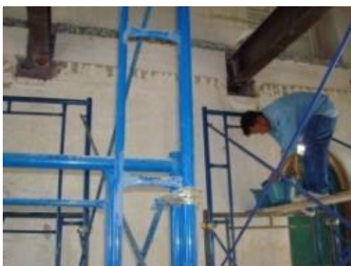
ภาพที่ จ.37 การแสดงติดตั้งแผ่นเหล็กรองรับใต้คานเหล็กรูปพรรณและติดตั้งคานเหล็กรูปพรรณ
