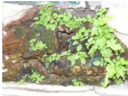
ภาพที่ 4.34 การแสดงต้นไม้เจริญเติบโตบน ก่ออิฐทำให้เริ่มผุกร่อน
