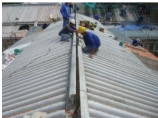
ภาพที่ ข.124 การแสดงติดตั้งตะเฆ่สันด้วยปูนปั้นหล่อสำเร็จ
