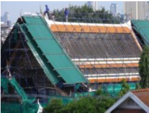
ภาพที่ ข.16 การแสดงยึดโครงท่อนเหล็กเพื่อเป็นโครงสร้างมุงแผ่นสังกะสีป้องกันฝนชั่วคราวระหว่างการบูรณะวัดราชประดิษฐ์
