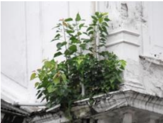
ภาพที่ ข.24 การแสดงต้นโพธิ์ที่ได้ตัดกิ่งทำลายแล้วแต่มีได้รอดยาฆ่าวัชพืชจึงเจริญเติบโตขึ้นใหม่อีกครั้งจากตอและรากที่เหลือ
