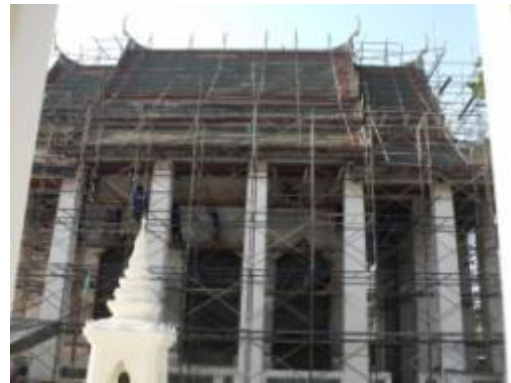
ภาพที่ ข.19 การแสดงตั้งนั่งร้านและยึดโครงหลังคาชั่วคราวก่อนติดตั้งแผ่นสังกะสีกันฝนวัดราชนั้ดคารามวรวิหาร
