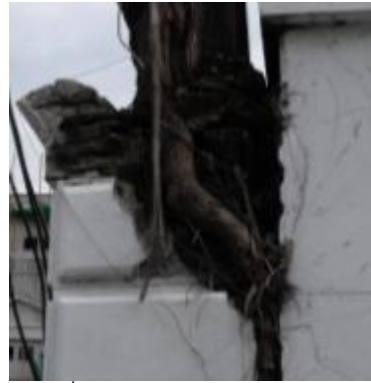
ภาพที่ 4.59 การแสดงไม้ยืนต้นเจริญเติบโตบนผนังชอนไชรากทำลายผนังจนแตกเสียหาย
