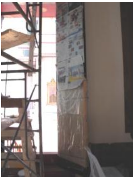
ภาพที่ ข.42 การแสดงวิธีป้องกันจัตกรรม ลายรดน้ำประตูปะตูโบสถ์ด้วยการใช้กระดาษ คลุมปิดแล้วคลุมทับด้วยพลาสติกใส
