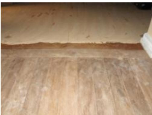
ภาพที่ ๑.7 การแสดงใช้ดินสอพองปิดร่องไม้ และผิวไม้ครั้งที่ 1
