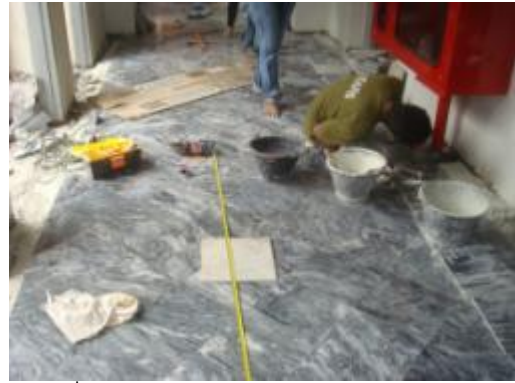
ภาพที่ จ.53 การแสดงปูหินอ่อนโดยใช้หิน เดิมขัดผิวหน้าใหม่แล้วปูใหม่
