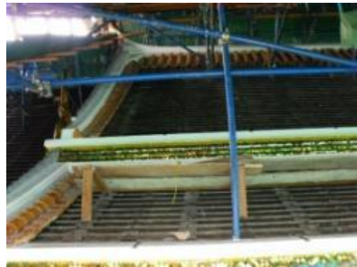
ภาพที่ ๑.17 การแสดงปิดกระจกสีด้วย Epoxy resin เชิงชาย
