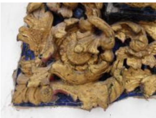
ภาพที่ 4.79 การแสดงปูนปั้นเดิมรอบซุ้มหน้าต่างมีรอยร้าวเล็กน้อยบางส่วน
