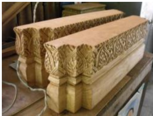
ภาพที่ ๓.๓๘ การแสดงไม้แกะสลักเตรียม ติดตั้งทดแทนไม้เดิมที่ผุ
