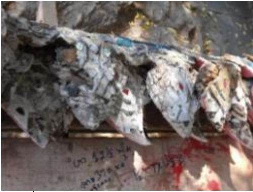
ภาพที่ 6.3 การแสดงไม้เกาะสลักประดับ หน้าบ้านผุมาก ไม่สามารถบูรณะใช้งานได้อีก
