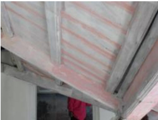
ภาพที่ จ.141 การแสดงโป้วแต่งร่องไม้และ ทาสีรองพื้นฝ้าเพดานเพื่อป้องกันเชื้อราและ ยางไม้
