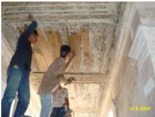
ภาพที่ ฉ.136 การแสดงการตอกยึดไม้ฝ้าเพดานเดิมให้แน่นมั่นคง
