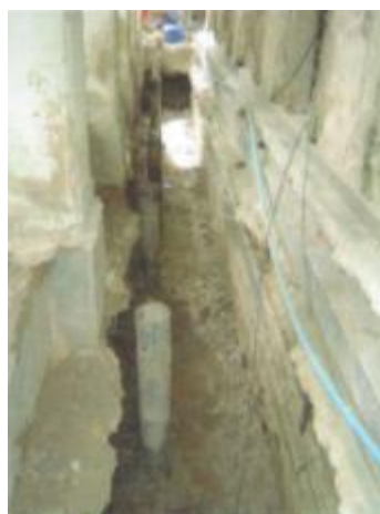
ภาพที่ ค.42 การแสดงตอกเสาเข็มเหล็กกลมเส้นผ่าศูนย์กลาง 20 เซนติเมตรแล้วเสร็จ (ที่มา: บริษัทพีเนสส์ ซอยล์ เทคโนโลยี จำกัด, 2551)
