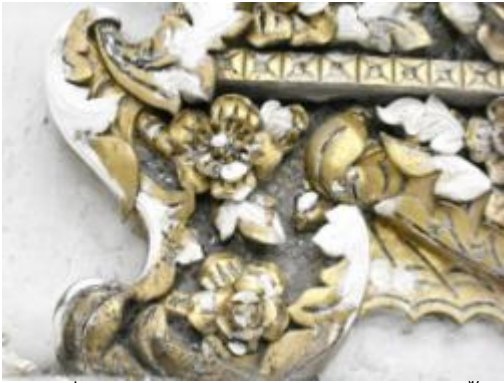
ภาพที่ ง.74 การแสดงช่อมแซมปูนปั้น บางส่วนที่เสียหาย
