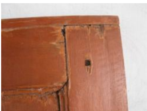
ภาพที่ 7.15 การแสดงลักษณะความเสียหาย ของบานประตู
