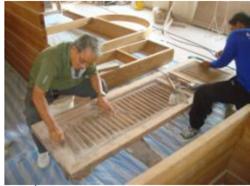
ภาพที่ ข.4 การแสดงขัดผิวไม้ก่อน ดำเนินงานสี
