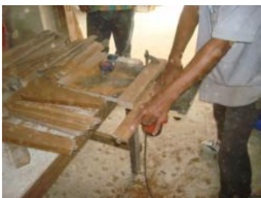
ภาพที่ ข.24 การแสดงถอดชิ้นไม้บานประตูเดิม เพื่อซ่อมบูรณะใหม่ โดยเปลี่ยนไม้ที่เสียหายด้วยไม้ใหม่
