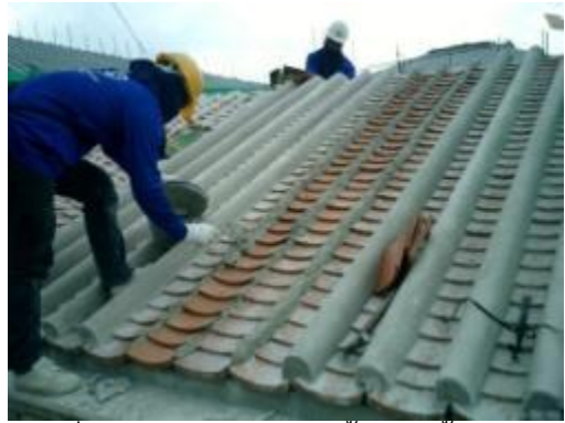
ภาพที่ ข.122 การแสดงติดตั้งกระเบื้องจีนและปูนปั้นระหว่างรอยต่อกระเบื้อง
