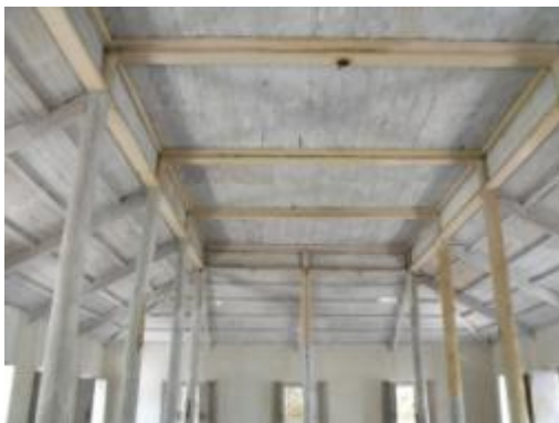
ภาพที่ ฉ.159 การแสดงซ่อมบูรณะด้วยการเปลี่ยนไม้บางส่วนและทาสีรองพื้นไม้
