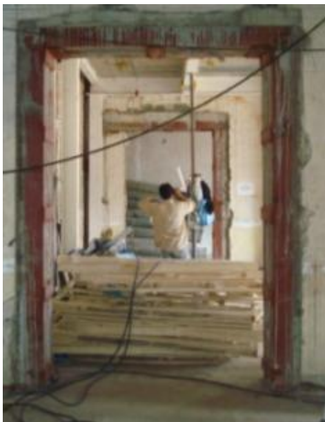
ภาพที่ ง.7 การแสดงใช้เหล็กรูปพรรณเสริมรอบช่องเปิดทดแทนไม้เดิมที่เสียหาย
