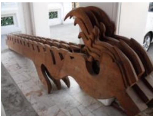
ภาพที่ ๑.๙๗ การแสดงใบระกา และหางหงส์เตรียมขึ้นไปติดตั้งทดแทนไม้เดิมที่ผุเสียหาย
