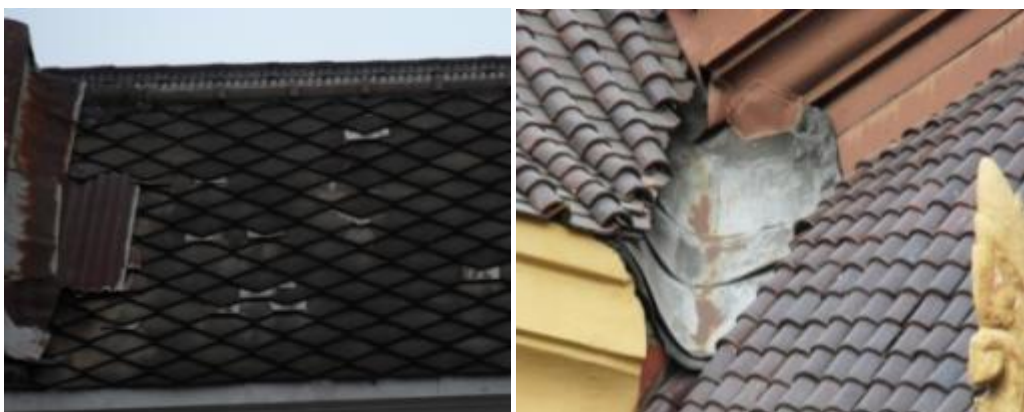
ภาพที่ 2.28 การแสดงการติดตั้งแผ่นเหล็กชุบสังกะสีสอดรองใต้แผ่นกระจับปี่แก้ไขปัญหาน้ำรั่ว
