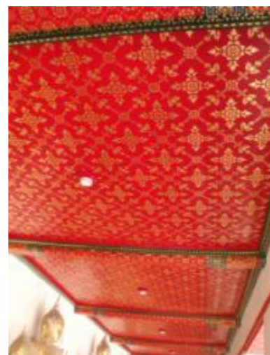
ภาพที่ จ.145 การแสดงปิดทองฝ้าเพดาน เมื่อบูรณะแล้วเสร็จ
