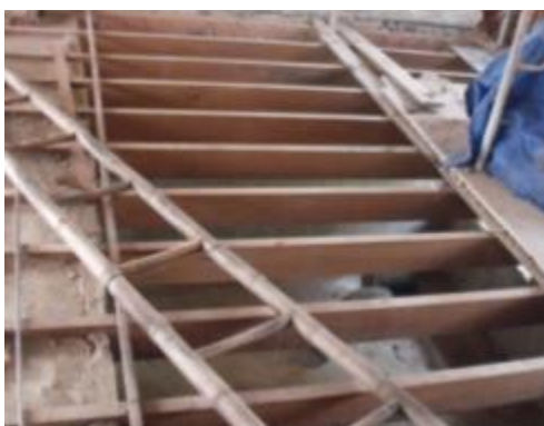
ภาพที่ จ.33 การแสดงประกอบคานไม้ใหม่ ตามรูปแบบและเทคนิคดั้งเดิม
