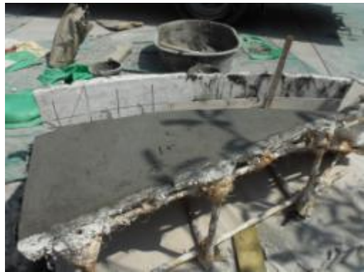
ภาพที่ ง.98 การแสดงเทคอนกรีตและเหล็กเสริมหล่อปูนปั้นโดยใช้แบบหล่อปูนปลาสเตอร์
