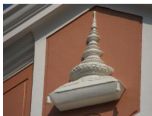
ภาพที่ ง.73 การแสดงซ่อมแซมฟู่ปูนปั้นที่สูญหายด้วยการปั้นใหม่
