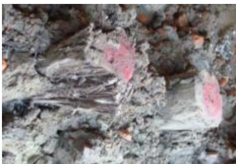
ภาพที่ 3.14 การแสดงเสาเข็มไม้ที่ได้ตอกไว้กว่า 100 ปี บางส่วนยังมีสภาพดี
