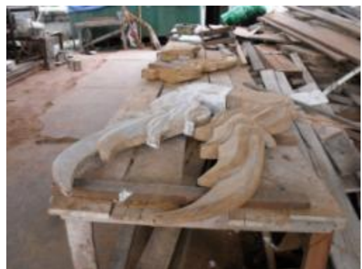
ภาพที่ ฉ.60 การแสดงไม้หางหงส์ทำใหม่ เลียนแบบหางหงส์เดิมที่ผุเสียหาย
