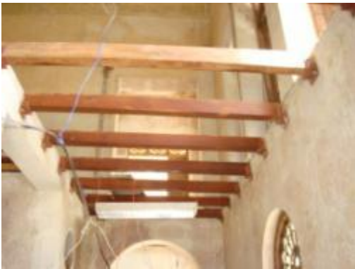
ภาพที่ จ.22 การแสดงการประกอบติดตั้ง คานไม้เก่า เสริมความแข็งแรงของคาน ด้านล่างที่จุดรองรับด้วยเหล็กรูปพรรณและ เจาะยึดกับผนังก่ออิฐรับแรง
