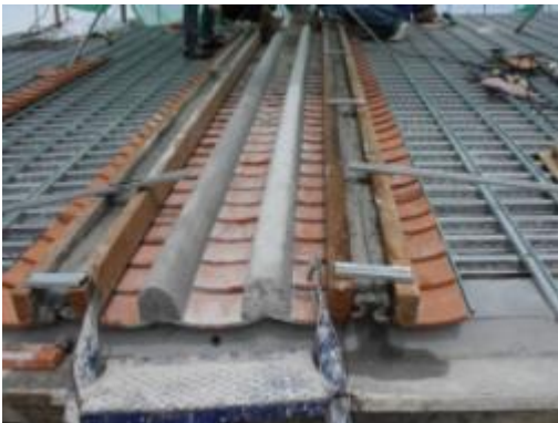
ภาพที่ ข.120 การแสดงติดตั้งกระเบื้องจีนและปูนปั้นระหว่างรอยต่อกระเบื้อง
