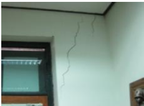
ภาพที่ 3.5 การแสดงลักษณะของรอยร้าวบนผนังภายในอาคารชั้นที่ 2
