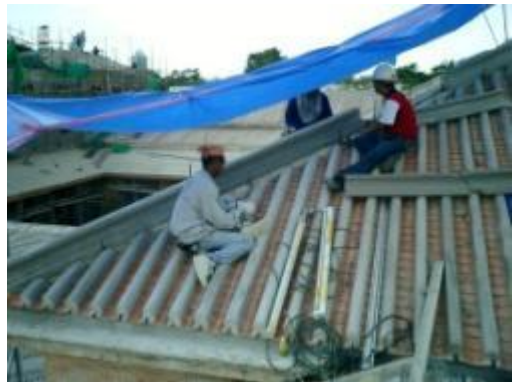
ภาพที่ ข.123 การแสดงติดตั้งตะเฆ่สันด้วยปูนปั้นหล่อสำเร็จ
