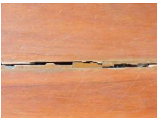
ภาพที่ 5.2 การแสดงวัสดุอุดร่องไม้แตกหลุด เนื่องจากการหดตัวของไม้กระดานและการขยับตัวของแผ่นไม้
