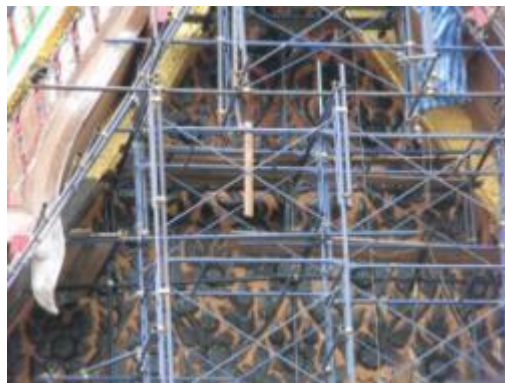
ภาพที่ ๘.๘๗ การแสดงบูรณะหน้าบันด้วย การซ่อมไม้แกะสลักและทาสี
