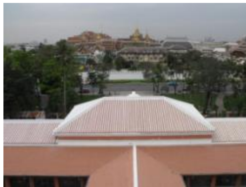
ภาพที่ ฉ.135 การแสดงหลังคากระเบื้องดินเผาภายหลังการบูรณะเสร็จ
