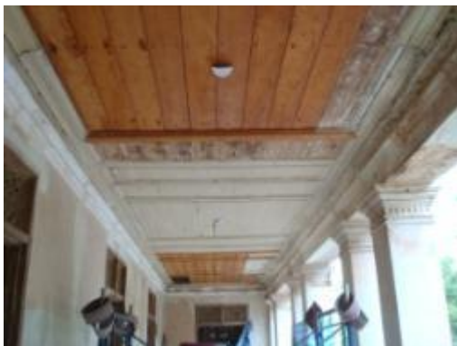
ภาพที่ ฉ.153 การแสดงเปลี่ยนไม้ใหม่ทดแทนไม้เดิมที่เสียหาย
