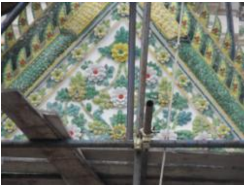
ภาพที่ จ.71 การแสดงติดเศษถ้วยชาม กระเบื้องเคลือบเสร็จเรียบร้อยแล้ว
