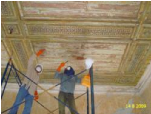
ภาพที่ ฉ.137 การแสดงการขูดลอกสีโดยการใช้น้ำยาลอกสีทา ก่อนแล้วใช้เกรียงเหล็กขูดลอกออก
