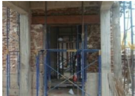
ภาพที่ ง.5 การแสดงไม้ใหม่เปลี่ยนทดแทนไม้เดิมที่เสียหาย
