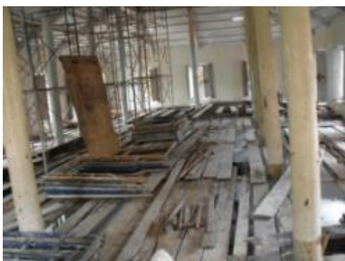
ภาพที่ 5.19 การแสดงคานและพื้นไม้ที่เสียหาย
