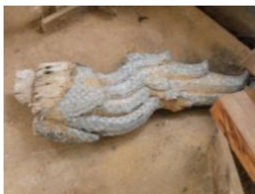
ภาพที่ ๑.48 การแสดงหางหงส์เสียหายมาก ทำการเปลี่ยนทดแทนด้วยไม้ใหม่
