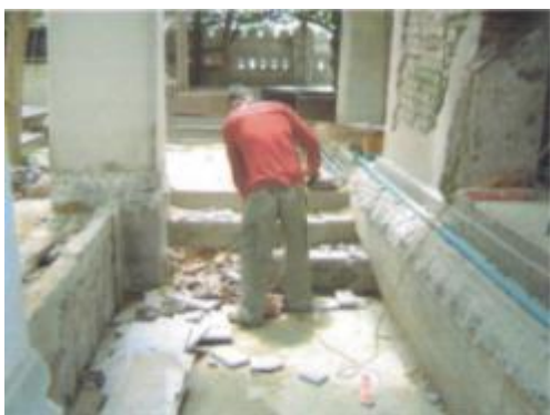
ภาพที่ ค.26 การแสดงสกัดพื้นโดยรอบอาคารเพื่อเตรียมงานขุดดิน(ที่มา: บริษัทพีเนสต์ ซอยล์ เทสติ้ง จำกัด, 2551)
