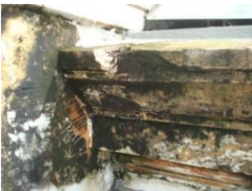
ภาพที่ 4.49 การแสดงตะไคร่น้ำบนผนังปูน ฉาบพบในบริเวณที่มีความชื้นสูง
