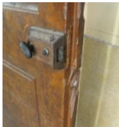
ภาพที่ 7.22 การแสดงลักษณะความเสียหายของบานประตูแตกหัก
