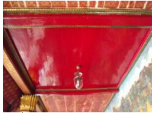
ภาพที่ จ.143 การแสดงทาสีจริงฝ้าเพดาน เพื่อเตรียมดำเนินงานปิดทองฝ้าเพดาน
