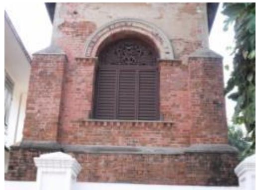
ภาพที่ 4.66 การแสดงปูนฉาบเสื่อมสภาพผุกร่อนเกือบทั้งหมด ปรากฏให้เห็นผิวอิฐก่อภายใน
