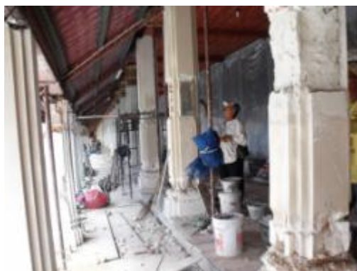
ภาพที่ ง.60 การแสดงฉาบปูนซ่อมบูรณะเสาอาคาร
