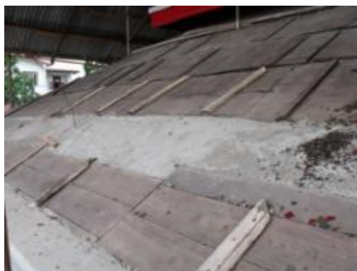
ภาพที่ ๑.53 การแสดงซ่อมไม้กระดานก่อนปูแผ่นกันซึม
