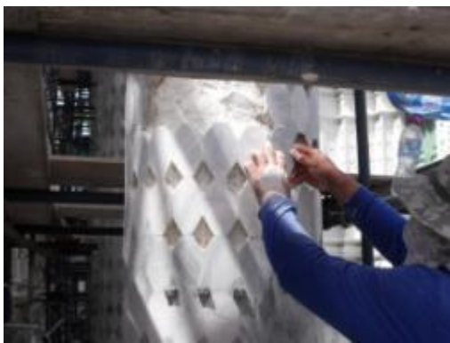
ภาพที่ จ.64 การแสดงซ่อมหินอ่อนโดยใช้หิน เดิมที่หลุดร่วงซ่อมแซมเฉพาะตำแหน่งที่ เสียหาย
