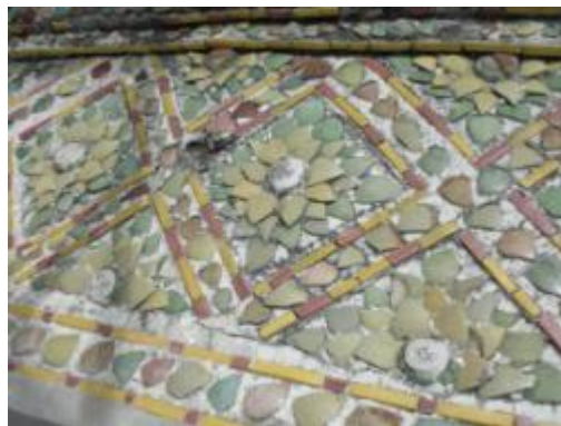
ภาพที่ 5.48 การแสดงผนังประดับด้วยเศษ ถ้วยชามกระเบื้องเคลือบหลอดร่วงและแก้ว หมอง
