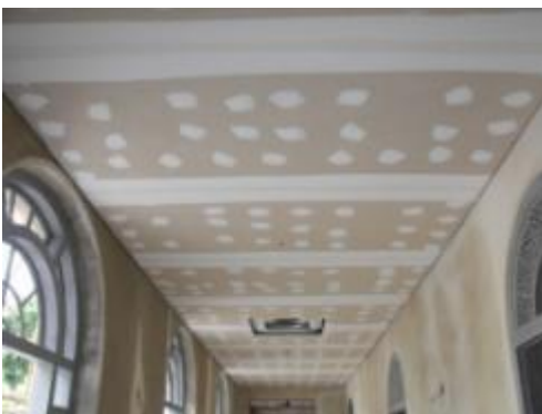
ภาพที่ ฉ.165 การแสดงติดตั้งแผ่นฝ้าเพดานด้วยฝ้าเคลือบเซมิซิลิเกต บูรณะทดแทนฝ้าไม้เดิม
