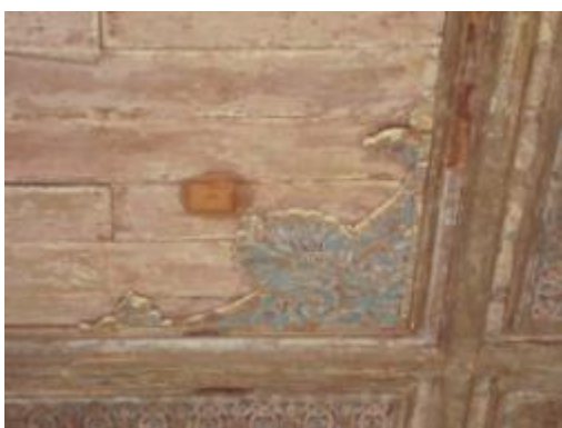
ภาพที่ ฉ.154 การแสดงซ่อมไม้ตำแหน่งที่เกิดความเสียหาย
