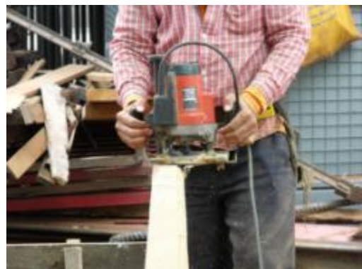
ภาพที่ ฉ.94 การแสดงจัดเตรียมบัวไม้ก่อน นำขึ้นไปติดตั้งบนโครงหลังคา
