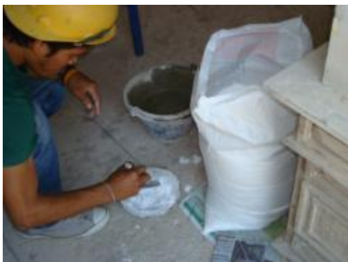
ภาพที่ ง.82 การแสดงเตรียมปูนปลาสเตอร์และเส้นใยไฟเบอร์เพื่อใช้หล่อลวดลายบัวปูนปั้นของอาคาร
