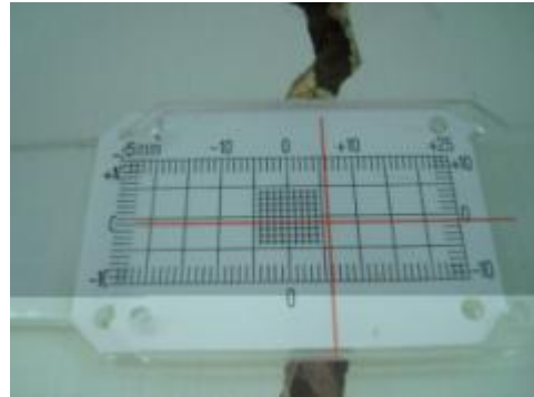
ภาพที่ ค.4 การแสดงภาพถ่าย Crack gauge
