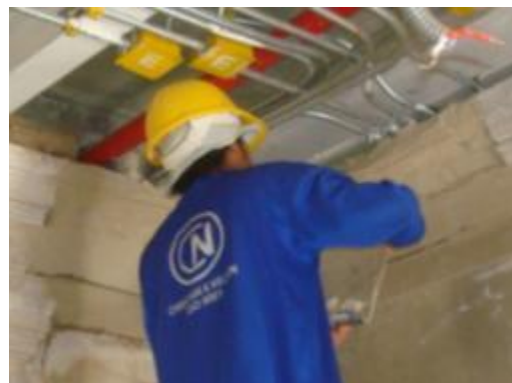
ภาพที่ ง.47 การแสดงปั้นปูนทดแทนบัวปูน ปั้นเดิมที่แตกเสียหาย ดำเนินการภายหลัง ฉาบปูนเสร็จเรียบร้อยแล้ว
