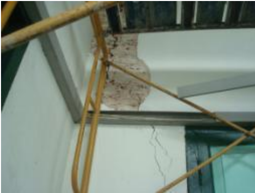
ภาพที่ ค. 7 การแสดงสกัดปูนฉาบเดิมรอบรอยร้าวออกไปตำแหน่งผนังชั้นที่ 1
