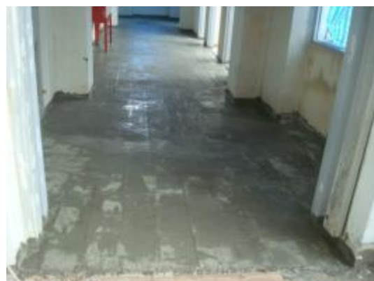
ภาพที่ 5.6 การแสดงการชัดผิวหน้าไม้ผุดำเนินการตอกตะปูเพิ่มยึดไม้กระดานให้แน่นและทากันซึมผิวไม้ก่อนปูกระเบื้อง
