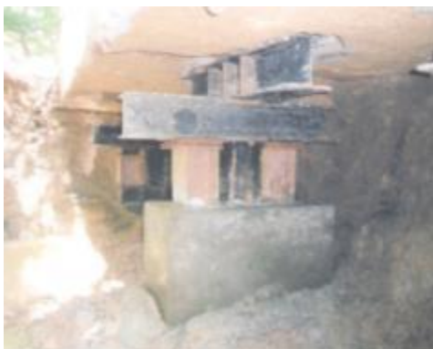
ภาพที่ ค.37 การแสดงเทคอนกรีตปิดหุ้มหัว เสาเข็ม(ที่มา: บริษัทพีเนสต์ ซอยล์ เทคโนโลยี จำกัด, 2554)
