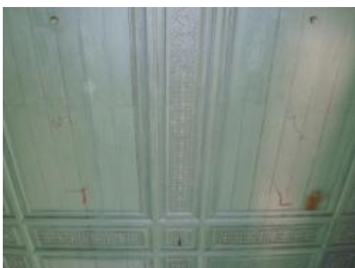
ภาพที่ ฉ.160 การแสดงซ่อมบูรณะด้วยการเปลี่ยนไม้บางส่วนและทาสีรองพื้นไม้
