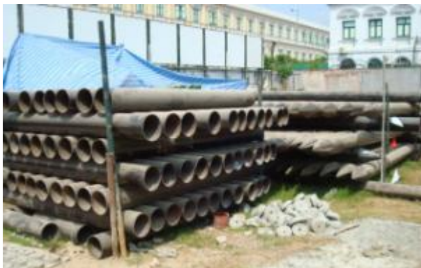
ภาพที่ ค.13 การแสดงลักษณะเสาเข็มเหล็กที่เตรียมไว้เพื่อบูรณะอาคาร
