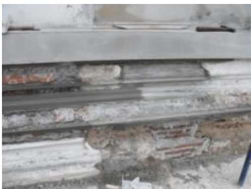
ภาพที่ ง.57 การแสดงจับเชื่อมปูนก่อนฉาบปูน
