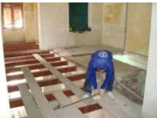
ภาพที่ จ.23 การแสดงดำเนินงานติดตั้งไม้ พื้นอาคาร โครงการบูรณะพระราชวังสระอูน รมย์
