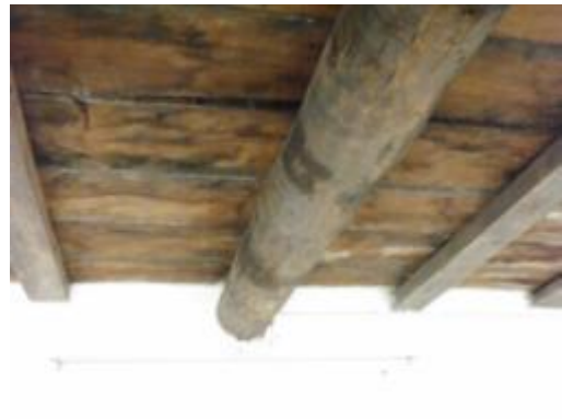
ภาพที่ จ.25 การแสดงโครงสร้างพื้นไม้ติดตั้ง ตามแบบดั้งเดิม โครงการบูรณะหอ พระไตรปิฎก วัดเทพธิดารามวรวิหาร
