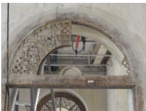
ภาพที่ 7.26 การแสดงไม้ฉลุบางส่วนแตกหักเสียหาย
