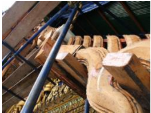
ภาพที่ ๑.11 การแสดงชุดลอกกระจกประดับ และยางรัดออกจากช่อฟ้า ใบระกา และทาง หงส์เพื่อไปตกแต่งผิวไม้
