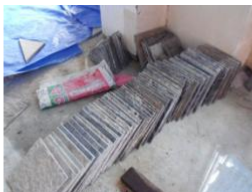
ภาพที่ จ.48 การแสดงหินเดิมที่ได้ขัดผิวหน้าหินที่โรงงานเสร็จ เตรียมใช้ปูพื้น
