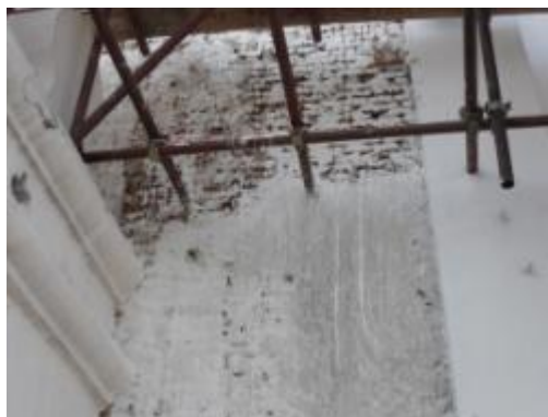
ภาพที่ ง.40 การแสดงรดน้ำปูนที่ผิวอิฐเดิมซึ่งมีลักษณะผิวร่วนแห้งและแตกเพื่อเพิ่มความสามารถการยึดเหนี่ยวของปูนฉาบและอิฐภายใน
