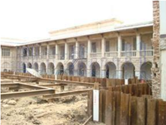
ภาพที่ 3.31 การแสดง Sheet pile ด้านที่ชิดกับอาคารโบราณสถานไม่ดำเนินการรื้อถอน เพื่อป้องกันดินเคลื่อนตัว
