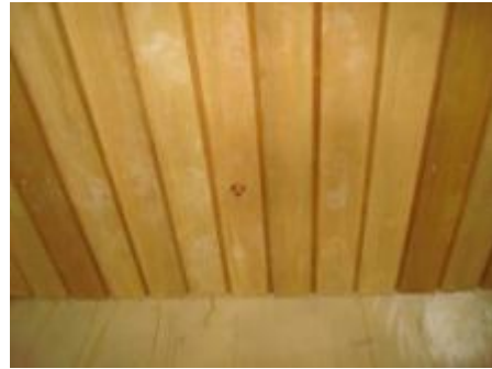
ภาพที่ ฉ.164 การแสดงฝ้าเพดานไม้ใหม่สร้างทดแทนฝ้าเดิมที่เสียหายมาก
