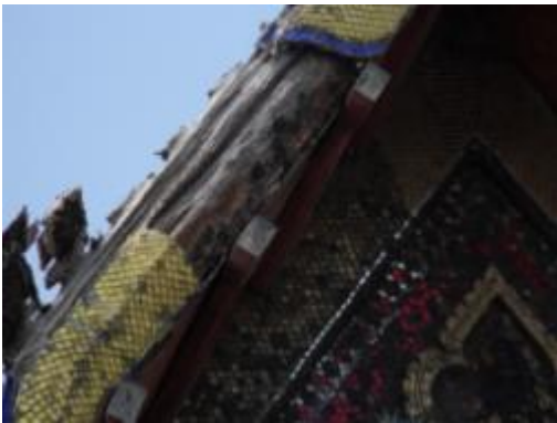
ภาพที่ 6.4 การแสดงไม้โบริกะกาและไม้หน้า บ้านผุเสียหาย โครงการบูรณะวัดมหารณพา รามวรวิหาร
