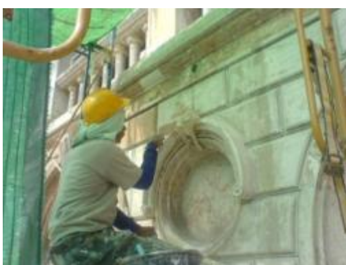
ภาพที่ ง.71 การแสดงฉาบซ่อมแต่งผิวปูนปั้นตำแหน่งที่แตกเสียหายและผิวหน้ากร่อน
