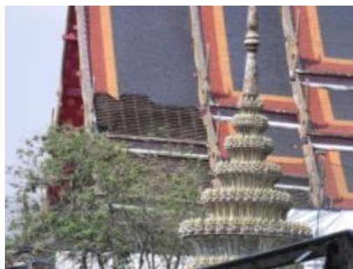
ภาพที่ ๕.76 การแสดงขณะกำลังรื้อถอน กระเบื้องหลังคา
