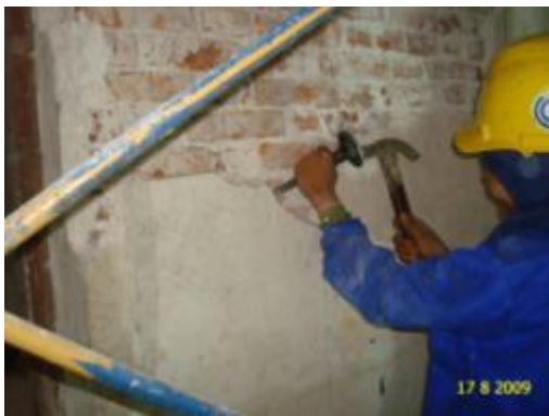
ภาพที่ ง.36 การแสดงสกัดปูนฉาบที่แตกร้าวและล่อน
