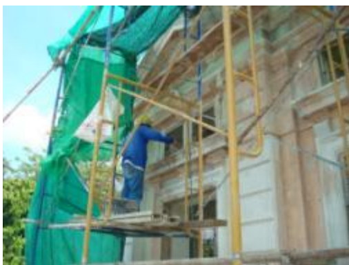
ภาพที่ ง.32 การแสดงขูดและขัดผิวที่มีเชื้อราดำออกจากผิวผนัง
