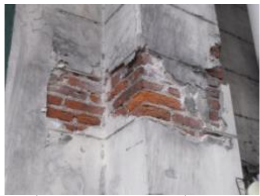
ภาพที่ 4.67 การแสดงปูนฉาบเสื่อมสภาพผุกร่อน
