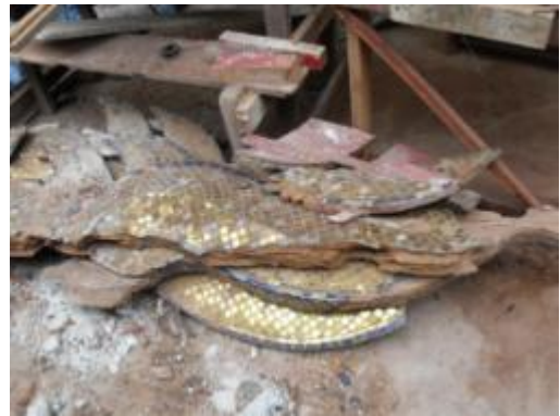
ภาพที่ 6.7 การแสดงข้อฟ้า โบริกะกา หางหงส์ ผุเสียหายทั้งหมด
