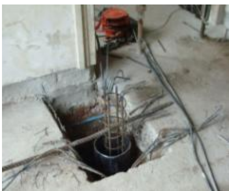
ภาพที่ ค.17 การแสดงติดตั้งเหล็กเส้นภายในเสาเข็มเหล็กก่อนเทคอนกรีต
