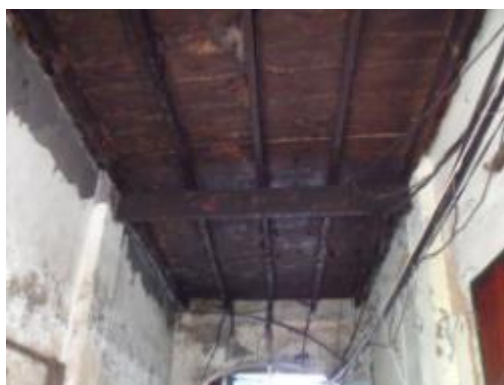
ภาพที่ 5.25 การแสดงผิวไม้เดิมผุเสียหายเนื่องจากความชื้น
