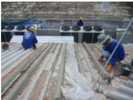
ภาพที่ ฉ.133 การแสดงทำปูนปั้นรอยต่อระหว่างแผ่นกระเบื้องดินเผา
