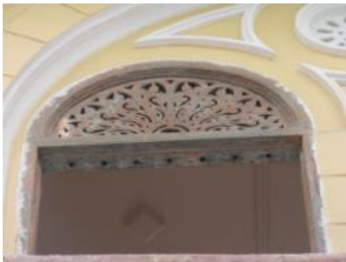
ภาพที่ ช.8 การแสดงซัดลอกสีเดิมไม้ฉลุ เหนือบานประตู
