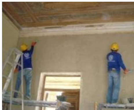
ภาพที่ ง.17 การแสดงฉาบผิวผนังภายหลังจากการซ่อมอิฐ
