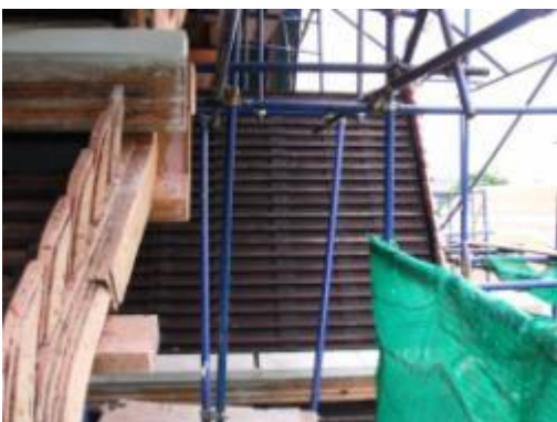
ภาพที่ ๑.9 การแสดงติดตั้งแผ่นกันซึมและ แป้ไม้ใหม่
