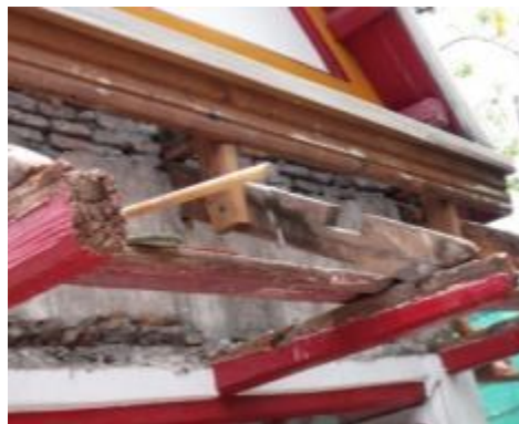
ภาพที่ 6.10 การแสดงคาน อะเส จันตัน แป ฝุเสียหายเนื่องจากความชื้น
