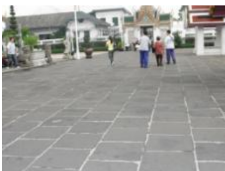
ภาพที่ ข.61 การแสดงลักษณะถนนเดิมของโบราณสถานมักจะวางบนดินอ่อน
