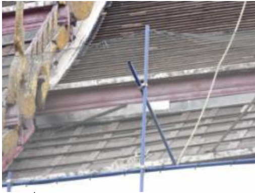
ภาพที่ ๗.๗๘ การแสดงซ่อมบูรณะไม้แปะ ระแนงและติดตั้งแผ่นกันซึม
