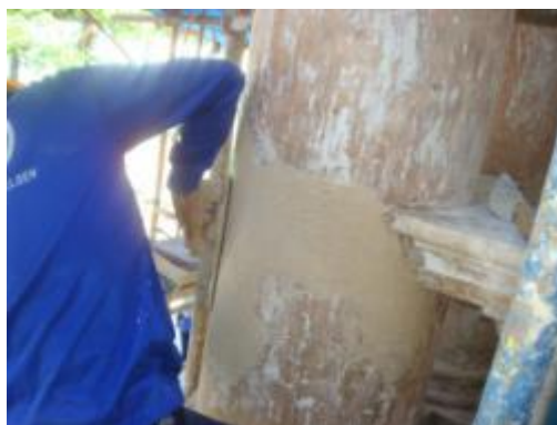
ภาพที่ ง.65 การแสดงฉาบซ่อมผิวเสาอาคาร
