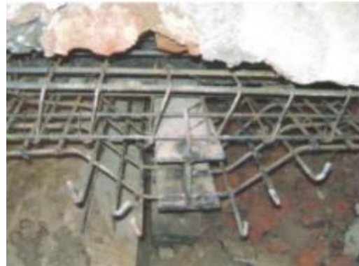
ภาพที่ ค.38 การแสดงติดตั้งเหล็กเสริม คอนกรีตโครงสร้างถ่ายแรงชั้นล่าง ซึ่งอยู่ใต้ ระดับของโครงสร้างถ่ายแรง(Arch) (ที่มา: บริษัทพีเนสต์ ซอยล์ เทคโนโลยี จำกัด, 2551)
