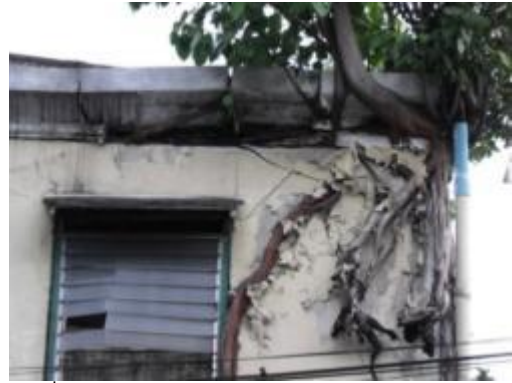
ภาพที่ 4.32 การแสดงผนังก่ออิฐแตกเสียหาย มากเนื่องจากการชอนไชของรากพืช
