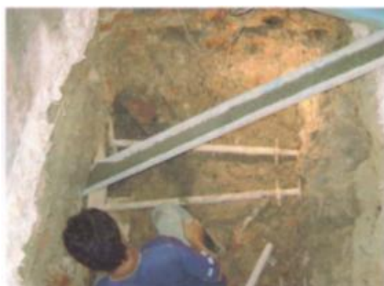
ภาพที่ ค.31 การแสดงเทคอนกรีตโครงสร้างถ่ายแรง(Arch) (ที่มา: บริษัทพีเนสต์ ซอยล์ เทสติ้ง จำกัด, 2551)
