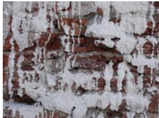
ภาพที่ ง.19 การแสดงราดน้ำปูนลงบนผิวอิฐเดิมก่อนทำการฉาบผิว
