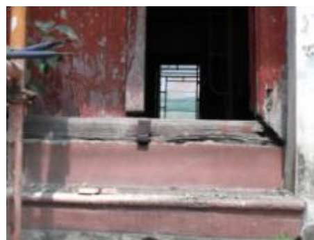
ภาพที่ 4.6 การแสดงวงกบไม้หน้าต่างใช้รับบานหน้าต่างและน้ำหนักอิฐผู้
