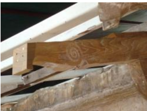
ภาพที่ ฉ.109 การแสดงซ่อมต่อปลายไม้เชิงชาย
