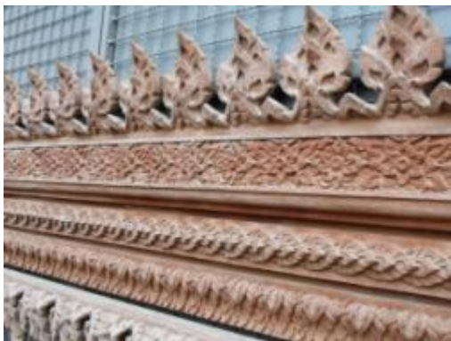
ภาพที่ ๑.๙๖ การแสดงไม้แกะสลักก่อนนำขึ้นไปติดตั้งทดแทนของเดิมที่ผุเสียหาย
