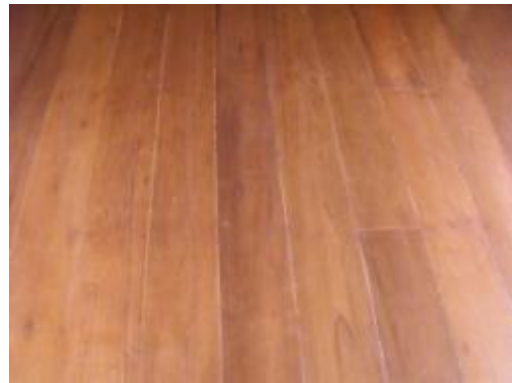
ภาพที่ ๑.9 การแสดงพื้นไม้หลังจากขัดผิวหน้า ละเอียดเสร็จก่อนทาโพลียูรีเทนที่ผิวหน้าไม้
