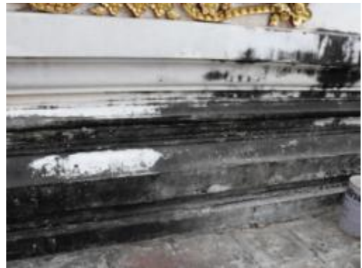
ภาพที่ 4.81 การแสดงเชื้อราดำเจริญเติบโตบนผิวปูนปั้นฐานพระอุโบสถ
