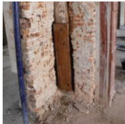
ภาพที่ ง.8 การแสดงเหล็กรูปพรรณเสริมทดแทนไม้เดิมรอบช่องเปิดและการใช้เสาไม้เชื่อมต่อไม้ส่วนที่ดีไว้เพื่อเป็นหลักฐานทางโบราณคดี
