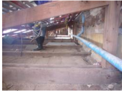
ภาพที่ ฉ.110 การแสดงเสริมเหล็กรูปพรรณกับโครงไม้เดิม
