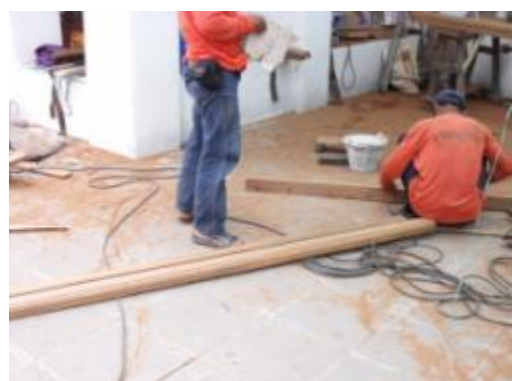
ภาพที่ ฉ.95 การแสดงเตรียมไม้จันทันก่อน นำขึ้นไปติดตั้ง
