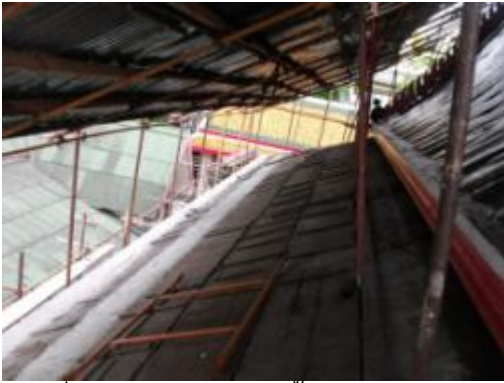
ภาพที่ ฉ.55 การแสดงติดตั้งแผ่นกันซึม หลังคา
