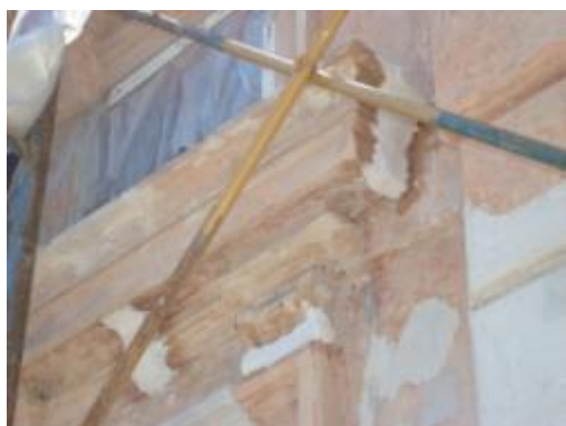
ภาพที่ ง.83 การแสดงใช้ปูนปลาสเตอร์และเส้นใยไฟเบอร์ลวดลายบัวปูนปั้นของอาคาร
