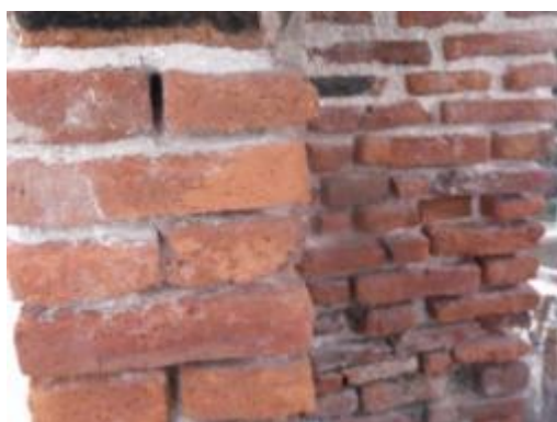
ภาพที่ 2.27 การแสดงลักษณะความเสียหายของปูนสออิฐเสื่อมสภาพ
