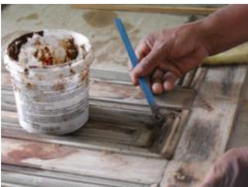
ภาพที่ ช.29 การแสดงอุดช่องว่างระหว่างไม้ด้วยกาวไม้ผสมซีเมนต์
