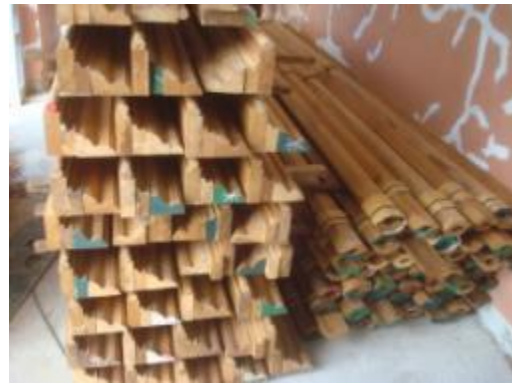
ภาพที่ ฉ.111 การแสดงเชิงชายไม้ใหม่เพื่อใช้ทดแทนไม้เดิมผุเสียหาย
