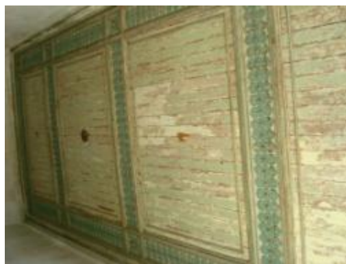
ภาพที่ 6.20 การแสดงสีทาฝ้าเพดานเสื่อมสภาพ
