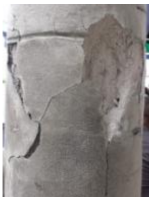
ภาพที่ 4.64 การแสดงปูนฉาบเสื่อมสภาพผุกร่อน
