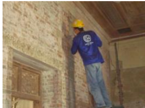
ภาพที่ 4.11 การแสดงคานไม้ฝังในผนังก่อ อิฐรับแรงภายในอาคารชั้นที่ 2 ยังคงมีสภาพ ที่ดี
