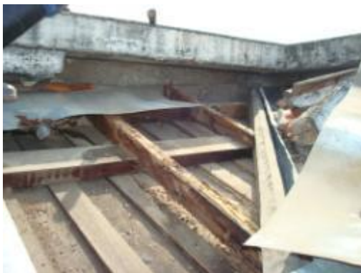
ภาพที่ 6.15 การแสดงโครงหลังคาไม้เสียหายมีปลวกกัดกิน
