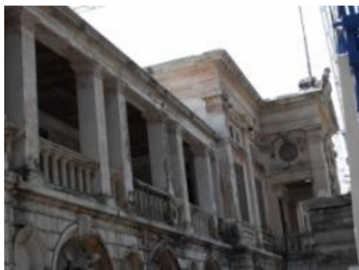
ภาพที่ ข.21 การแสดงเชื้อราดำเจริญเติบโตบนผิวผนังปูนอาคารโบราณสถาน
