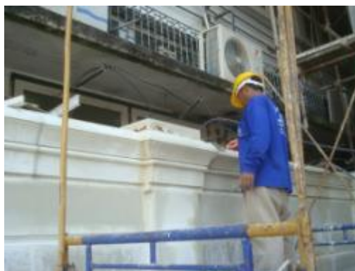
ภาพที่ ง.110 การแสดงติดตั้งและตกแต่งปูนปั้นหล่อสำเร็จ ติดตั้งที่ผนังรั้ว
