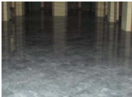
ภาพที่ จ.56 การแสดงหินอ่อนที่ปูแล้วเสร็จ โดยใช้หินใหม่ที่มีลักษณะเหมือนหินเดิม
