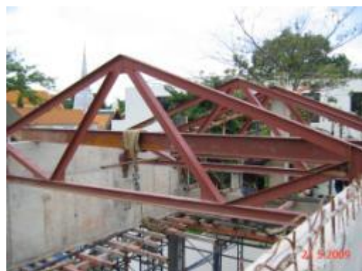
ภาพที่ จ.126 การแสดงติดตั้งโครงเหล็ก
