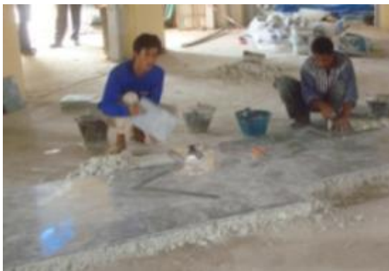
ภาพที่ จ.55 การแสดงปูหินอ่อนใหม่ที่มีสีหิน และลวดลายเหมือนหินเดิม
