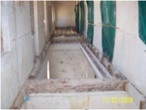
ภาพที่ จ.21 การแสดงการรื้อถอนโครงสร้าง พื้นไม้ออกไป
