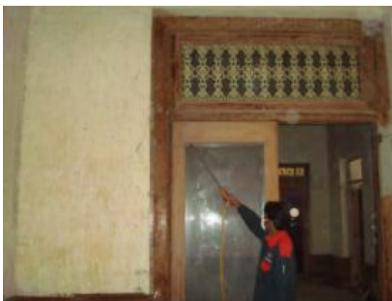
ภาพที่ ข.47 การแสดงฉีดน้ำยากำจัดปลวกบริเวณผนัง วงกบและประตูไม้
