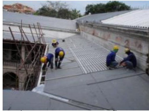
ภาพที่ ฉ.116 การแสดงติดตั้งแปเหล็ก รูปพรรณ
