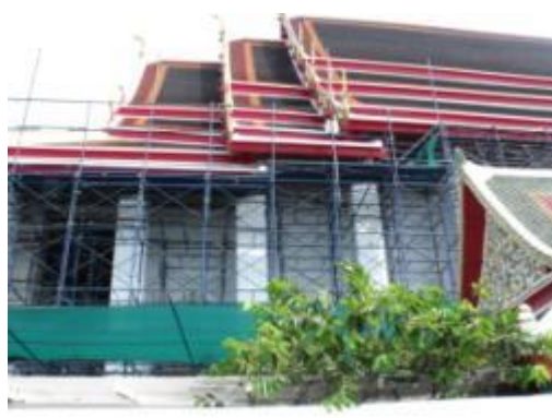
ภาพที่ ๘.๘๙ การแสดงอาคารภายหลังบูรณะ แล้วเสร็จ
