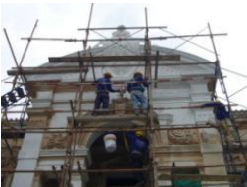
ภาพที่ ง.29 การแสดงทาสีรองพื้นปูนเก่า หลังจากขัดล้าง โป๊วแต่งผิวปูนเก่าเสร็จ
