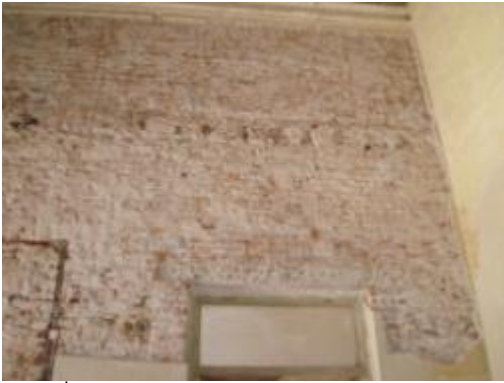
ภาพที่ 4.26 การแสดงผนังก่ออิฐเสียหายเล็กน้อย ยังมีสภาพที่แข็งแรง
