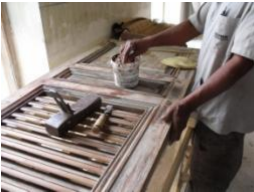
ภาพที่ ช.28 การแสดงอุดช่องว่างระหว่างชิ้นไม้ด้วยกาวไม้ผสมซีเมนต์
