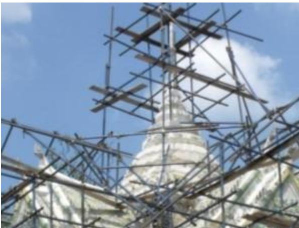
ภาพที่ ๑.67 การแสดงฉาบปูนซ่อมแต่งผิวเดิมที่เสื่อมสภาพ มณฑปพระพุทธบาทจำลอง วัดอมรินทรารามราชวรวิหาร ก่อนทำการประดับด้วยเศษถ้วยชามกระเบื้องเคลือบ
