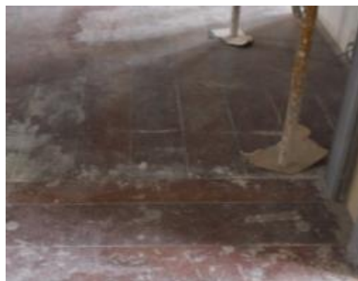
ภาพที่ 5.3 การแสดงความเสียหายที่ผิวไม้เล็กน้อย เนื่องจากการใช้งานและการเสื่อมสภาพของวานิช
