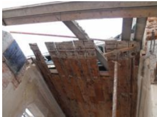
ภาพที่ 6.28 การแสดงความเสียหายของฝ้า เพดานไม้
