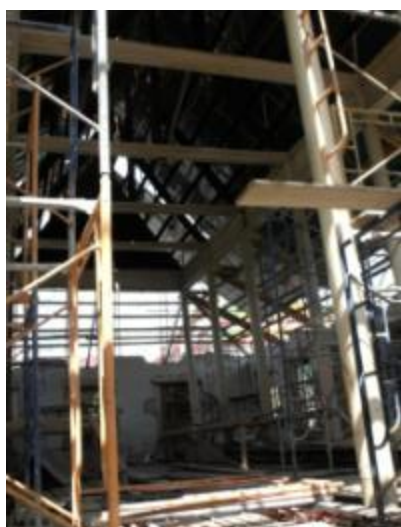
ภาพที่ ๑.51 การแสดงเปลี่ยนไม้จันทันและคานอะเสใหม่ทดแทนส่วนที่เสียหาย
