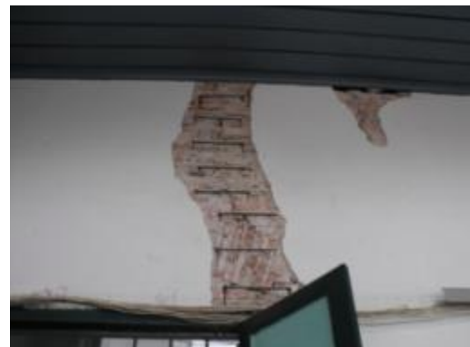
ภาพที่ ค.9 การแสดงเจาะยึดผนังก่ออิฐแนวรอยร้าวด้วยเหล็กเสริมภาพตัว U
