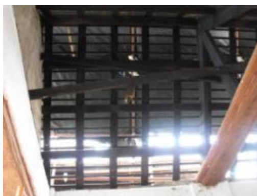
ภาพที่ ๑.๑๐๑ การแสดงหลังคาภายหลังการทาไม้ด้วยน้ำยากันปลวก
