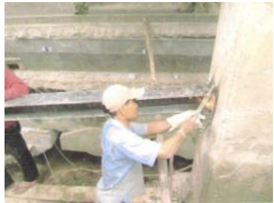
ภาพที่ ค.44 การแสดงยึดเสาดิมชั่วคราวให้มั่นคงระหว่างการยกอาคาร (ที่มา: บริษัทพีเนสส์ ซอยล์ เทคโนโลยี จำกัด, 2551)
