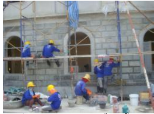
ภาพที่ ง.103 การแสดงติดตั้งปูนปั้นหล่อ สำเร็จ ชั้นสี่เหลี่ยมติดตั้งบนผนังที่ฉาบปูน เสร็จ
