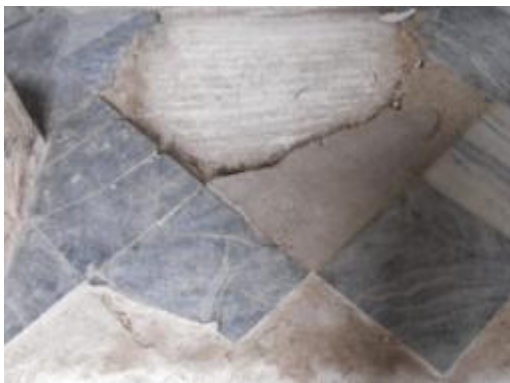
ภาพที่ 5.37 การแสดงปูพื้นหินอ่อนแตกเสียหายมากและหลุดล่อนสูญหาย
