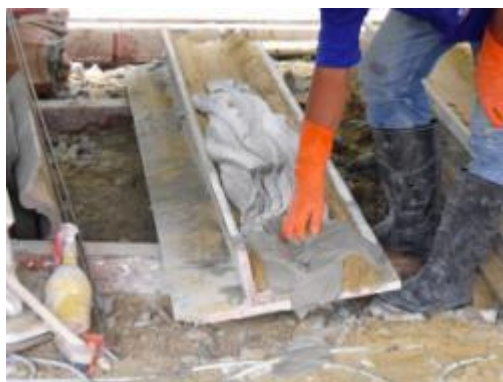
ภาพที่ ง.87 การแสดงเทปูนลงกล่องไม้ที่ไม่มีทรายเป็นแบบหล่อบัวปูนปั้น
