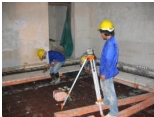
ภาพที่ จ.43 การแสดงตรวจสอบระดับก่อน เทคอนกรีตพื้น
