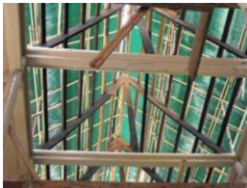
ภาพที่ ๑.52 การแสดงเปลี่ยนไม้จันทันและคานอะเสใหม่ทดแทนส่วนที่เสียหาย
