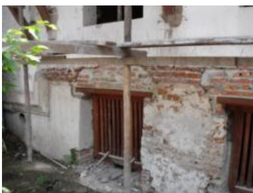
ภาพที่ 2.25 การแสดงช่องระบายความชื้นจากใต้ถุนอาคาร
