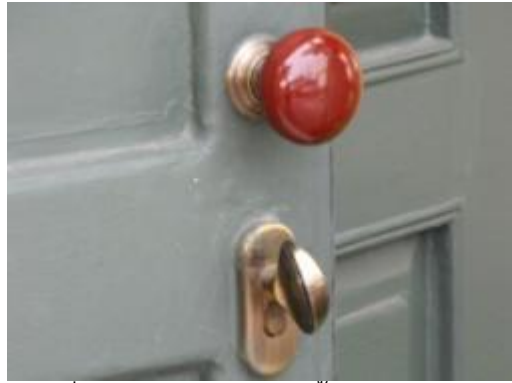
ภาพที่ ช.21 การแสดงติดตั้งอุปกรณ์ประตูใหม่ ผลิตภัณฑ์เลียนแบบอุปกรณ์เดิม
