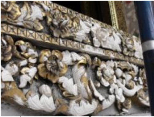
ภาพที่ 4.77 การแสดงปูนปั้นเสียหายเฉพาะส่วน ดำเนินการปั้นปูนทดแทนส่วนที่เสียหาย
