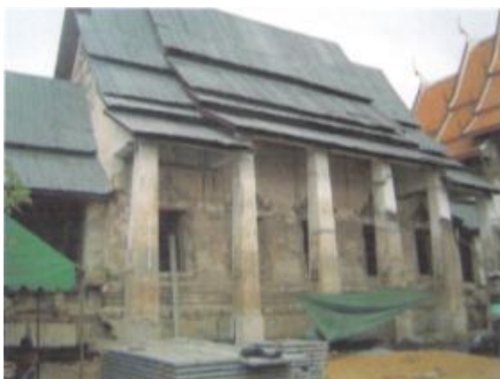
ภาพที่ ค.59 การแสดงพระอุโบสถภายหลังจากดำเนินงานเสริมเสาเข็มฐานรากและยกอาคารขึ้น 2.00 เมตร แล้วเสร็จ(ที่มา: บริษัทพีเนสส์ ซอยล์ เทคโนโลยี จำกัด, 2551)
