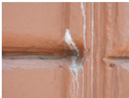
ภาพที่ 4.70 การแสดงน้ำฝนละลายสารยึดเหนี่ยว(แคลเซียมคาร์บอเนต \text{CaCO}_3 ) ของเนื้อปูนฉาบไหลออกมาด้านนอกผนัง
