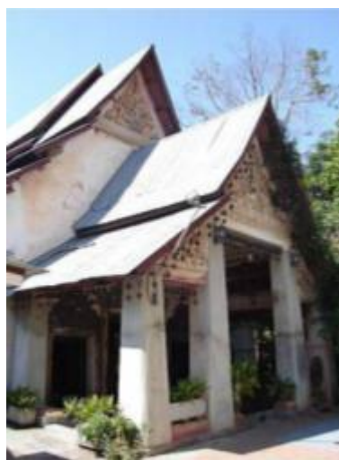
ภาพที่ 3.26 การแสดงรูปด้านหน้าอาคารก่อนดำเนินการบูรณะ(ที่มา: บริษัทพีเนสต์ ซอยล์ เทสติ้ง จำกัด, 2551)
