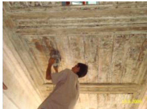
ภาพที่ ฉ.139 การแสดงใช้เครื่องขัดแบบสายพานขัดลอกสีฝ้าเพดาน
