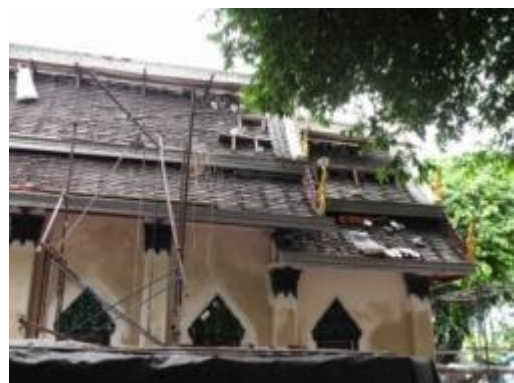
ภาพที่ ๑.66 การแสดงติดตั้งแผ่นกันซึมและซอดไม้ประแนง จันทันและ ไม้เชิงชาย
