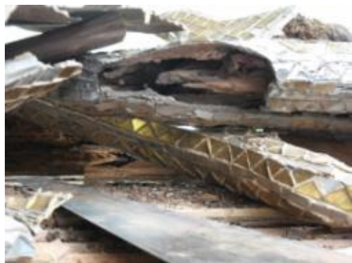
ภาพที่ ๑.47 การแสดงใบระกาผุเสียหายมาก ไม่สามารถนำกลับมาใช้ได้อีก
