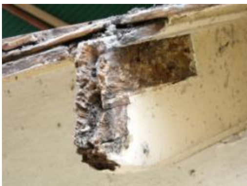
ภาพที่ ๓.๔๐ การแสดงไม้จันทน์ผุเนื่องจาก ความชื้น
