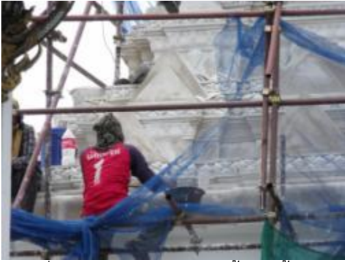
ภาพที่ ง.126 การแสดงติดตั้งปูนปั้นหล่อ สำเร็จแล้วติดตั้ง
