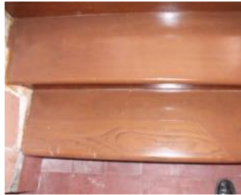
ภาพที่ 5.15 การแสดงการซ่อมเฉพาะ ตำแหน่งไม้ที่เสียหาย
