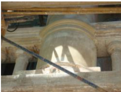
ภาพที่ ง.67 การแสดงฉาบปูนซ่อมบูรณะเสา อาคารเดิมที่เสื่อมสภาพและซ่อมปูนปั้น
