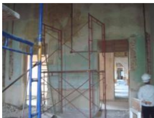
ภาพที่ 4.54 การแสดงตำแหน่งปูนฉาบที่เสียหาย แตกร้าวและล่อนดำเนินการสกัดแล้วฉาบปูนใหม่
