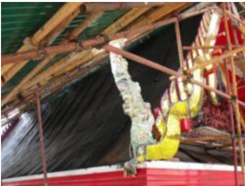
ภาพที่ ๑.62 การแสดงติดตั้งระบบกันซึมหลังคา
