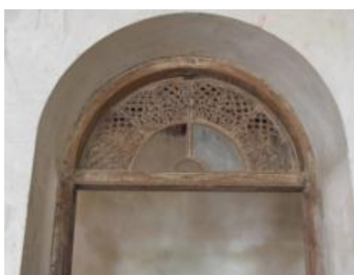
ภาพที่ 7.6 การแสดงลายฉลุเหนือบานประตู หดตัวและกระจกแตก
