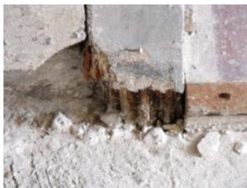
ภาพที่ 7.18 การแสดงลักษณะความเสียหาย ของวงกบไม้เนื่องจากความชื้น
