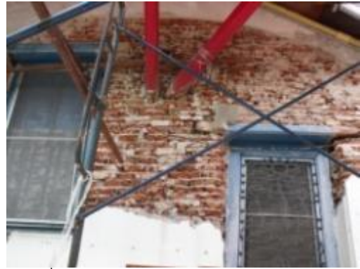
ภาพที่ 4.28 การแสดงผนังก่ออิฐเสียหาย พอรับสภาพได้
