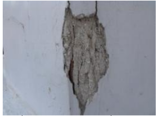
ภาพที่ 4.65 การแสดงปูนฉาบเสื่อมสภาพผุกร่อน
