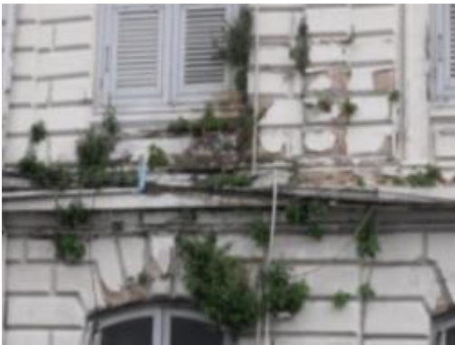
ภาพที่ 4.30 การแสดงผนังก่ออิฐเสียหาย เนื่องจากวัชพืช เสื่อมสภาพเนื่องจากเกลือ ในดินและการชะล้างของฝนกรด
