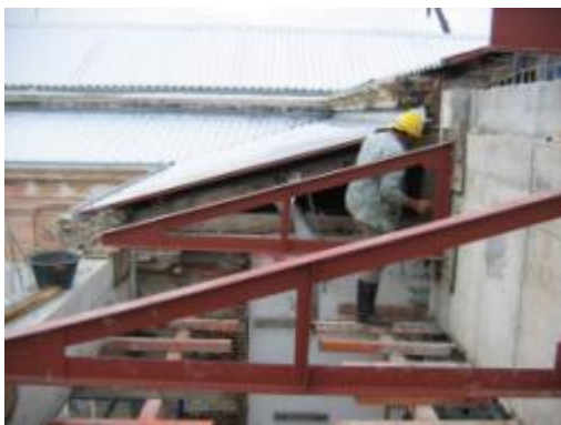
ภาพที่ ฉ.129 การแสดงติดตั้งโครงเหล็ก
