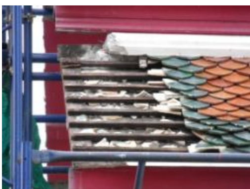
ภาพที่ ฉ.22 การแสดง การร้อยข้อฟ้า ไบระกาหางหงส์และกระเบื้องมุงหลังคา
