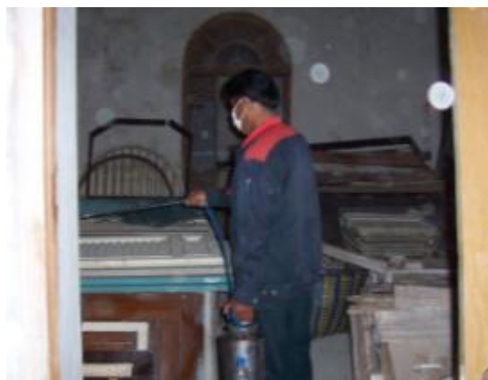
ภาพที่ ข. 48 การแสดงฉีดน้ำยากำจัดปลวกบนวัสดุที่ทำจากไม้เพื่อป้องกันและกำจัดปลวก
