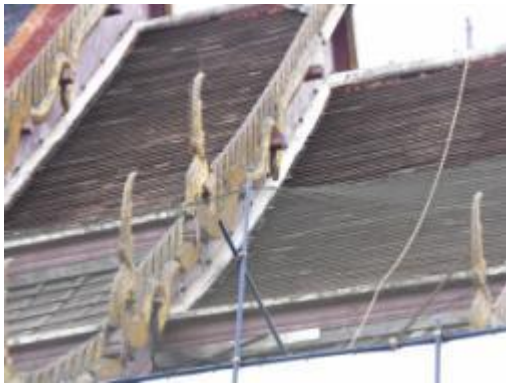
ภาพที่ ๗.๗๙ การแสดงซ่อมบูรณะไม้แปะ ระแนงเปลี่ยนใหม่ส่วนที่เสียหาย
