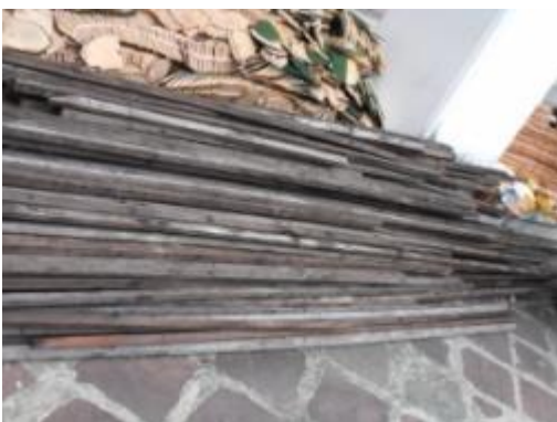
ภาพที่ 6.5 การแสดงไม้แประเนงกระเบื้อง มุงหลังคาผุ ใต้ร่องถอนแล้วใช้ไม้ใหม่ติดตั้ง ทดแทน
