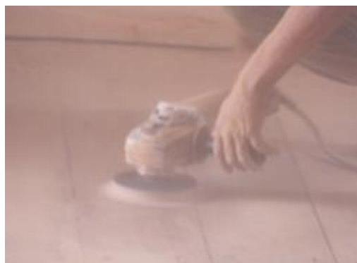
ภาพที่ ๑.4 การแสดงเครื่องมือขัดผิวพื้นไม้ ขั้นตอนการขัดผิวละเอียด
