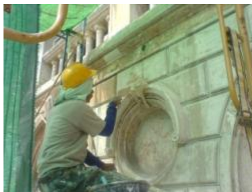
ภาพที่ ง.33 การแสดงฉาบซ่อมแซมผิวผนังตำแหน่งผิวหน้าปูนฉาบเสียหาย
