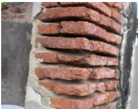
ภาพที่ 4.17 การแสดงความเสียหายของปูนก่อ
