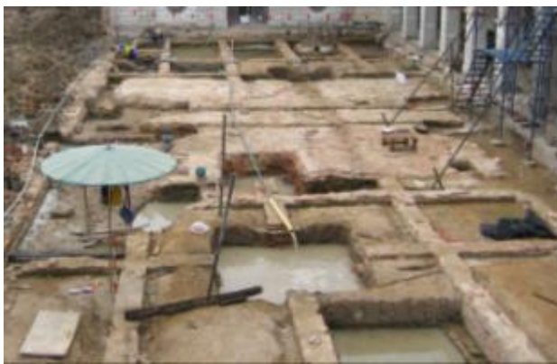
ภาพที่ ช.13 การแสดงฐานรากแบบตารางก่อด้วยอิฐ
