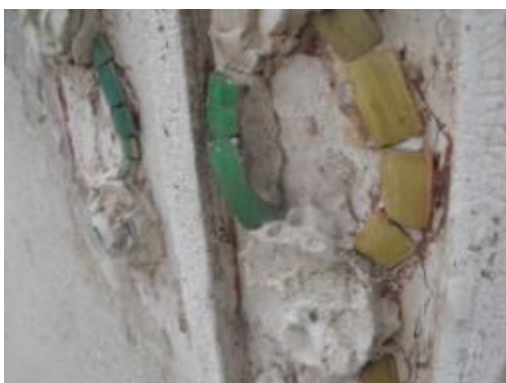
ภาพที่ 5.47 การแสดงผนังอาคารประดับ ด้วยเศษถ้วยชามกระเบื้องเคลือบ มีสภาพ หลอดร่วงและแก้วหมอง
