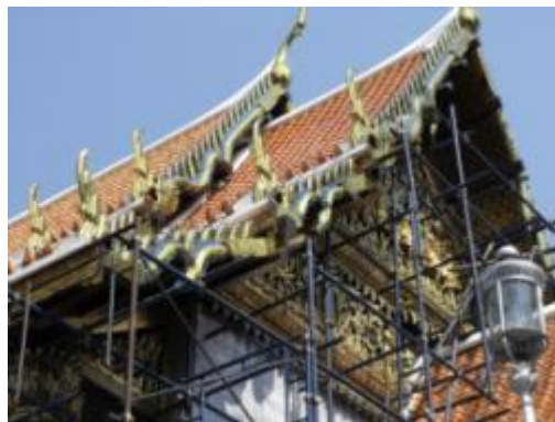
ภาพที่ ฉ.20 การแสดงบูรณะส่วนโครงหลังคาเสร็จ
