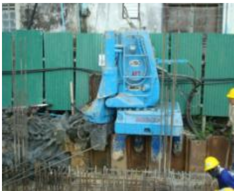
ภาพที่ 3.9 การแสดงลักษณะเครื่องมือ Silent piler ขณะทำการถอน Sheet pile ข้างอาคาร
