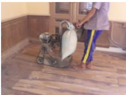
ภาพที่ ๑.2 การแสดงการทำงานของเครื่องขัดผิวพื้นไม้ขณะขัดผิวหยาบ
