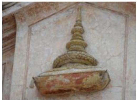
ภาพที่ 4.76 การแสดงปูนปั้นตกแต่งมุม หมอนด้านหนึ่งหลุดหายไป ผิวหน้าปูนปั้น กร่อน ตำแหน่งมุขด้านหน้าอาคารของ โบราณสถาน
