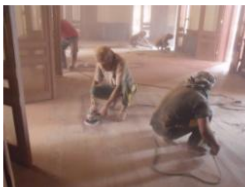
ภาพที่ ๑.3 การแสดงขัดผิวพื้นไม้ ขั้นตอนการขัดผิวละเอียด
