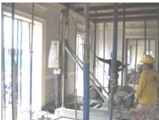
ภาพที่ ค.14 การแสดงขณะตอกเสาเข็ม เหล็กด้วยลูกตุ้มเหล็ก ในตำแหน่งเสริมฐาน รากรับน้ำหนักของกำแพงผนังก่ออิฐรับแรง
