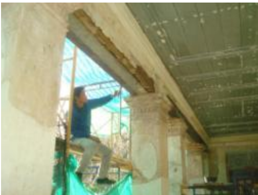
ภาพที่ 4.63 การแสดงปูนฉาบตกแต่งบนผิวไม้หลุดร่วงเสียหายเนื่องจากไม้ภายในผุ
