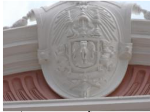
ภาพที่ ง.81 การแสดงปูนปั้นหลังบูรณะซ่อม งาช้างที่แตกแตกหักคืนสภาพเดิม
