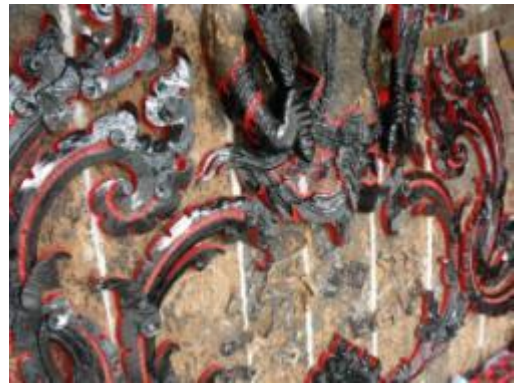
ภาพที่ ๑.64 การแสดงซุดไม้ที่ผุเสียหายออกจากหน้าบันไม้แกะสลัก
