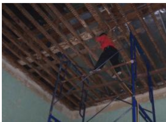
ภาพที่ ข.49 การแสดงฉีดพ่นน้ำยากำจัดปลวกบนโครงฝ้าไม้
