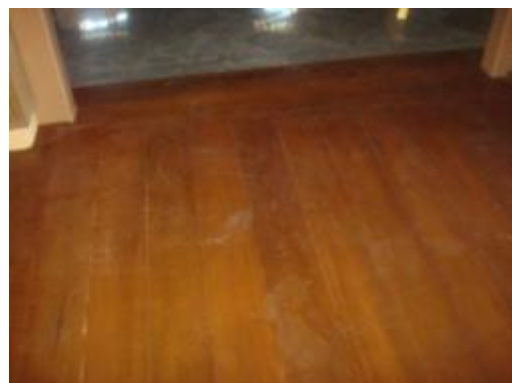
ภาพที่ ๑.10 การแสดงทาโพลียูรีเทนบนพื้นผิว ไม้กระดานเสร็จเรียบร้อยแล้ว
