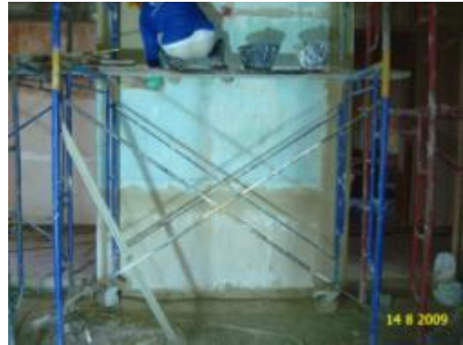
ภาพที่ ง.45 การแสดงฉาบซ่อมผิวผนังเดิมที่ เสียหายโดยซ่อมเฉพาะตำแหน่งที่เสียหาย
