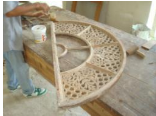
ภาพที่ ช.37 การแสดงซ่อมบูรณะลายฉลุไม้ ที่หัดตัวมีร่องไม้โดยอุดร่องไม้ด้วยกาวไม้ ผสมซีเมนต์
