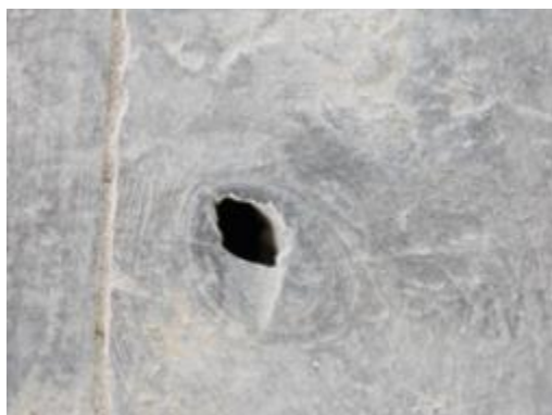
ภาพที่ 5.17 การแสดงความเสียหายของพื้นไม้กระดานเนื่องจากตาไม้หลุด
