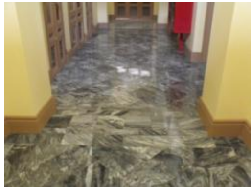
ภาพที่ จ.54 การแสดงหินอ่อนเมื่อติดตั้ง เสร็จ
