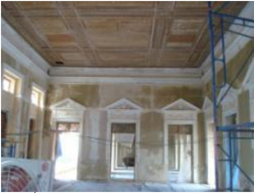
ภาพที่ ง.48 การแสดงซ่อมบูรณะผนังฉาบปูนและซ่อมบัวปูนปั้นเพดานแล้วเสร็จ
