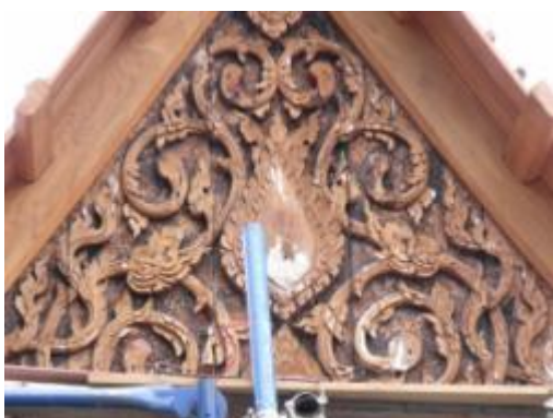
ภาพที่ ฉ.27 การแสดงขุดลอกหน้าบ้านและร้อย ถอนไม้ที่ผุเพื่อบูรณะใหม่
