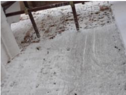
ภาพที่ ง.18 การแสดงราดน้ำปูนที่ผิวอิฐเพิ่มแรงยึดเกาะของปูนฉาบกับผนังอิฐ
