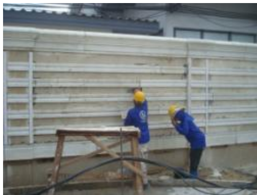
ภาพที่ ง.109 การแสดงติดตั้งบัวสำเร็จรูปที่เสاءแล้วฉาบปูนเสริมตกแต่ง
