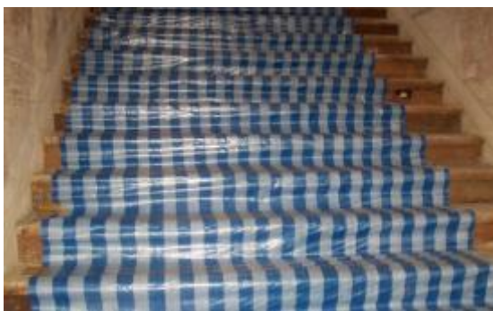
ภาพที่ ข.34 การแสดงผ้าใบพลาสติกปิดคลุมป้องกันผิวบันไดไม้ก่อนการบูรณะ
