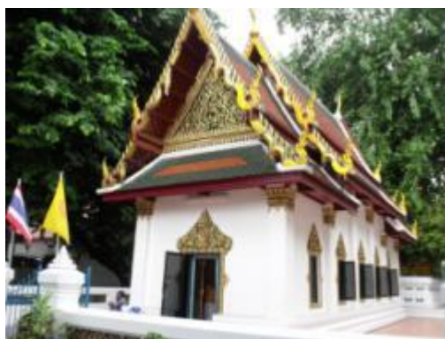
ภาพที่ ๑.72 การแสดงอาคารบูรณะแล้วเสร็จ
