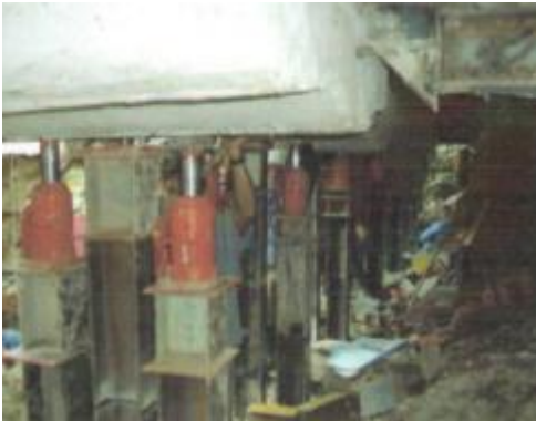
ภาพที่ ค.51 การแสดงเครื่องมือไฮดรอลิกขณะทำการยกอาคาร (ที่มา: บริษัทพีเนสต์ ซอยล์ เทสติ้ง จำกัด, 2551)
