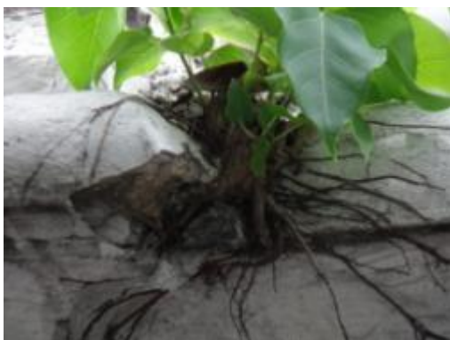
ภาพที่ 4.58 การแสดงไม้ยืนต้นเจริญเติบโตบนผนังและทำลายผนังทำให้ปูนฉาบแตกเสียหาย
