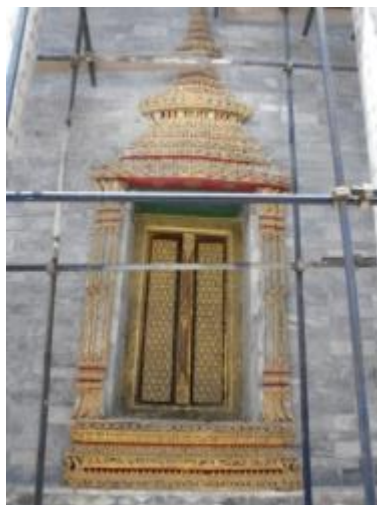
ภาพที่ 4.87 การแสดงปูนปั้นซุ้มหน้าต่างเริ่ม มีการเสื่อมสภาพทำให้ปูนผุกร่อน
