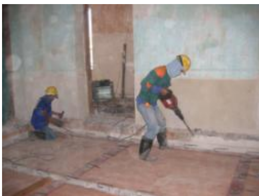
ภาพที่ จ.41 การแสดงสกัดผนังก่ออิฐรับแรง เพื่อให้เป็นจุดรองรับพื้นคอนกรีต
