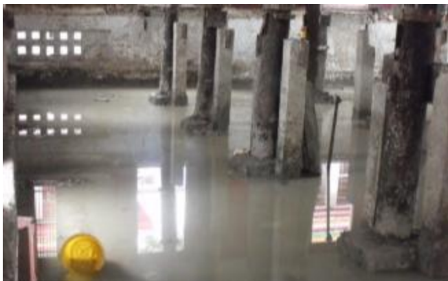
ภาพที่ 2.3 การแสดงลักษณะการทรุดตัวแนวตั้งเท่ากันทั้งอาคารจมลงใต้ดินมีน้ำท่วมขัง
