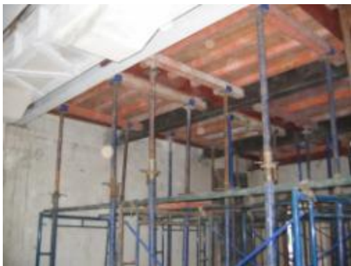
ภาพที่ จ.40 การแสดงตั้งนั่งร้านรองรับไม้ แบบ
