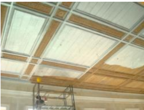
ภาพที่ จ.142 การแสดงโป้วแต่งร่องไม้และ ทาสีรองพื้นฝ้าเพดานป้องกันเชื้อรา
