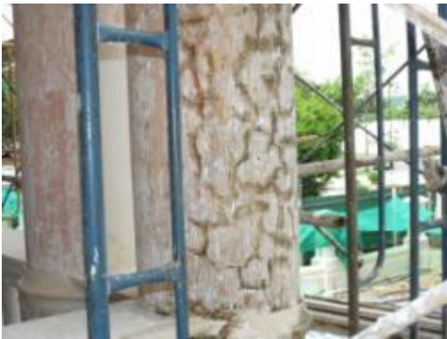
ภาพที่ 4.48 การแสดงตะไคร่น้ำบนผิวปูน ฉาบตามแนวร่องที่แตกกร้าวของผนังฉาบปูน ภายนอกอาคาร
