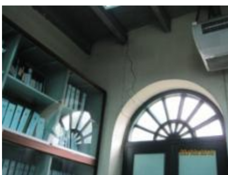
ภาพที่ 3.6 การแสดงลักษณะของรอยร้าวบนผนังภายในอาคารชั้นที่ 1
