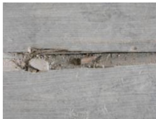
ภาพที่ 5.18 การแสดงพื้นไม้เสียหายจากแรงกระทำจากภายนอก
