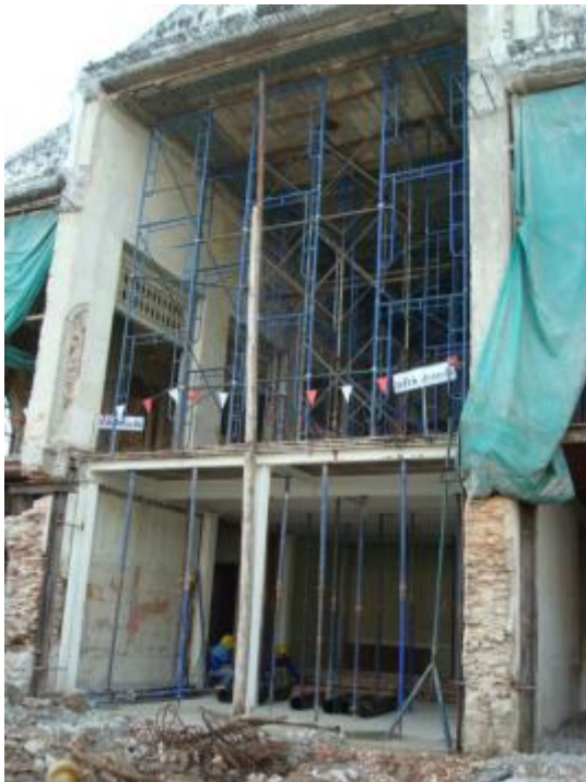
ภาพที่ ข.7 การแสดงค้ำยันโครงสร้างฝ้าเพดาน และพื้นโครงสร้างชั้นที่ 2 ของอาคาร
