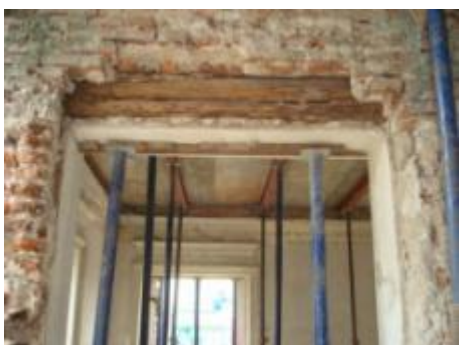
ภาพที่ 4.5 การแสดงคานไม้เหนือช่องเปิดผนังชั้นที่ 1 ภายในอาคาร
