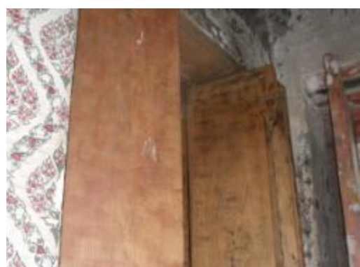
ภาพที่ ข.6 การแสดงขัดผิวไม้ลอกสีเดิมที่ เสื่อมสภาพออกไป
