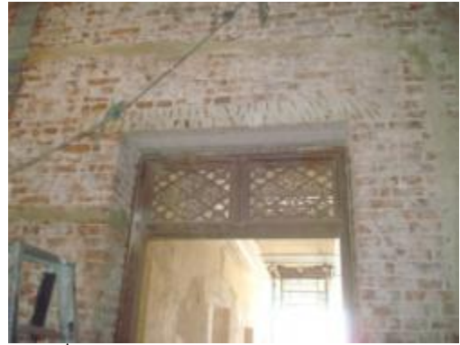
ภาพที่ 4.10 การแสดงคานไม้ฝังในผนังก่อ อิฐรับแรงภายในอาคารชั้นที่ 2 ยังคงมีสภาพ ที่ดี
