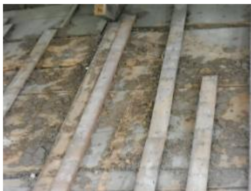
ภาพที่ ๓.๔๒ การแสดงปลวกกัดกินไม้โครง หลังคา
