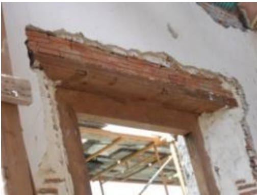
ภาพที่ ง.3 การแสดงไม้ใหม่เปลี่ยนทดแทนไม้เดิมที่เสียหาย เป็นโครงสร้างส่วนที่สามารถมองเห็นได้
