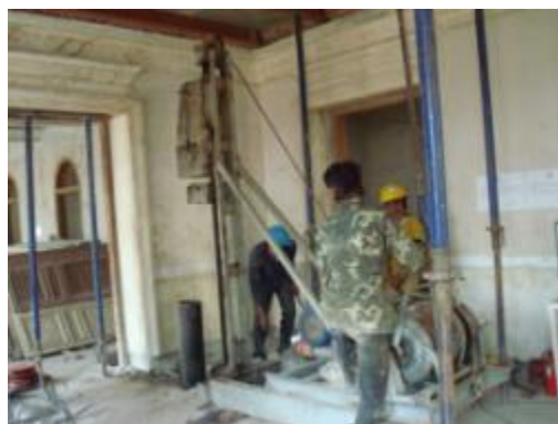
ภาพที่ ค.15 การแสดงขณะตอกเสาเข็ม เหล็กด้วยลูกตุ้มเหล็ก
