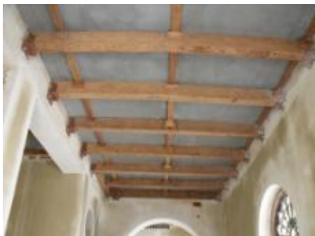
ภาพที่ จ.29 การแสดงวิธีการบูรณะใช้คานไม้เก่ากับพื้นแผ่นไฟเบอร์ซีเมนต์ที่ทับด้วยคอนกรีต หนา 5 เซนติเมตร
