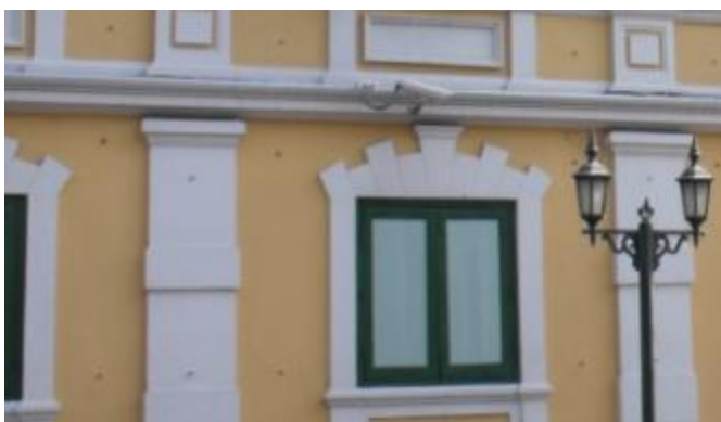
ภาพที่ 4.2 การแสดงการฝังท่อระบายความชื้นในผนัง ของอาคารกระทรวงกลาโหม
