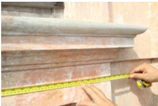
ภาพที่ ข. 5 แสดงการสำรวจวัดสภาพ ปัจจุบันของอาคารใช้เป็นข้อมูลสำหรับการ เขียนแบบสภาพปัจจุบันของอาคาร โบราณสถาน
