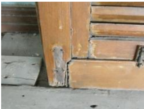
ภาพที่ 7.13 การแสดงลักษณะความเสียหาย ของบานหน้าต่าง
