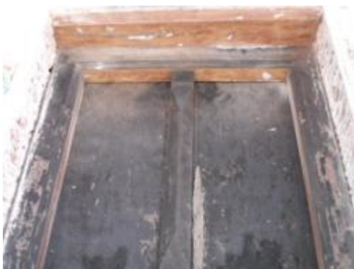
ภาพที่ 7.2 การแสดงบานประตูและวงกบ ผิวหน้าผุเสียหายเนื่องจากความชื้น
