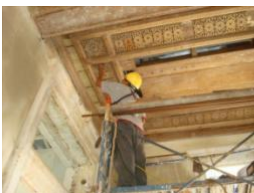
ภาพที่ ฉ.155 การแสดงติดตั้งไม้ฉลุใหม่ทดแทนไม้ฉลุหายเดิมที่สูญหาย
