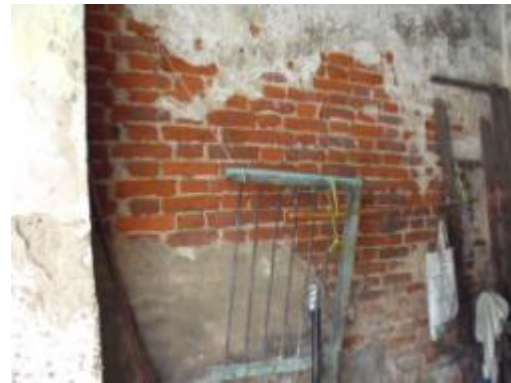
ภาพที่ 4.22 การแสดงความเสียหายของปูนก่อผนังรับแรง
