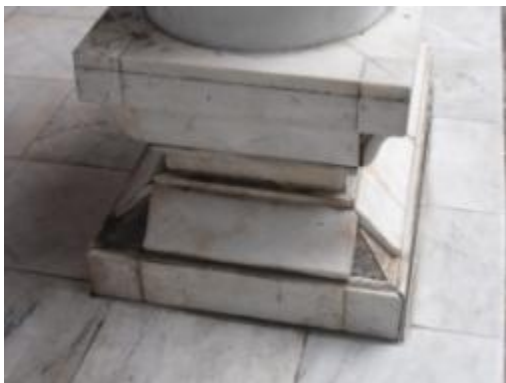
ภาพที่ 5.43 การแสดงหินอ่อนประดับโคน เสาหลุดร่วงเสียหาย
