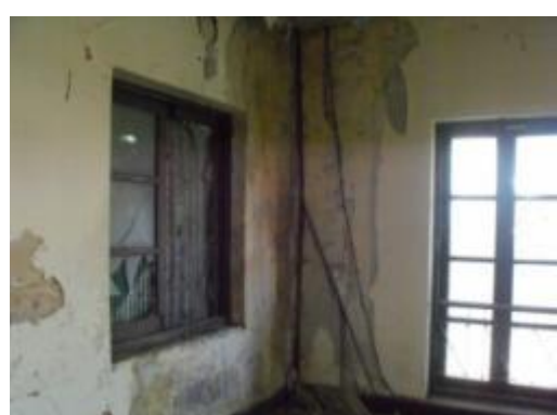
ภาพที่ ข.28 การแสดงรากของต้นไทรหยั่งรากจากหลังคาทะลุกำแพงชั้นที่ 2 และชั้นที่ 1 ของอาคารลงสู่ดิน ได้ทำลายโครงสร้างพื้นไม้ของอาคาร
