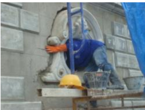
ภาพที่ ง.102 การแสดงติดตั้งปูนปั้นหล่อ สำเร็จ
