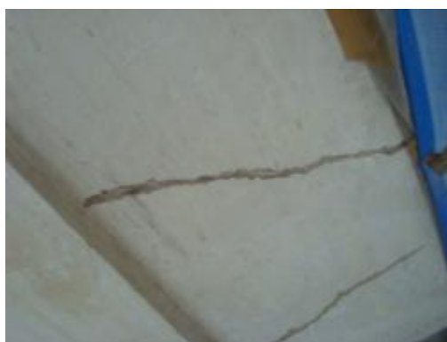
ภาพที่ ง.26 การแสดงสักรัดตามแนวร่องที่แตกร้าวแล้วซ่อมด้วยปูนส่วนผสมปูนหมัก
