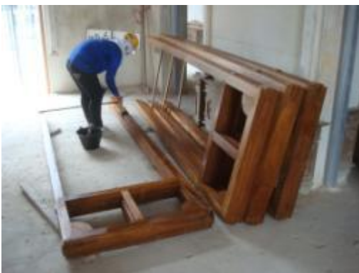
ภาพที่ ช.41 การแสดงวงกบประตูที่ผลิตใหม่ และทาน้ำยาป้องกันปลวก
