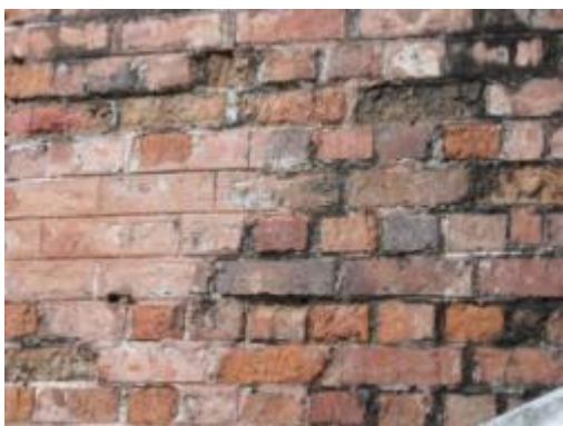
ภาพที่ 4.69 การแสดงความเสียหายของผนังปูนฉาบเนื่องจากสาเหตุของเกลือตกผลึกที่ผิวหน้าและฝนกรดกัดกร่อน
