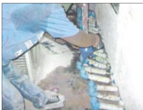
ภาพที่ ง.2 การแสดงเติมสารเคมีเพื่อลดความชื้นของผนัง (ที่มา: ศิวกรการช่าง จำกัด, 2552)
