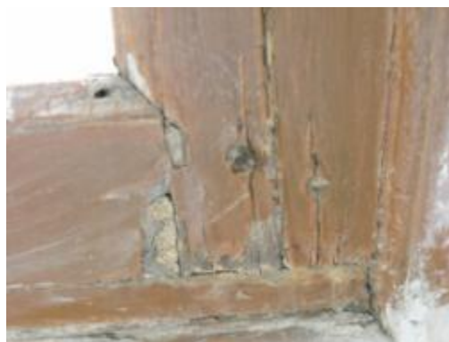
ภาพที่ 7.12 การแสดงลักษณะความเสียหายของบานประตู
