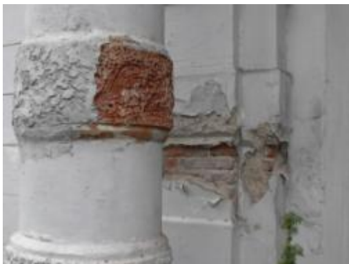
ภาพที่ 4.85 การแสดงการเสื่อมสภาพของ ปูนปั้นเนื่องจากเกลือในดินและฝนกรด
