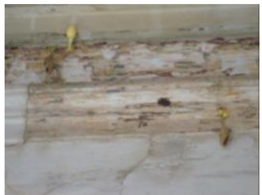
ภาพที่ 4.61 การแสดงผนังผุกร่อนและมีเห็ดราเจริญเติบโตบนผนัง
