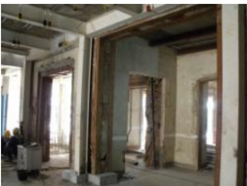
ภาพที่ 4.9 การแสดงเสาไม้ฝังในผนังก่ออิฐ รับแรงผู้ตำแหน่งผนังชั้นที่ 1
