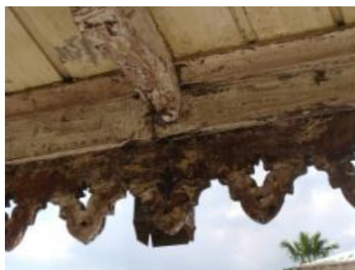
ภาพที่ 6.13 การแสดงความเสียหายของเชิงชาย
