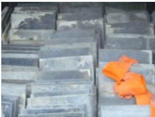
ภาพที่ 5.33 การแสดงหินอ่อนที่รื้อถอนออก เนื่องจากปูนที่ใช้กรุเสื่อมสภาพและผิวหน้ามัวหมอง
