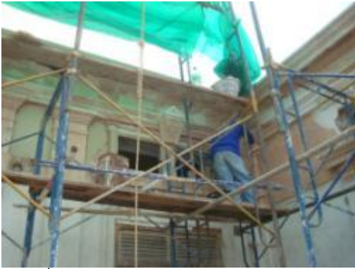
ภาพที่ ง.34 การแสดงซ่อมแต่งผิวผนังด้วย ปูนฉาบส่วนผสมปูนหมัก
