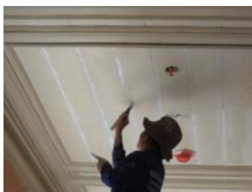
ภาพที่ ฉ.158 การแสดงโป๊วแต่งร่องไม้ด้วยเคมีภัณฑ์โป๊วแต่งผิวไม้
