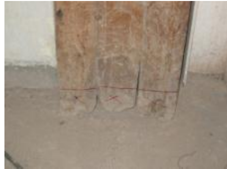
ภาพที่ 5.9 การแสดงความเสียหายของแผ่นพื้นไม้กระดานที่สัมผัสกับความชื้น ตำแหน่งประตูระเบียงภายนอก
