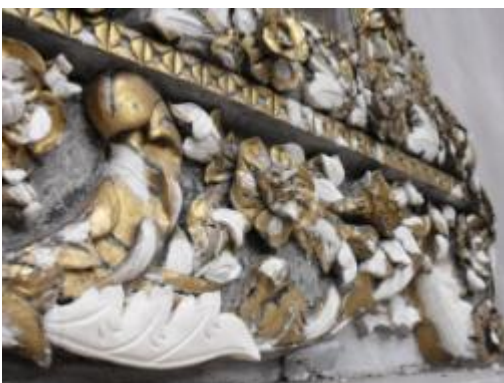
ภาพที่ ง.76 การแสดงช่อมแซมปูนปั้น บางส่วนที่เสียหาย
