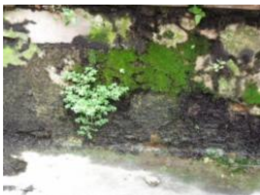
ภาพที่ 4.83 การแสดงพืชเจริญเติบโตบนปูนปั้นจนไรกรากทำลายเนื้อปูนปั้น
