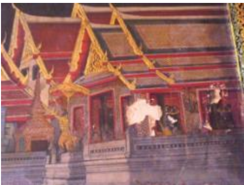
ภาพที่ 4.42 การแสดงผนังปูนเสื่อมสภาพเสียหายตำแหน่งที่มีภาพจิตรกรรมฝาผนัง
