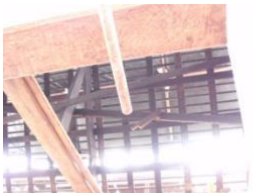
ภาพที่ ๑.๑๐๐ การแสดงหลังคาภายหลังการเปลี่ยนไม้จันทัน คานอะเสและติดตั้งแปไม้เสร็จ
