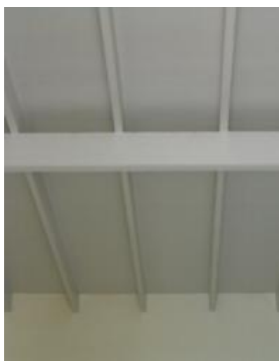
ภาพที่ จ.35 การแสดงโครงสร้างไม้ภายหลัง ประกอบติดตั้งและทาสีเสร็จ
