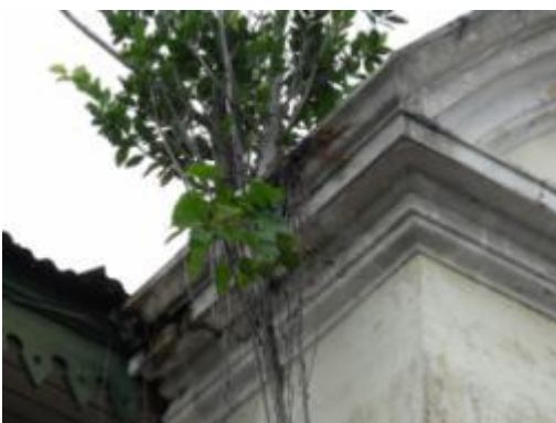
ภาพที่ ข.25 การแสดงต้นไทรที่เจริญเติบโตบนหลังคา แล้วหยั่งรากลงดินจากหลังคาโดยทำลายผิวผนังบางส่วน
