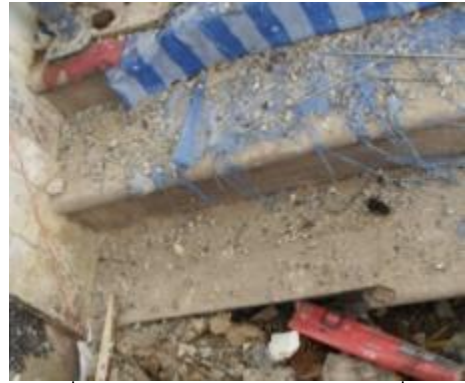
ภาพที่ 5.14 การแสดงไม้แตกหัก เนื่องจาก ถูกแรงภายนอกกระทำ
