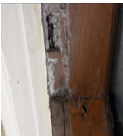
ภาพที่ 7.20 การแสดงลักษณะความเสียหายของวงกบไม้เนื่องจากความชื้น
