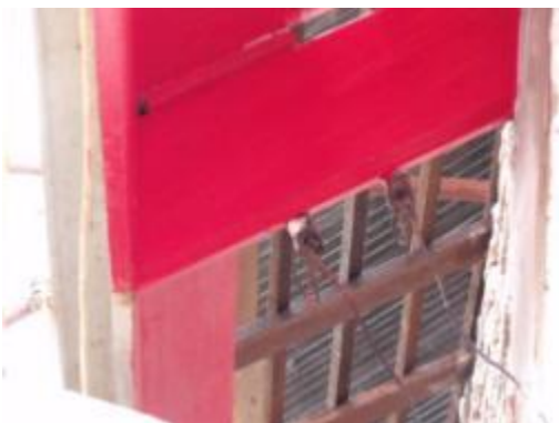
ภาพที่ ฉ.91 การแสดงรีถอนไม้ส่วนที่เสียหายออก
