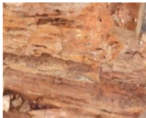
ภาพที่ 5.16 การแสดงปลวกกัดกินคานไม้ เสียหาย
