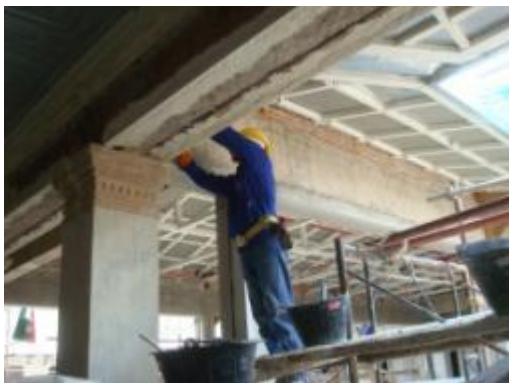
ภาพที่ ง.61 การแสดงจับเชื่อมก่อนฉาบปูน
