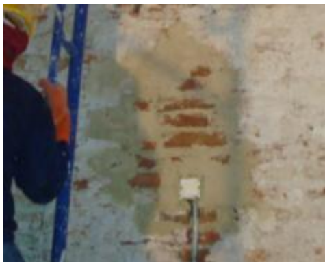
ภาพที่ ง.16 การแสดงซ่อมเปลี่ยนอิฐใหม่
