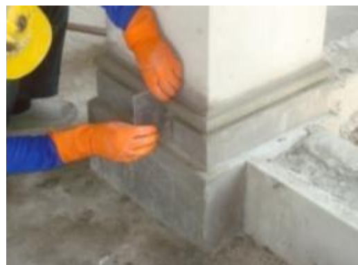
ภาพที่ ง.105 การแสดงใช้แผ่นอะคริลิคปั้น แต่งบัวหล่อในที่
