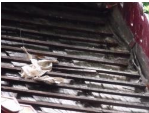
ภาพที่ ๑.67 การแสดงติดตั้งแผ่นกันซึมและไม้แป
