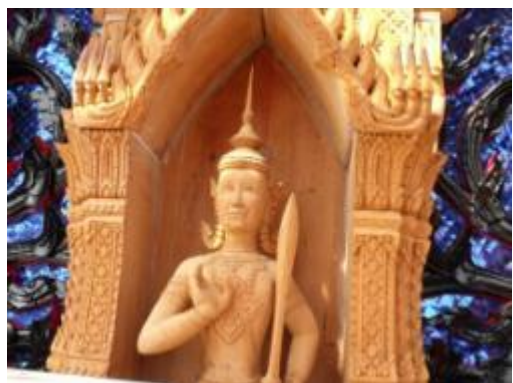
ภาพที่ ฉ.36 การแสดงติดตั้งไม้แกะสลักหน้าบันทดแทนไม้เดิมที่ผุ
