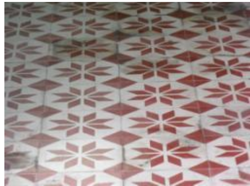
ภาพที่ จ.62 การแสดงกระเบื้องซีเมนต์ที่ปูแล้วเสร็จ
