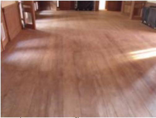
ภาพที่ ๑.5 การแสดงพื้นไม้หลังจากขัดผิวหน้า ละเอียดเสร็จก่อนอุดปิดร่องไม้ด้วยดินสอพอง
