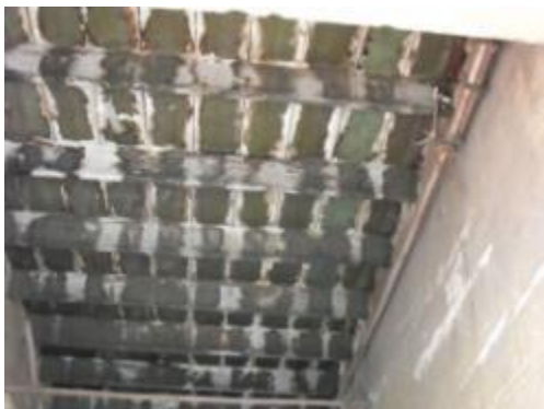
ภาพที่ 5.21 การแสดงลักษณะความเสียหายของพื้นไม้ก่อนรื้อถอน
