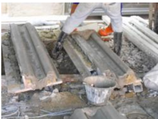
ภาพที่ ง.90 การแสดงแต่งผิวปูนด้วยการกด แผ่นอะคริลิคและลากไปมาจนได้รูปร่างบัว ปูนปั้นหล่อสำเร็จ
