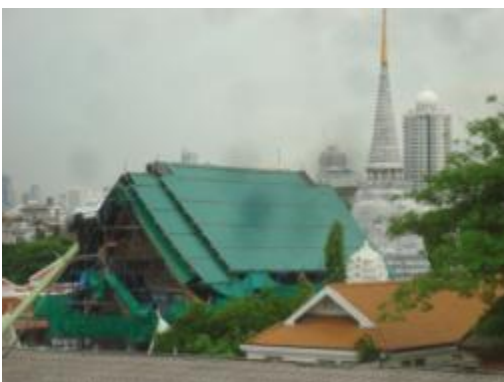
ภาพที่ ข.17 การแสดงปิดคลุมด้วยแผ่นสังกะสีชั่วคราวป้องกันฝนเต็มพื้นที่ของหลังคาอาคารที่วัดราชประดิษฐ์
