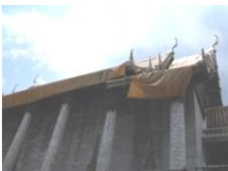
ภาพที่ ข.13 การแสดงใช้ผ้าใบคลุมหลังคาชั่วคราวเพื่อป้องกันน้ำฝน
