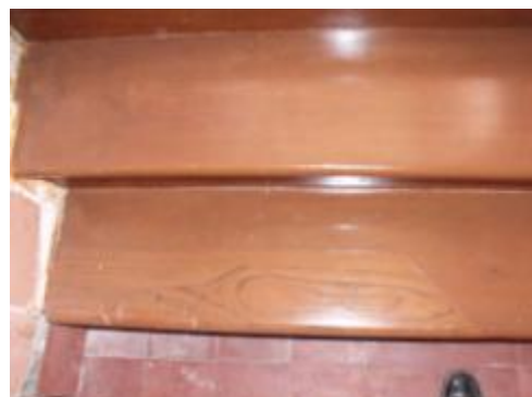
ภาพที่ ๑.17 การแสดงซ่อมบูรณะด้วยไม้ใหม่เฉพาะส่วนที่เสียหาย
