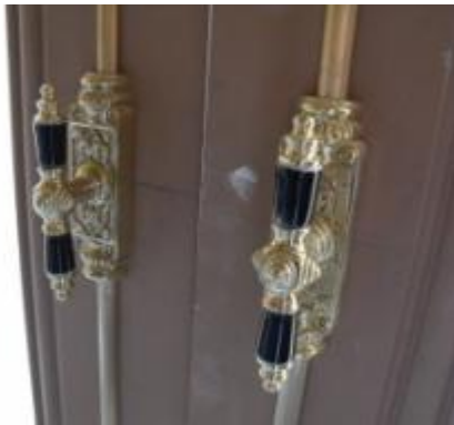
ภาพที่ ช.20 การแสดงติดตั้งอุปกรณ์ประตูใหม่ ผลิตภัณฑ์เลียนแบบอุปกรณ์เดิม
