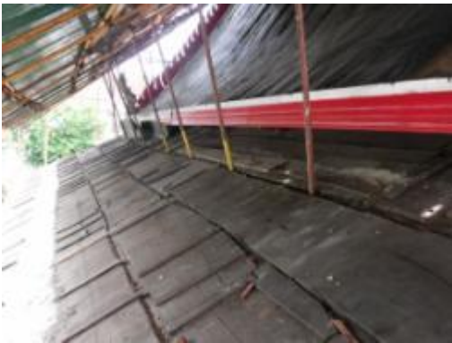
ภาพที่ ฉ.56 การแสดงติดตั้งแผ่นกันซึม หลังคา
