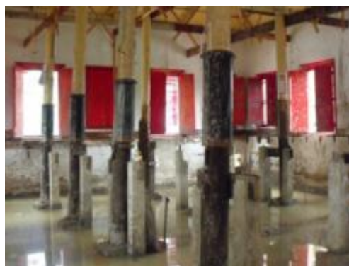
ภาพที่ 5.20 การแสดงคานและพื้นไม้เสียหายได้รั้วถอนออกไปแล้วจึงประกอบบูรณะติดตั้งใหม่
