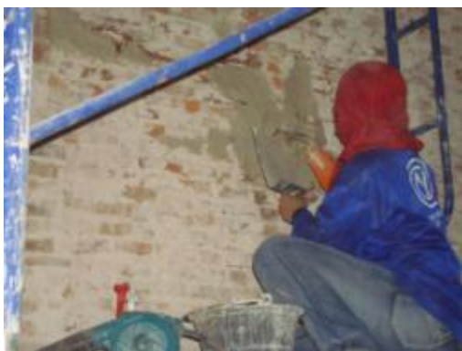
ภาพที่ ง.20 การแสดงเตรียมฉาบปูน หลังจากที่ได้ซ่อมร่องปูนสอที่เสื่อมสภาพ
