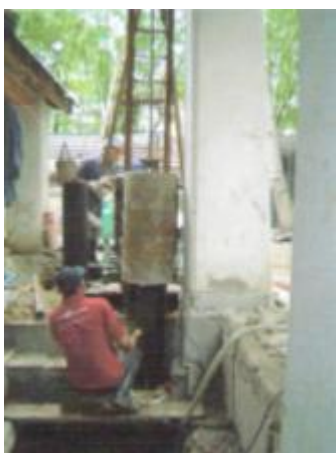
ภาพที่ ค.40 การแสดงตอกเสาเข็มเหล็กเพื่อรับน้ำหนักจากเสาด้านหน้าอาคาร(ที่มา: บริษัทพีเนสส์ ซอยล์ เทคโนโลยี จำกัด, 2551)
