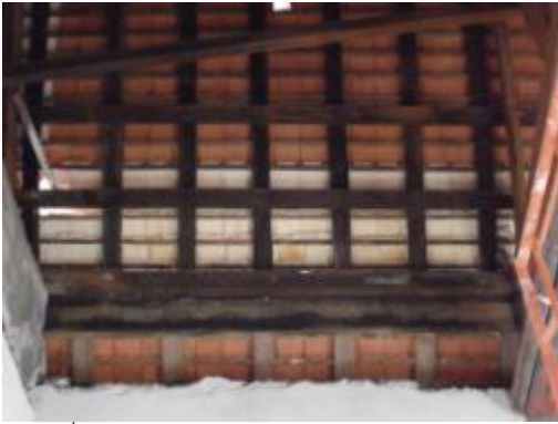
ภาพที่ ๑.102 การแสดงมุงหลังคาด้วย กระเบื้องใหม่
