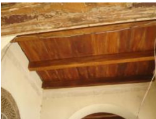
ภาพที่ ช.26 แสดงการติดตั้งคานและพื้นไม้โดยถ่ายแรงสู่ผนังก่ออิฐรับแรง
