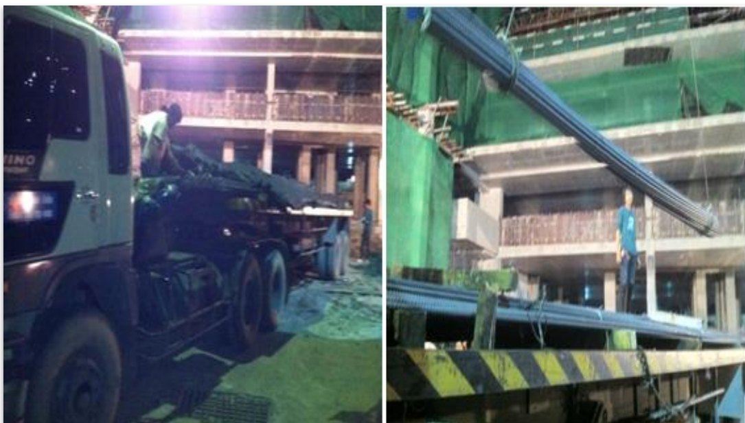
ภาพที่ 3-11 ชนิดรถที่ใช้ขนส่งและวิธีการขนถ่ายเหล็กเส้น
