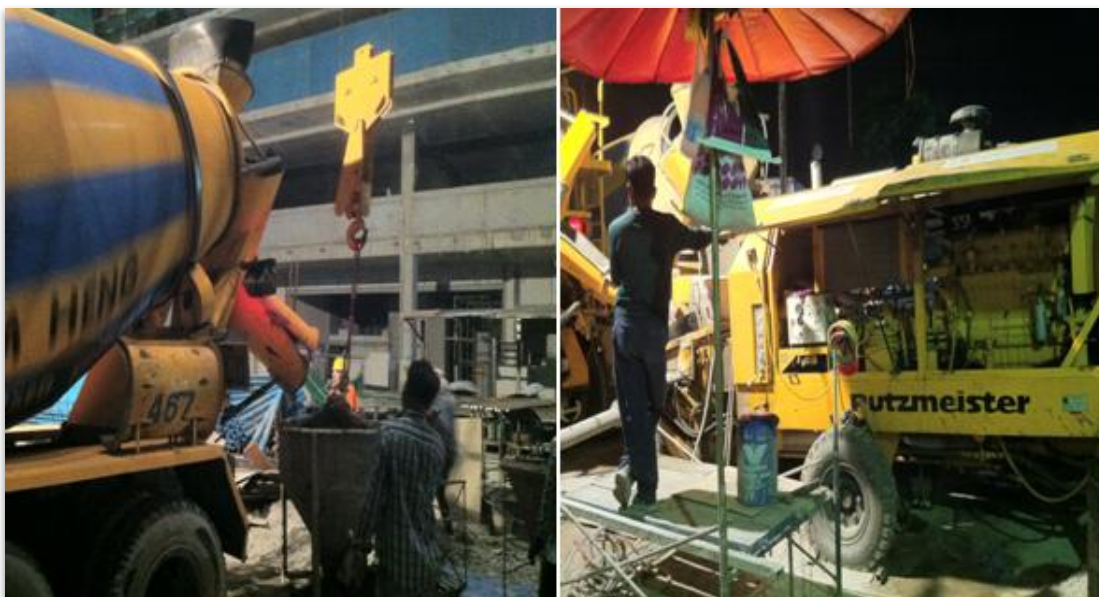
ภาพที่ 3-13 การขนถ่ายคอนกรีตด้วย พ็อกเก็ตหัวปูน และ ปัมป์ย้งคอนกรีต
