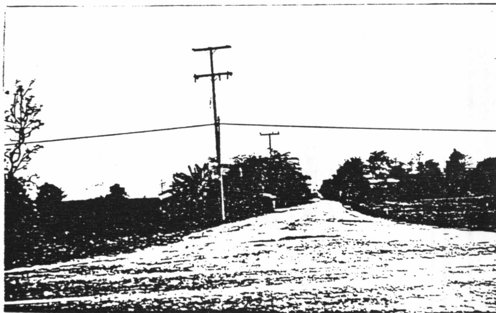
รูปที่ 6.13 สภาพของถนนทางเข้าด้านข้างของที่ดินแปลง D ซึ่งจะมีสายไฟฟ้าผ่านตลอดแนวของถนน
