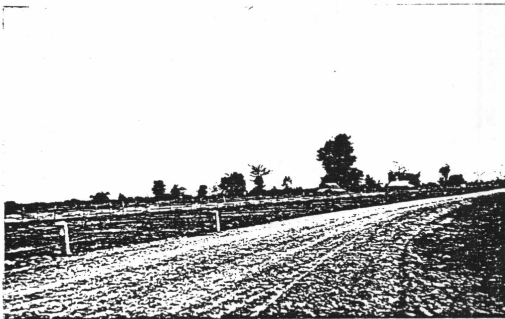
รูปที่ 6.19 ถนนทางเข้าที่ดินยี่วงที่สองจากสะพานข้ามแม่น้ำกวังไปอีกประมาณ 600 เมตร ถึงที่ดินแปลง F เป็นถนนลูกรังกว้างประมาณ 7.00 เมตร
