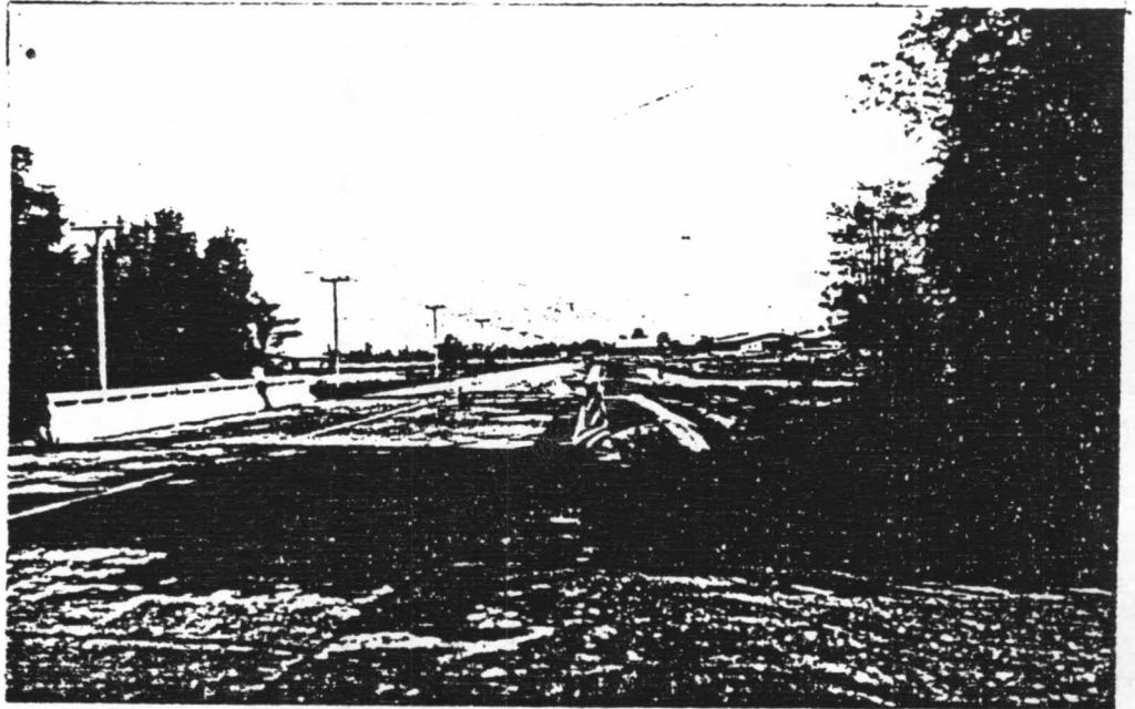
รูปที่ 6.7 ภาพถ่ายของถนนสายสาขาน-ป่าช้าง ที่ตัดผ่านหน้าที่ดินแปลง B ซึ่งได้ทำการก่อสร้างใหม่ ซึ่งจะมีสายไฟฟ้าวิ่งผ่านตลอดแนวของถนนไปจนถึงป่าช้าง
