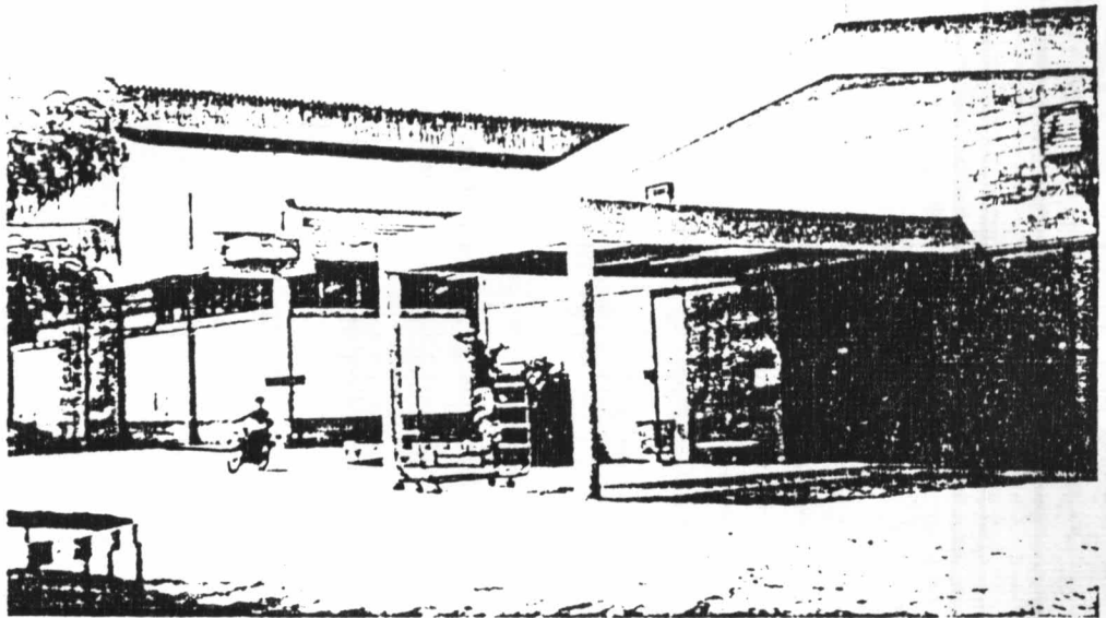
รูปที่ 4.16 บริเวณพื้นที่ภายในโรงงาน บริษัทไวยาเอเชียอาคเนย์ จำกัด
