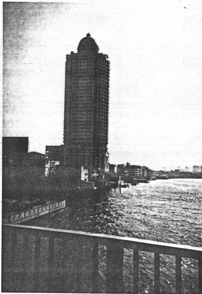
ภาพที่ 9 อาคารชุดพักอาศัยระดับสูงบริเวณแขวงจักรวรรดิ
