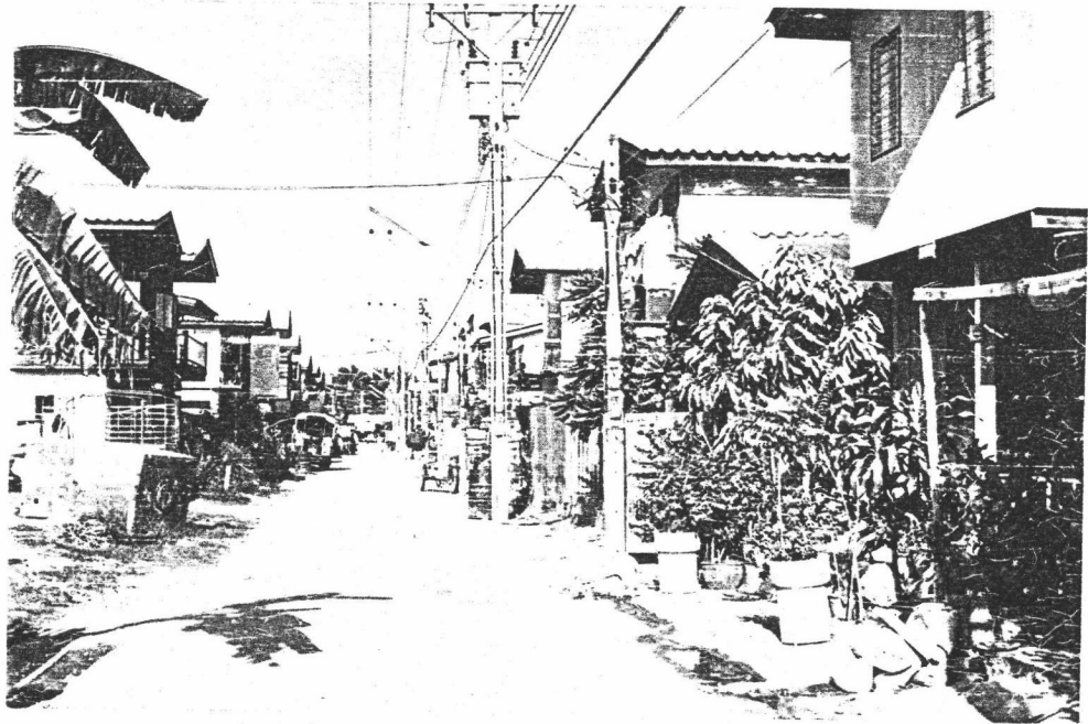
รูปที่ 17 สภาพบ้านพักอาศัยครึ่งไม้ครึ่งกระเบื้อง ภายในโครงการพัฒนากรรมเกล้า
