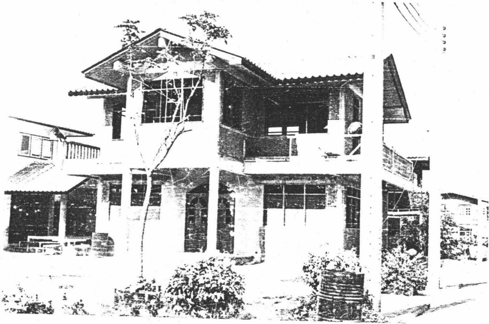
รูปที่ 15 บ้านพักอาศัย 2 ชั้นที่กำลังปลูกสร้างภายในโครงการพื้นที่นครรมเกล้า ปลูกสร้างด้วย อิฐ-ปูน
