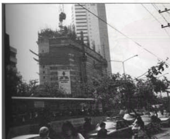
โครงการ-RAIMOND TOWER
