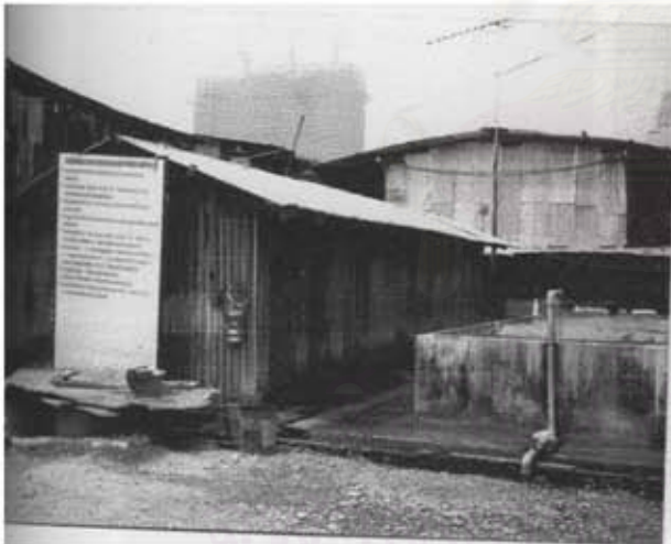
บ่อน้ำคอนกรีตรวมและห้องต้ม
