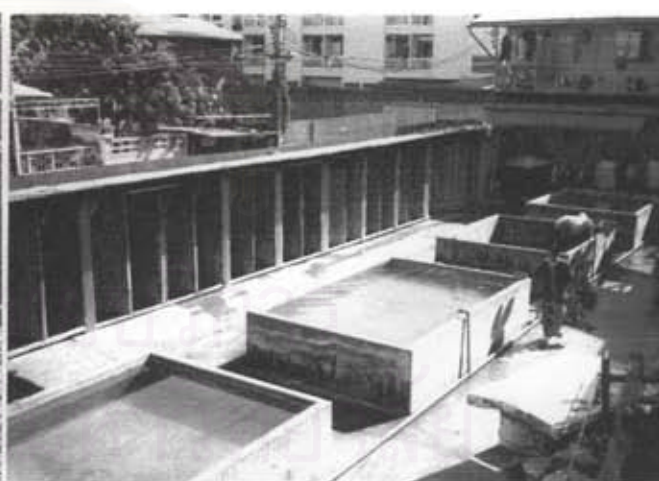
บ่อน้ำคอนกรีตรวมและห้องส้วม
