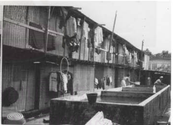
บ่อน้ำคอนกรีตรวมและห้องพักแบบ 2 ชั้น
