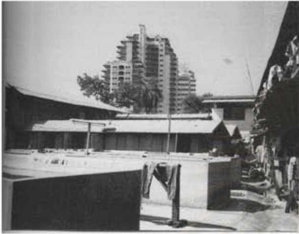
บ่อน้ำคอนกรีตรวม
