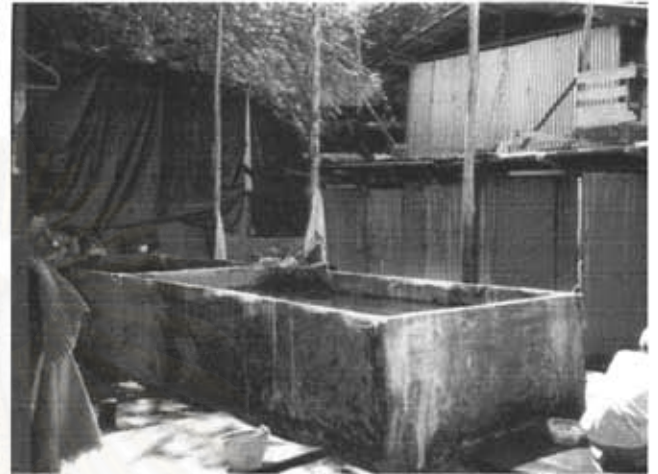
บ่อน้ำคอนกรีต (อาบและซักล้าง)
