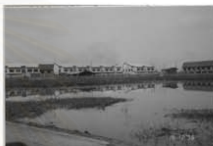
ปัญหาการก่อสร้างที่อยู่อาศัยขวางทางน้ำไหล
