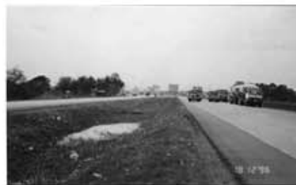
สภาพทางหลวงแผ่นดินหมายเลข 37 มี 4 ช่องจราจร
