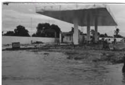
ป็นน้ำมันอยู่ระหว่างการก่อสร้างถูกน้ำท่วม
