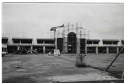
ตลาดเพชรฉวีระหว่างการก่อสร้าง
