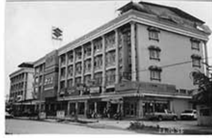
อาคารพาณิชย์บริเวณถนนบางกรวย-ไทรน้อย เขตเทศบาล
