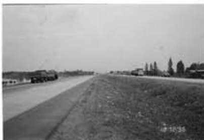
สภาพทางหลวงแผ่นดินหมายเลข 37 มี 4 ช่องจราจร
