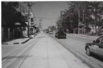
ถนนบางกรวย-ไทรน้อยช่วงเทศบาลขยายจาก 2 เป็น 4 ช่องจราจร
