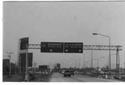
จุดตัดถนนสาย 340 กับถนนสาย 345 (ขาเข้ากรุงเทพฯ)
