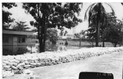
เทศบาลเมืองบางบัวทองนำกระสอบทรายมากั้น ถนน บางกรวย-ไทรน้อยเพื่อแก้ปัญหาน้ำท่วม
