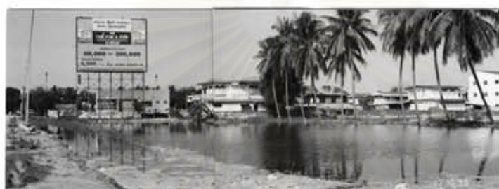
บริเวณเดียวกันกับรูปบนประสบปัญหาน้ำท่วม
