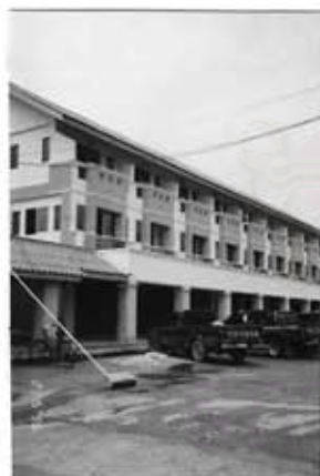
อาคารพาณิชย์บริเวณตลาดเพชรฉวี
