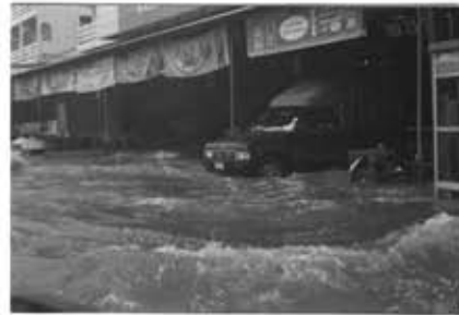
อาคารพาณิชย์ได้รับความเสียหาย
