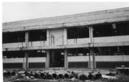
ตลาดเพชรฉวีระหว่างการก่อสร้าง
