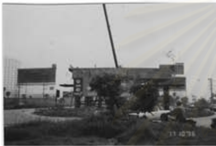
การก่อสร้างสะพานข้ามแยกบางใหญ่ ส่วนหนึ่งของโครงการมอเตอร์เวย์บางใหญ่-ราชบุรี
