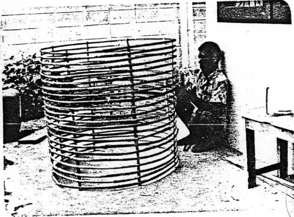
รูปที่ 4.9 การผูกมัดยึดโครงไม้ไผ่
