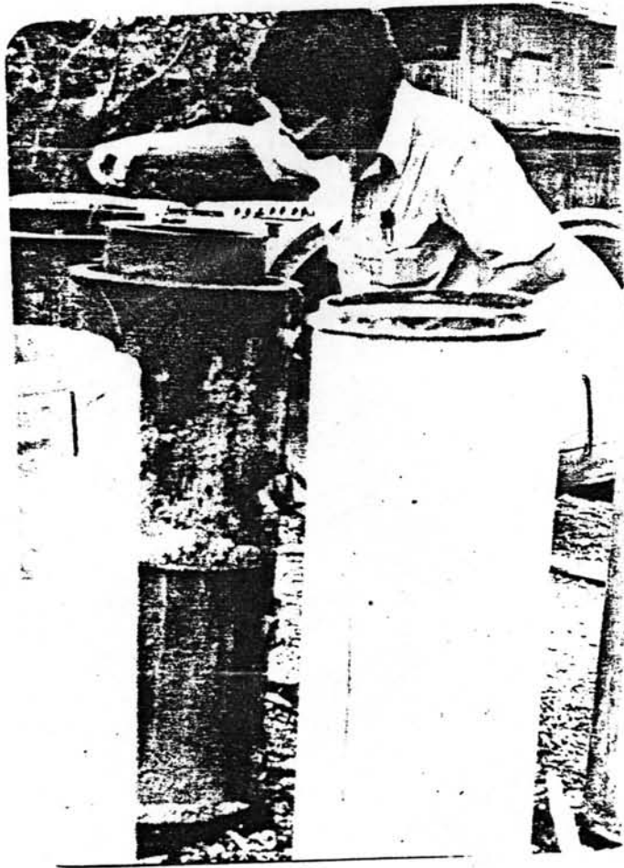
รูปที่ 6.3 ท่อเมื่อถอดแบบออกแล้ว
