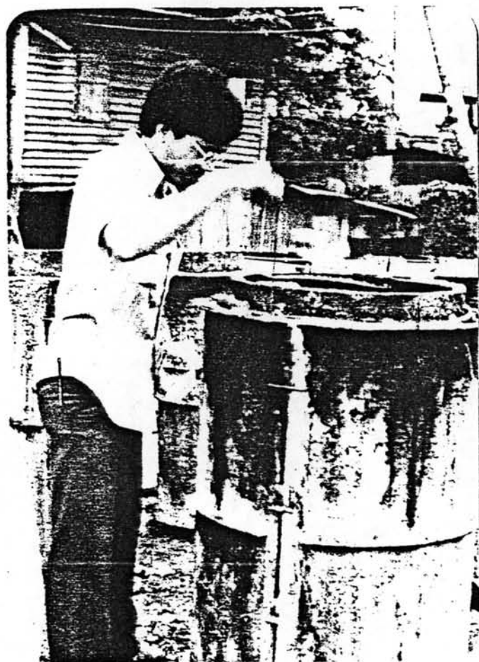
รูปที่ 6.2 การกระทุ้งคอนกรีตให้แน่น
