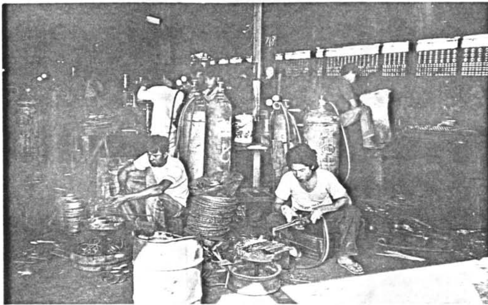
๘๘ คนงานกำลังตัด โลหะแผ่นออกเป็น รูปทรงต่างๆ กัน ด้วยเครื่องตัดแก๊ส
