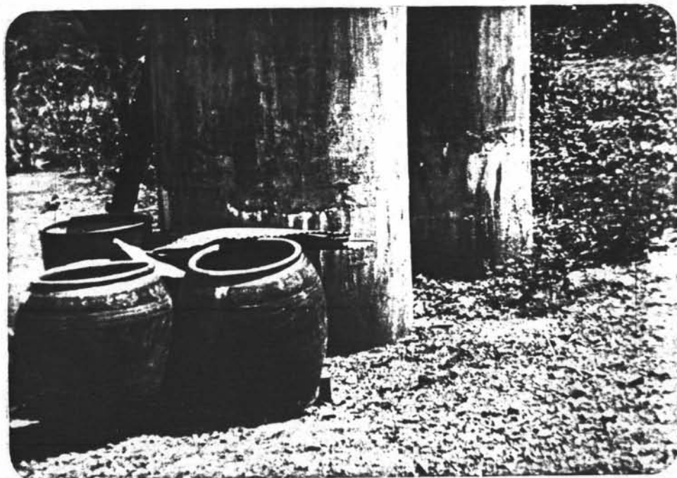
รูปที่ 4.2 แสดงลักษณะของภาชนะแบบต่าง ๆ ที่ใช้ใส่น้ำ เช่น โถงขนาดต่าง ๆ ถึง 200 ลิตร และถังเก็บน้ำคอนกรีตขนาด 2 ลบ.ม. ขึ้นไป
