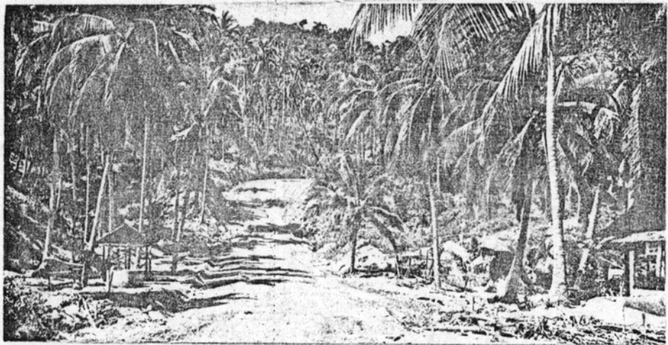
ภาพที่ ๕ สภาพของถนนปัจจุบัน (สายรอบเกาะ) ซึ่งเป็นถนนดิน
