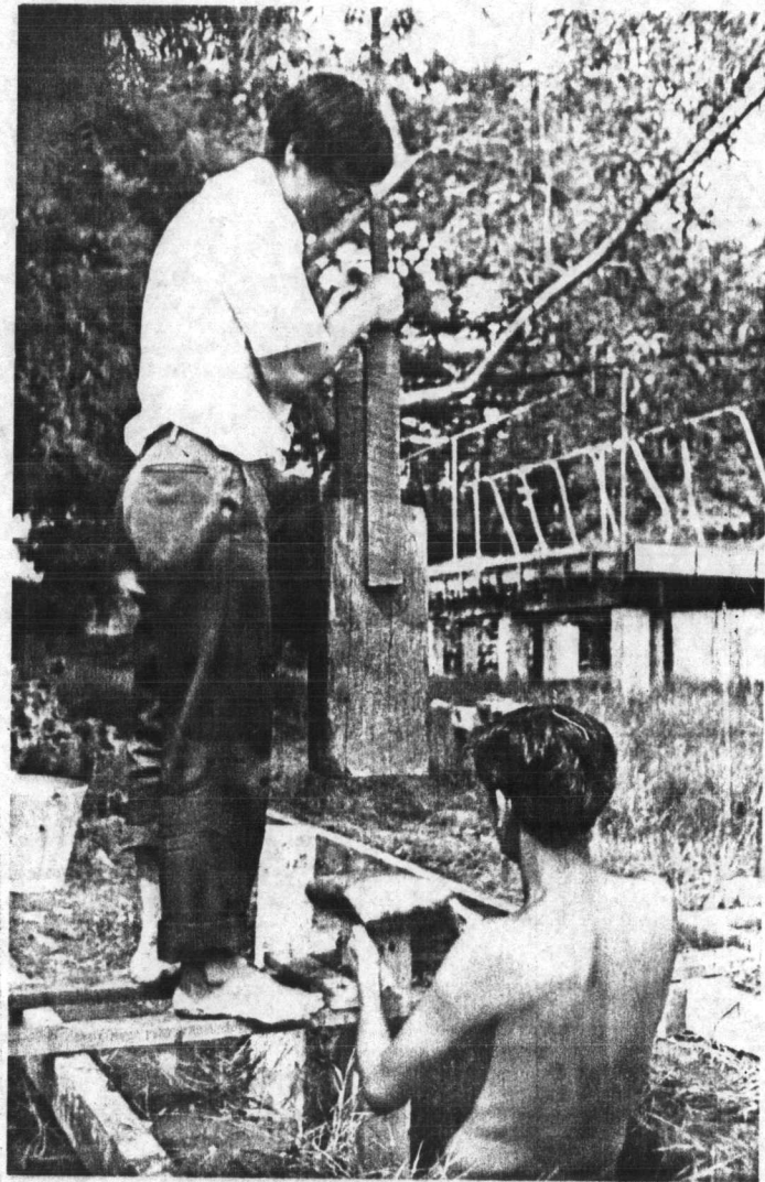
รูปที่ ๒.๗ การลงเสาเข็มโดยใช้สามเกลอและกรอบตลับลูกปืนช่วย
