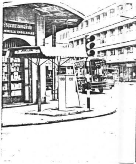
เครื่องควบคุมสัญญาณไฟจราจร ( controller )
