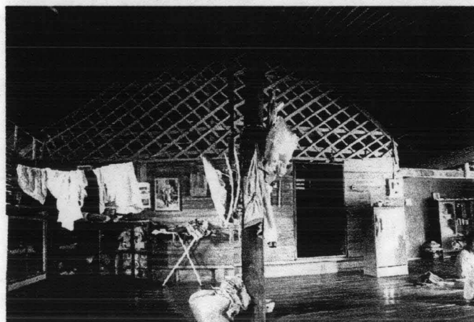
ภาพที่ 67 แสดงช่องลมหน้าจั่วเหนือฝาเข้าดกเพิง เรือนตัวอย่างที่ 4 (เรือนของนางจีคัง คังฟู)
