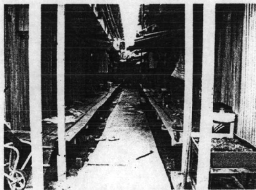
ภาพแสดง ทางเดินระหว่างเรือนแถวที่มีการเทคอนกรีตหยาบ
