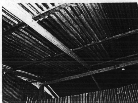
ภาพแสดง ช่องระบายอากาศชั้นบน
