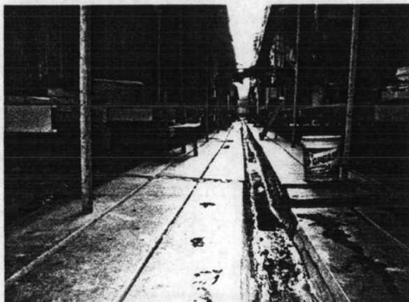
ภาพแสดง รางระบายน้ำบริเวณทางเดินระหว่างอาคาร
