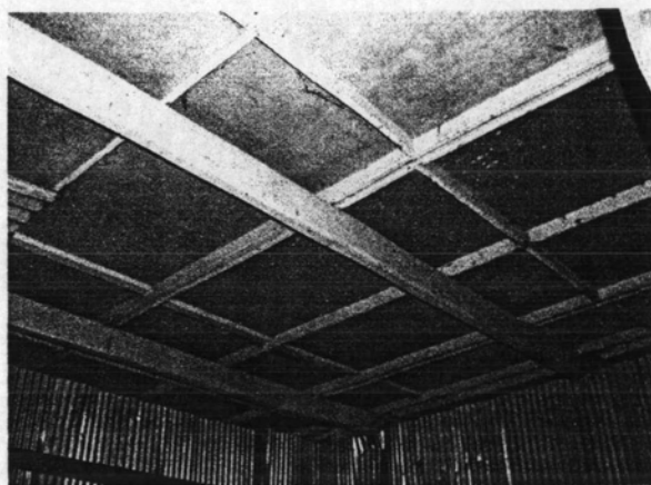
ภาพแสดง โครงเคร่าชั้นบน โดยปูแผ่นไม้อัดซีเมนต์
