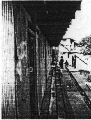
ภาพที่ 4.32 ระเบียบชั้นล่างเป็นไม้กระดาน
