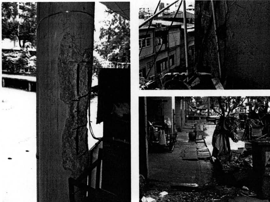
รูปที่ 1.7 สภาพความเสื่อมโทรม ของอาคารแฟลตดินแดง
