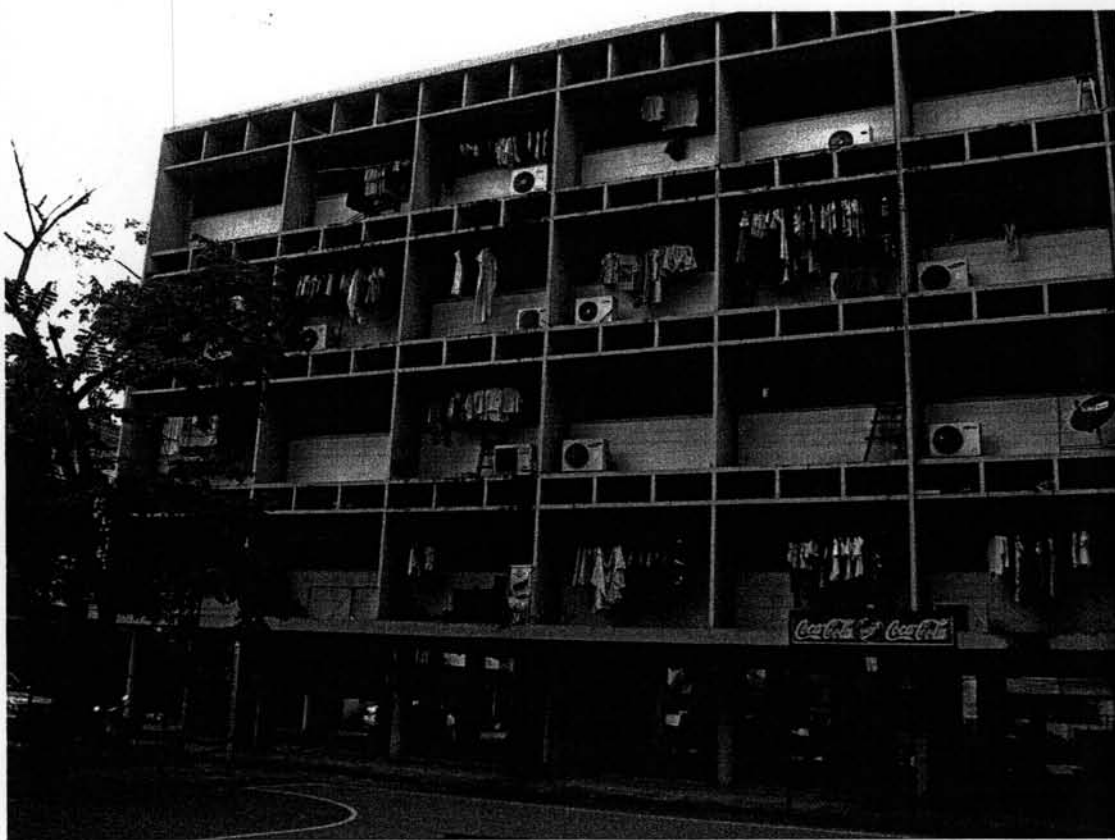
รูปที่ 1.5 อาคารสงเคราะห์แบบแฟลตสูง 5 ชั้นใต้ถุนโล่ง
