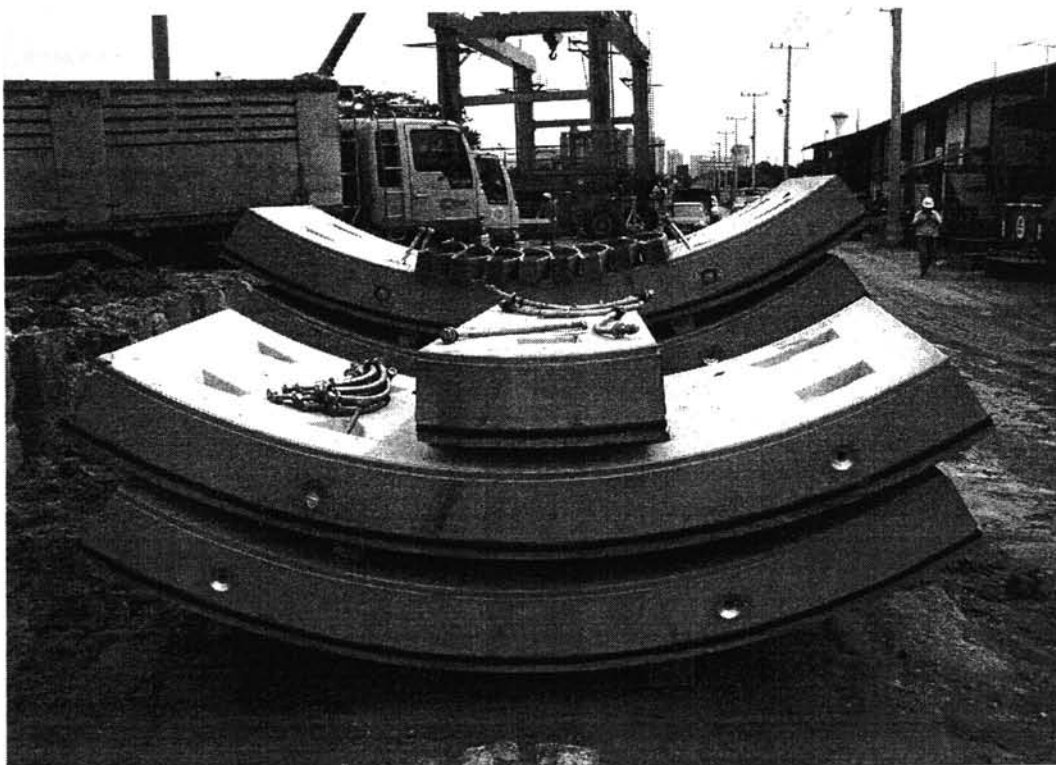
รูปที่ 2.21 แสดงชิ้นส่วนอุโมงค์ก่อนทำการประกอบ
