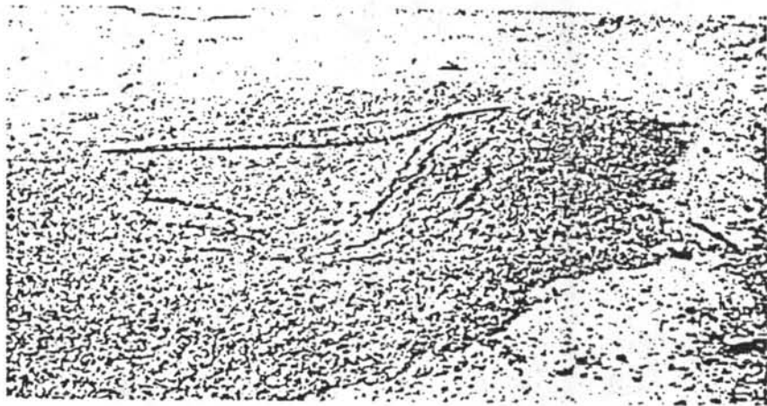
รูปที่ ช.11 ถนนยุบตัว เป็นหลุม (Shoving)
