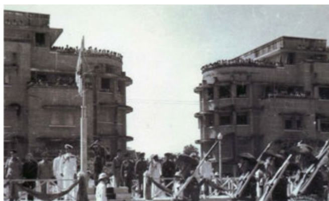
รูปที่ 4-17 ผู้ใช้อาคารต้องเปิดหน้าต่างออกจึงจะเห็นภายนอก, อาคารราชดำเนิน พ.ศ.2489 ที่มา: หอจดหมายเหตุแห่งชาติ กรมศิลปากร
