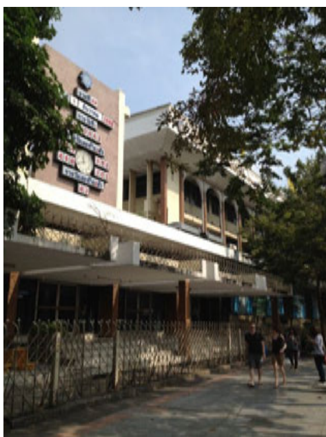
รูปที่ 3-32 อาคารสำนักงานสลากกินแบ่งรัฐบาลที่สร้างใหม่หลังจากถูกเผาทำลาย ที่มา: ผู้วิจัย, พ.ศ.2555
