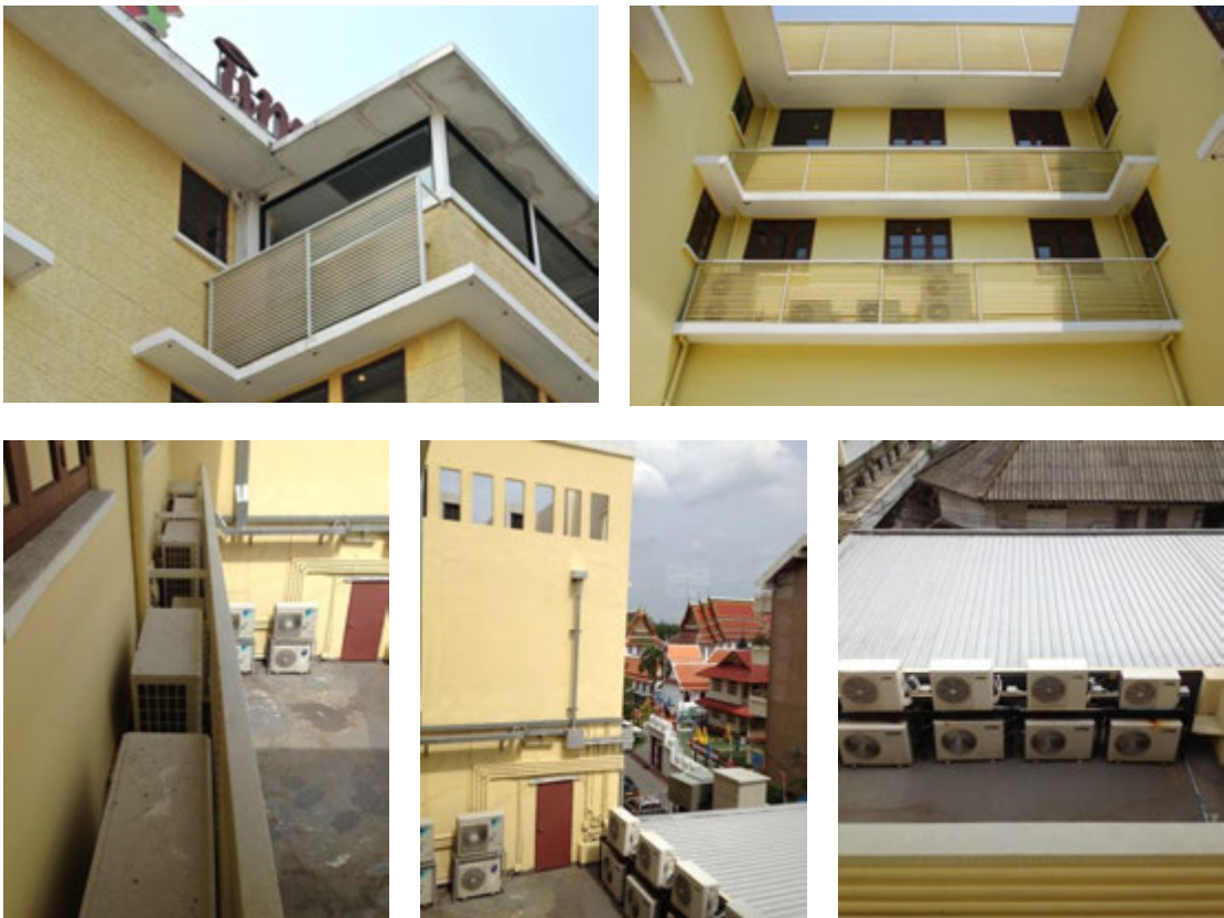
รูปที่ 4-39 ติดตั้งเครื่องระบายอากาศด้านหลังอาคาร และติดตั้งระแนงบัง
