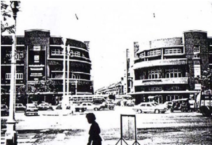
รูปที่ 3-15 อาคารราชดำเนิน ช่วงหัวมุมถนน สีแยกคอกวัว, พ.ศ.2528
