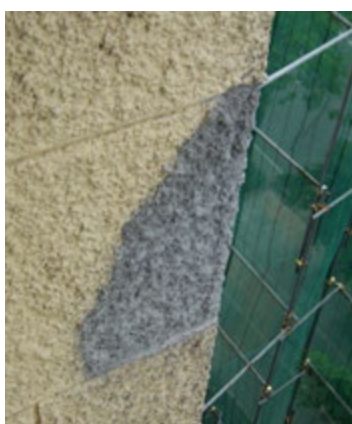
รูปที่ 4-26 การซ่อมแซมผิวผนังอาคารตามตำแหน่งที่เสื่อมสภาพ
