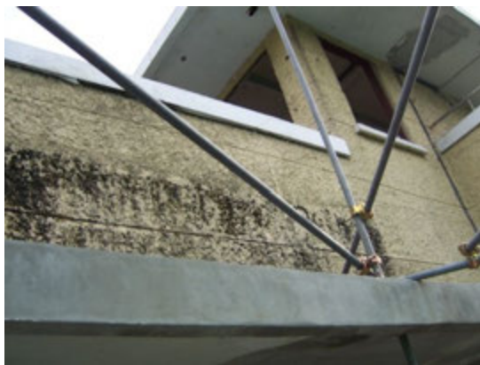
รูปที่ 4-25 ตัวอย่างการเสื่อมสภาพของผนังอาคารราชดำเนิน อาคาร 1
