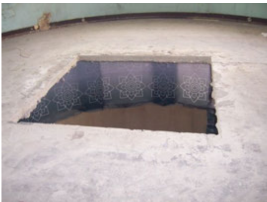
รูปที่ 4-49 ตัดพื้นและคาน ที่มา: บริษัท ไวท์แมน จำกัด
