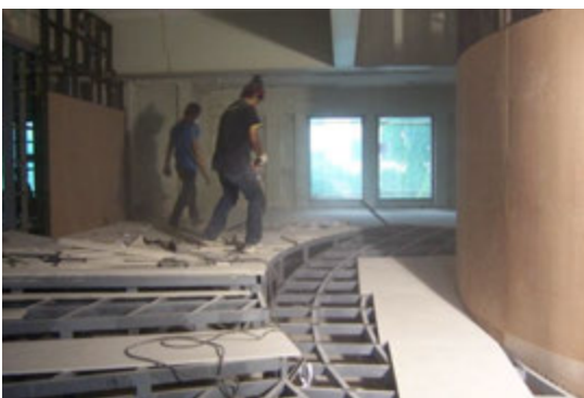
รูปที่ 4-73 ทำทางลาดที่ชั้น 2 ที่มา: บริษัท ไรท์แมน จำกัด
