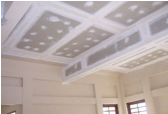
รูปที่ 4-65 ติดตั้งฝ้าเพดาน ที่มา: บริษัท ไรท์แมน จำกัด
