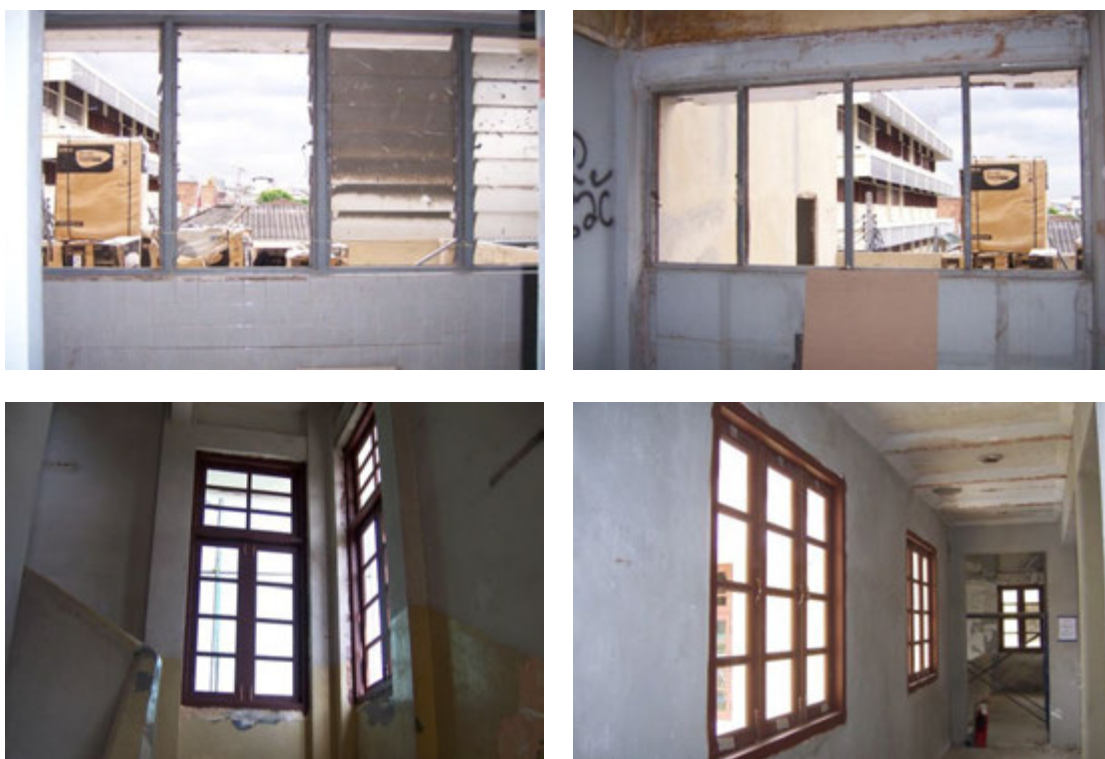
รูปที่ 4-29 เปลี่ยนหน้าต่างให้เหมือนรูปแบบสถาปัตยกรรมเดิม
