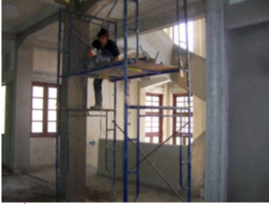
รูปที่ 4-54 ซ่อมแซมผนัง ที่มา: บริษัท ไรท์แมน จำกัด
