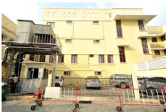
รูปที่ 4-35 อาคารต่อเติมด้านหลัง
