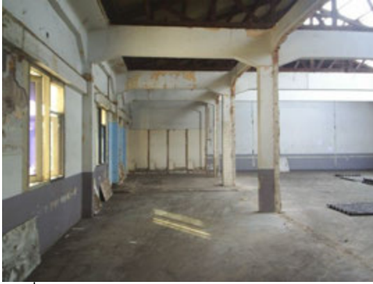
รูปที่ 4-7 ภายในอาคารราชดำเนิน อาคาร 1: โครงสร้างคอนกรีตเสริมเหล็กแบบโครงข้อแข็ง (rigid frame) ผสมกับแบบเสาและคานธรรมดาบางส่วน ที่มา: บริษัท ไรท์แมน จำกัด
