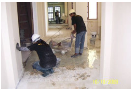
รูปที่ 4-55 ซ่อมแซมและตกแต่งพื้นใหม่ ที่มา: บริษัท ไรท์แมน จำกัด
