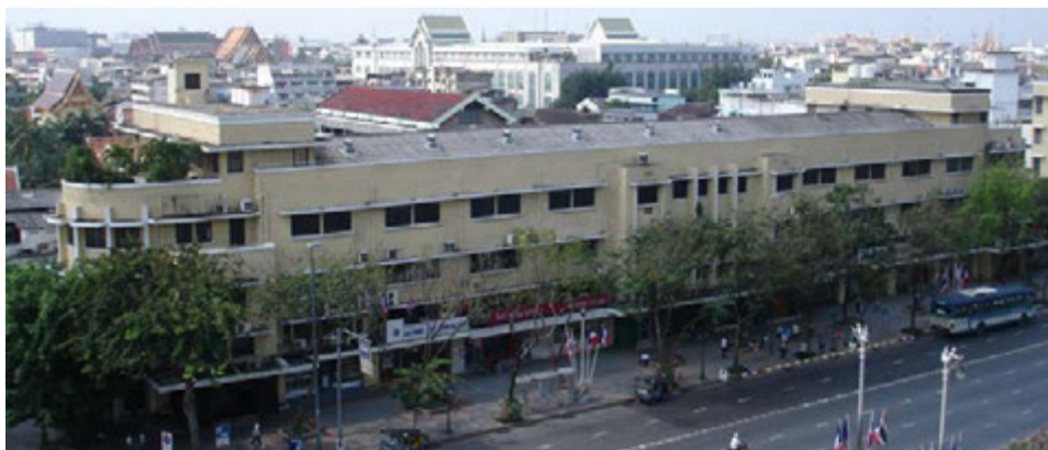
รูปที่ 4-18 อาคารราชดำเนิน อาคาร 1 ก่อนปรับปรุงอาคาร
