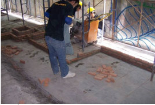
รูปที่ 4-71 ทำทางลาดทางเข้าอาคาร ที่มา: บริษัท ไรท์แมน จำกัด
