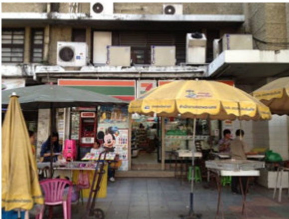
รูปที่ 3-39 การติดตั้งเครื่องปรับอากาศที่ไม่ เรียบร้อย ส่งผลต่อความสวยงามของกลุ่ม อาคารและถนนราชดำเนินกลาง ที่มา: ผู้วิจัย, พ.ศ.2555
