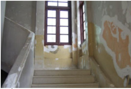
รูปที่ 4-13 โถงบันไดอาคารราชดำเนิน อาคาร 1 ที่มา: บริษัท ไรท์แมน จำกัด
