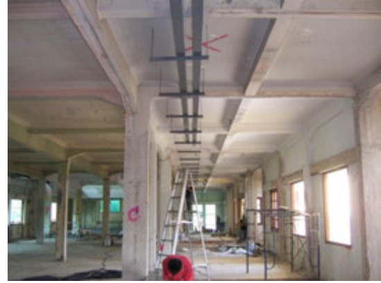
รูปที่ 4-7 ภายในอาคารราชดำเนิน อาคาร 1: โครงสร้างคอนกรีตเสริมเหล็กแบบโครงข้อแข็ง (rigid frame) ผสมกับแบบเสาและคานธรรมดาบางส่วน ที่มา: บริษัท ไรท์แมน จำกัด
