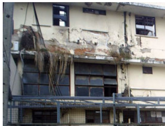
รูปที่ 4-25 ตัวอย่างการเสื่อมสภาพของผนังอาคารราชดำเนิน อาคาร 1
