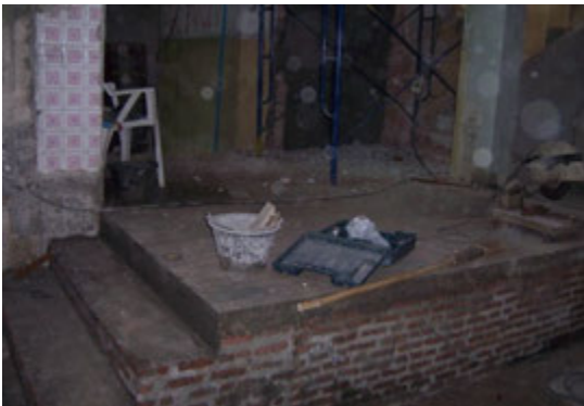
รูปที่ 4-72 ทำทางลาดที่ชั้น 1 ที่มา: บริษัท ไรท์แมน จำกัด
