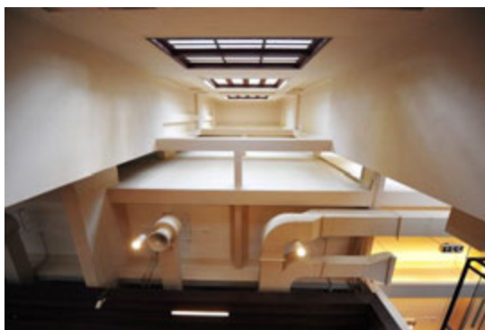
รูปที่ 4-56 ผนังและพื้นหลังปรับปรุงอาคาร ที่มา: ผู้วิจัย, พ.ศ.2555
