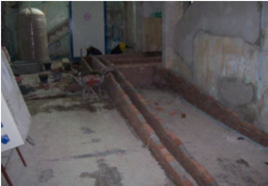
รูปที่ 4-71 ทำทางลาดทางเข้าอาคาร ที่มา: บริษัท ไรท์แมน จำกัด
