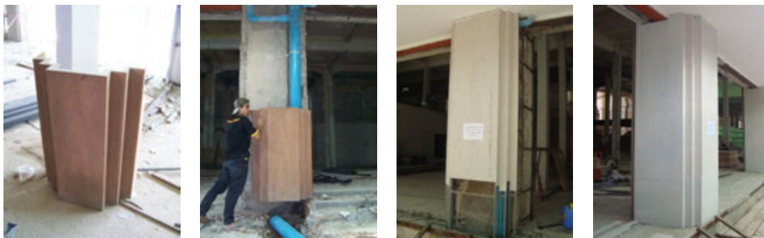
รูปที่ 4-36 กล่องครอบท่อระบายน้ำฝนจากหลังคาที่แนวเสาด้านหน้าอาคาร ที่มา: บริษัท ไรท์แมน จำกัด
