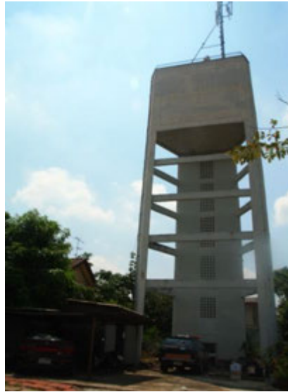
ภาพที่ 6.2 แสดงระบบประปาถังสูงที่ไม่ใช้งานแล้วมีการใช้ประโยชน์เป็นเสาส่งสัญญาณโทรศัพท์เคลื่อนที่
