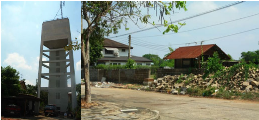
ภาพที่ 5.41 แสดงป้อมบาดาลถึงสูงและป้อมบำบัดน้ำเสียในโครงการสัมมาร มินบุรี 1
