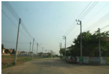
ภาพที่ 5.100 แสดงพื้นที่ก่อสร้างในโครงการสัมมากร รังสิต คลอง 7
