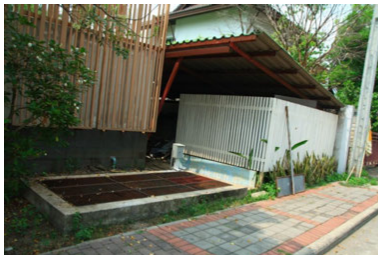
ภาพที่ 5.144 แสดงบ่อบำบัดน้ำเสียของโครงการสัมมากร นครอินทร์
