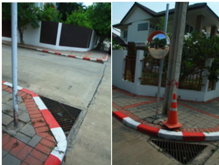
ภาพที่ 5.152 แสดงการปิดมุมถนนบริเวณโครงการสัมมากร นครอินทร์
