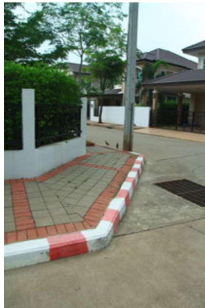
ภาพที่ 5.180 แสดงการปาดมุมถนนในผังโครงการสัมมากร ราชพฤกษ์
