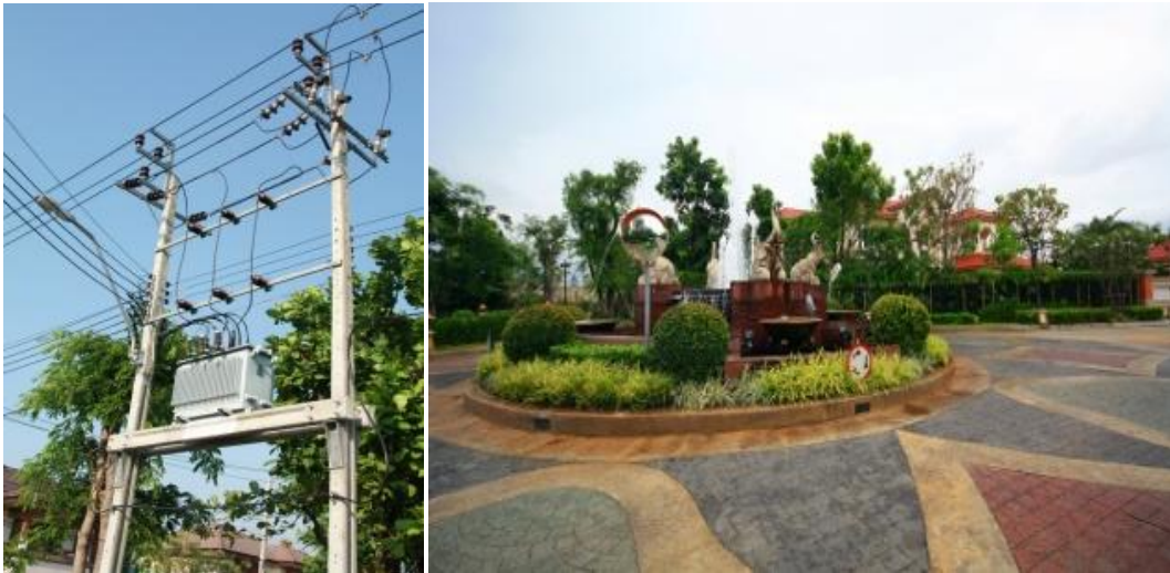
ภาพที่ 2.4 แสดงตัวอย่างสาธารณูปโภคภายในโครงการ (ระบบไฟฟ้า-ถนน)
