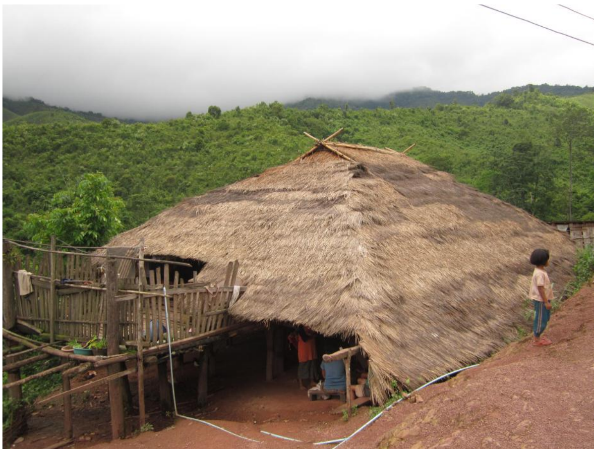
ภาพที่ 5-3 ภาพเรือนลัวะดั้งเดิมที่มีการสร้างให้เข้ากับสภาพภูมิประเทศที่เป็นเชิงเขา ด้วยการปรับหน้าดินให้มีความเรียบเพียงพอกับการสร้างเรือนของตน
