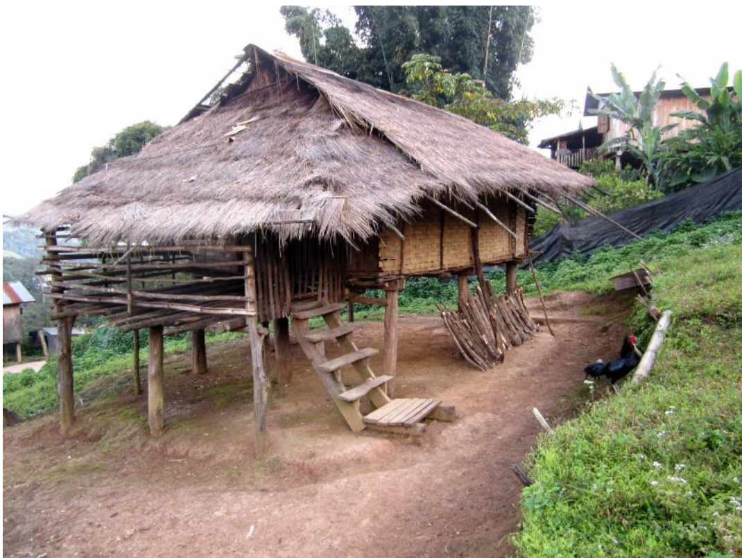
ภาพที่ 4-2 เรือนพักอาศัยดั้งเดิมนั้นมีแนวคิดในการปลูกเรือนให้หลังคาด้านหนึ่งจรดกับผนังดินที่ติดกับภูเขา เพื่อให้ความอบอุ่นจากดินได้ในฤดูหนาวและความเย็นจากดินได้ในฤดูร้อน พื้นที่รอบเรือนส่วนที่ไม่ใช้งานบางเรือนจะปลูกพืชผักสวนครัว
