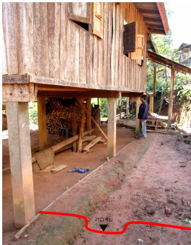
ภาพที่ 4-5 หมู่บ้านก่อถ่าง ร่องน้ำรอบตัวเรือนช่วยในการระบายน้ำ
