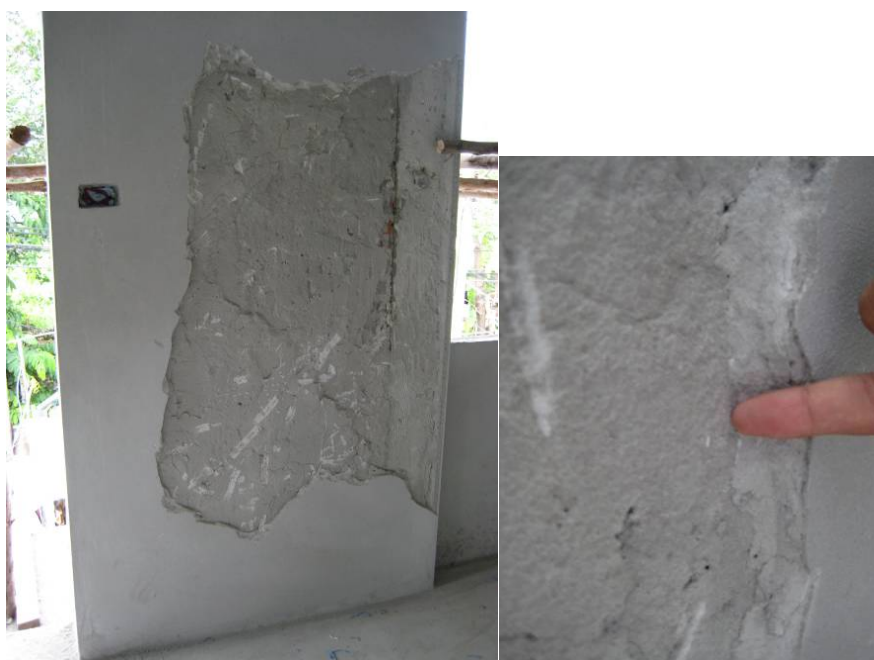
ภาพที่ 5.16 การสกัดเพื่อทำการแก้ไขปัญหาผนังกะเทาะเนื่องจากการการฉาบหนา
