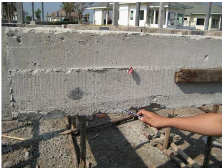
ภาพที่ 5.46 ข้อบกพร่องขาดการจี้คอนกรีตสดทำให้คอนกรีตไม่ลงไปตามมุมแบบหล่อ
