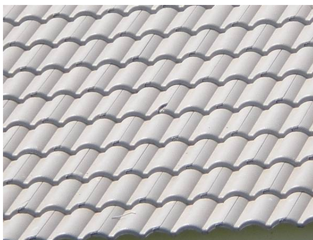
ภาพที่ 5.70 ข้อบกพร่องการนำกระเบื้องที่ชำรุดมาใช้โดยไม่แก้ไข
