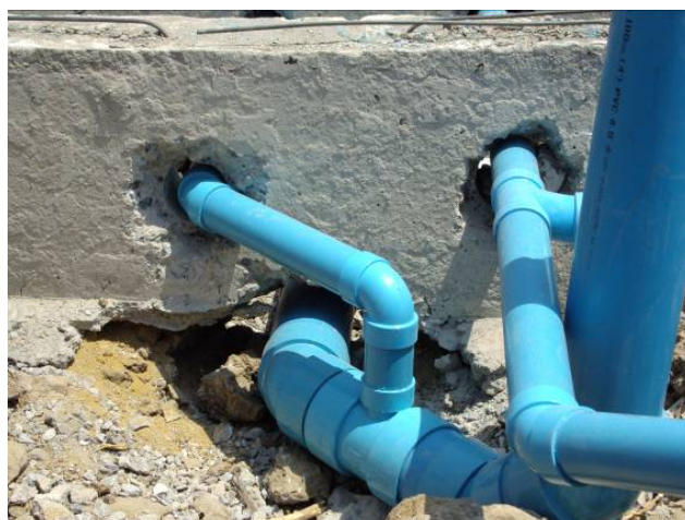
ภาพที่ 5.50 ข้อบกพร่องการเจาะคานทำให้สูญเสียหน้าตัด
