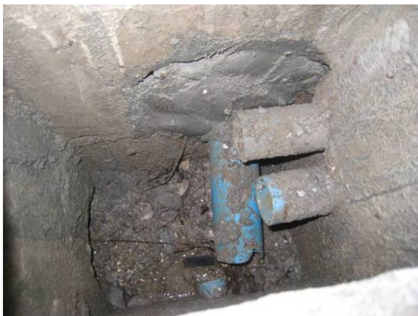
ภาพที่ 5.76 ข้อบกพร่องขาดการป้องกันเศษสิ่งปฏิกูล
