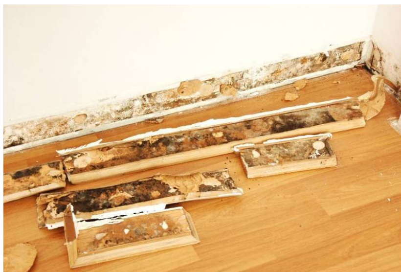
ภาพที่ 5.88 ข้อบกพร่องบัวพื้นขึ้นราจากการเตรียมพื้นผิวไม่แห้งสนิท
