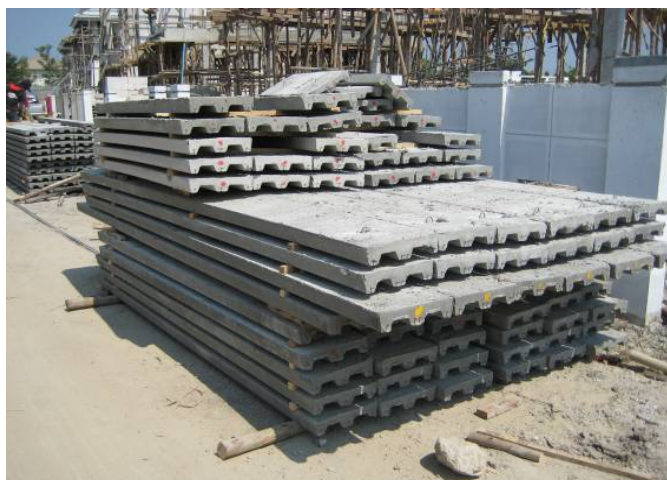
ภาพที่ 5.62 แสดงถึงข้อบกพร่องการกองเก็บที่ผิดวิธี
