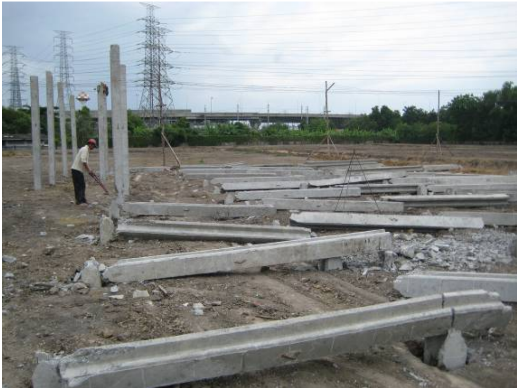
ภาพที่ 5.41 การไม่ใช้ใบตัดไฟเบอร์ในขั้นตอนการตัดหัวเข็ม
