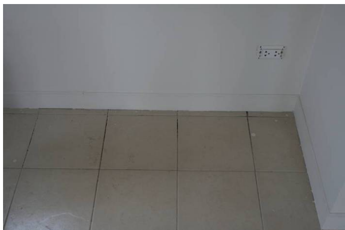
ภาพที่ 5.93 การแบ่งเศษกระเบื้องที่ไม่เหมาะสม
