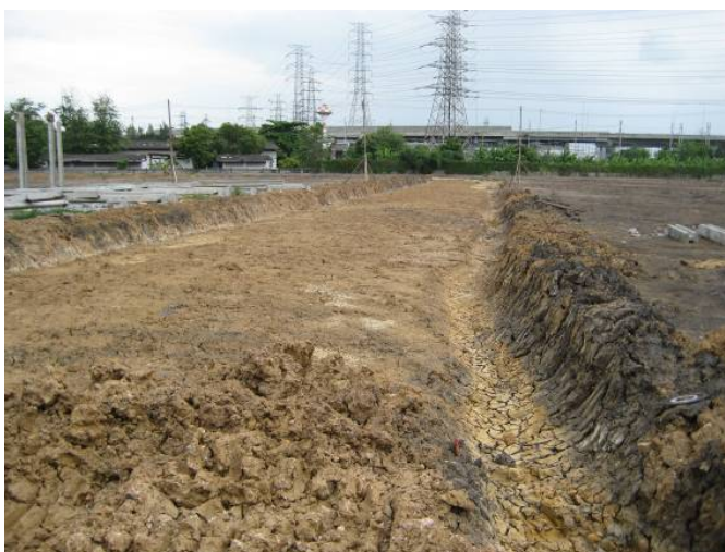
ภาพที่ 5.12 ขาดการบดอัดทรายทรายรองพื้น และขาดการเทคอนกรีตหยาบในงานท่อระบายน้ำ
