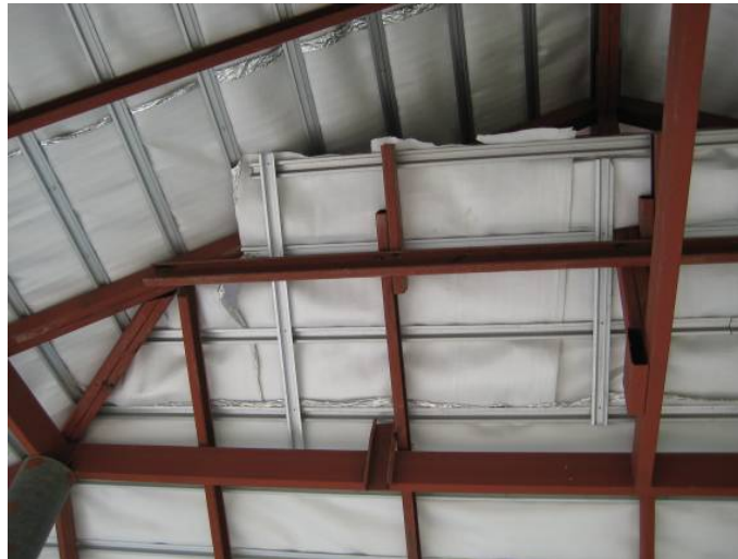
ภาพที่ 5.66 ข้อบกพร่องการใช้เศษเหล็กมาประกอบ
