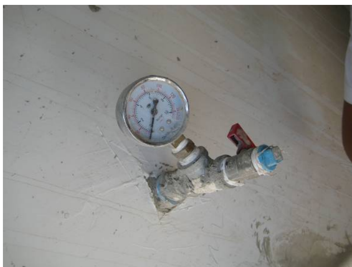
ภาพที่ 5.74 การทดสอบแรงดันเพื่อป้องกันท่อประปารั่วซึม
