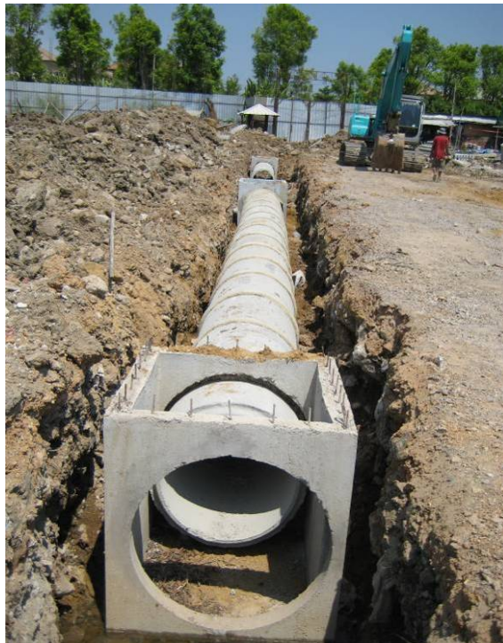
ภาพที่ 5.13 ขาดการทดสอบกรีตหยาบตามแนวท่อระบายน้ำและบ่อบัก
