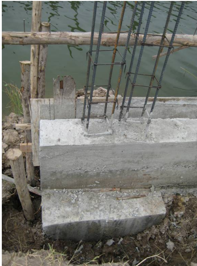
ภาพที่ 5.37 ข้อบกพร่องเสาผิดตำแหน่ง
