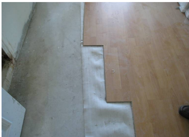
ภาพที่ 5.90 การปูแผ่นโฟมรองพื้นลามิเนตไม่เหมาะสม
