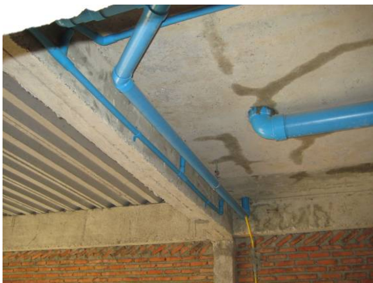
ภาพที่ 5.78 ข้อบกพร่องพื้นห้องน้ำรั่วซึม
