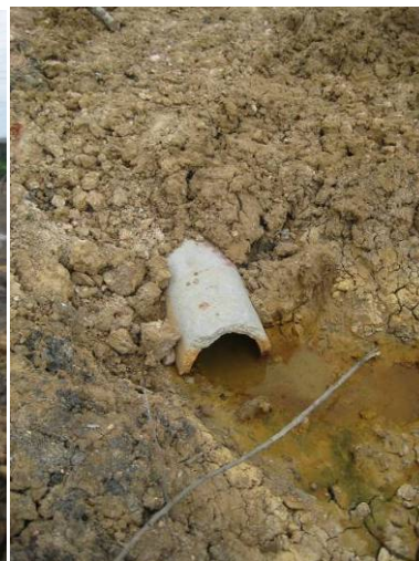
ภาพที่ 5.12 ขาดการบดอัดทรายทรายรองพื้น และขาดการเทคอนกรีตหยาบในงานท่อระบายน้ำ
