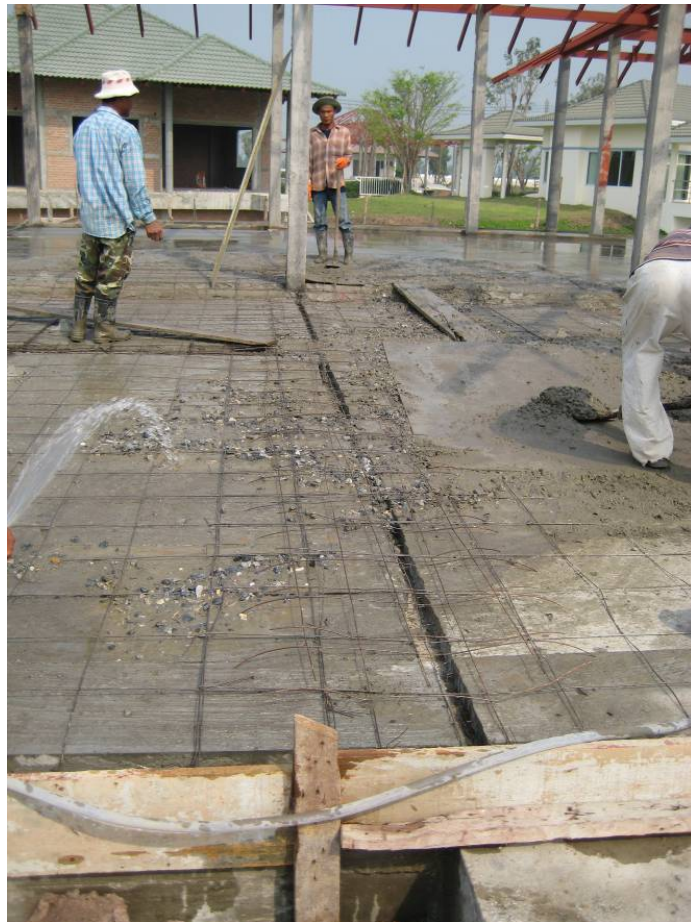
ภาพที่ 5.61 แสดงถึงข้อบกพร่องขนาดการลำเลียงคอนกรีตที่เหมาะสม
