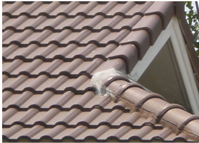
ภาพที่ 5.71 ข้อบกพร่องของรอยต่อบริเวณตะเข้สัน
