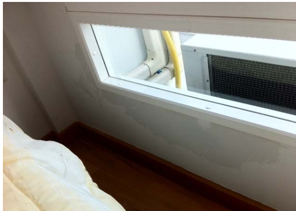
ภาพที่ 5.31 ข้อบกพร่องน้ำซึมบริเวณขอบวงกบหน้าต่าง
