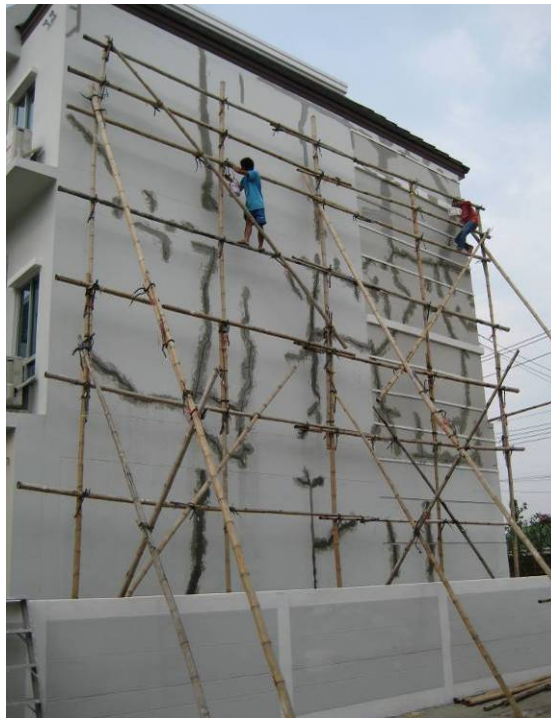
ภาพที่ 5.21 รอยแตกร้าวเนื่องจากแสงแดดและอุณหภูมิ
