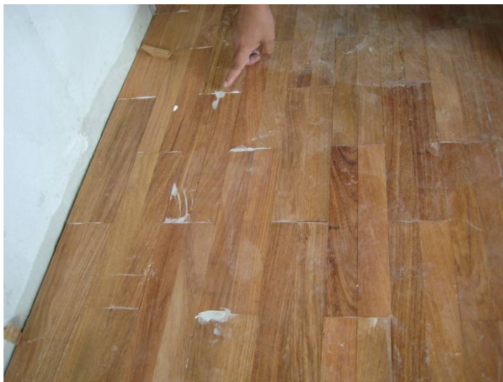
ภาพที่ 5.89 ข้อบกพร่องการใช้กาวในปริมาณที่ไม่เหมาะสม งานพื้นผิวลามิเนต
