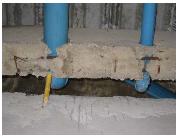
ภาพที่ 5.51 ข้อบกพร่องคอนกรีตเป็นโพรงในตำแหน่งที่ฝังท่อ Sleeve
