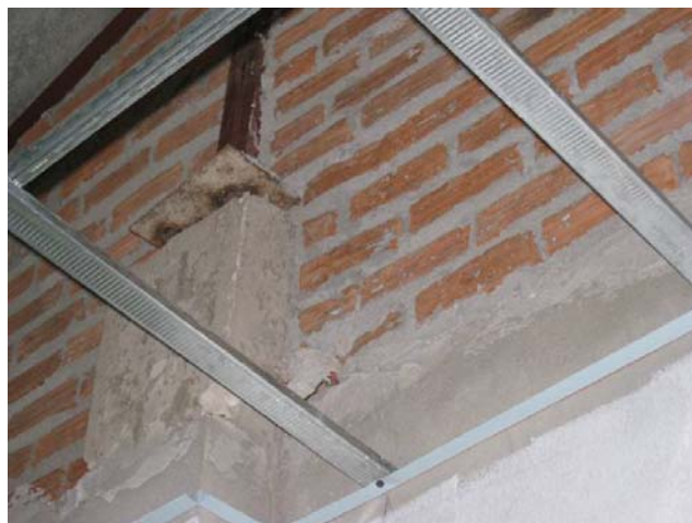
ภาพที่ 5.67 ข้อบกพร่องขาดการกรอกปูนเกรวท์ชนิดไม่หดตัวบริเวณหัวเสา
