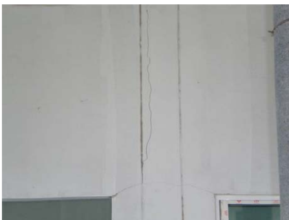
ภาพที่ 5.24 รอยร้าวทแยงบริเวณมุมวงกบหน้าต่าง
