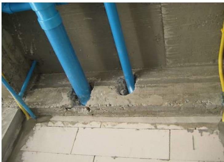
ภาพที่ 5.52 ข้อบกพร่องการเจาะคานทำให้สูญเสียหน้าตัด
