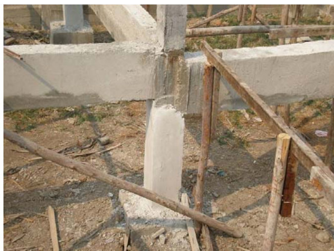
ภาพที่ 5.49 การพอกเสาเพื่อแก้ไขปัญหาคานผิดตำแหน่ง
