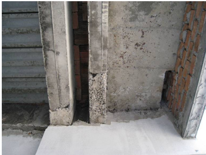
ภาพที่ 5.59 ข้อบกพร่องการใช้อิฐมาเรียงแบบหล่อในส่วนที่ไม่มีแผ่นพื้นสำเร็จ
