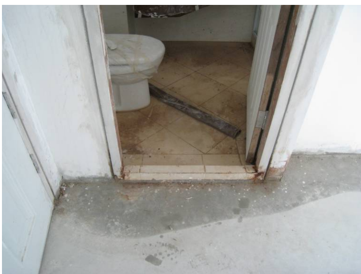
ภาพที่ 5.79 ข้อบกพร่องเนื่องจากการทำระดับพื้นห้องน้ำ
