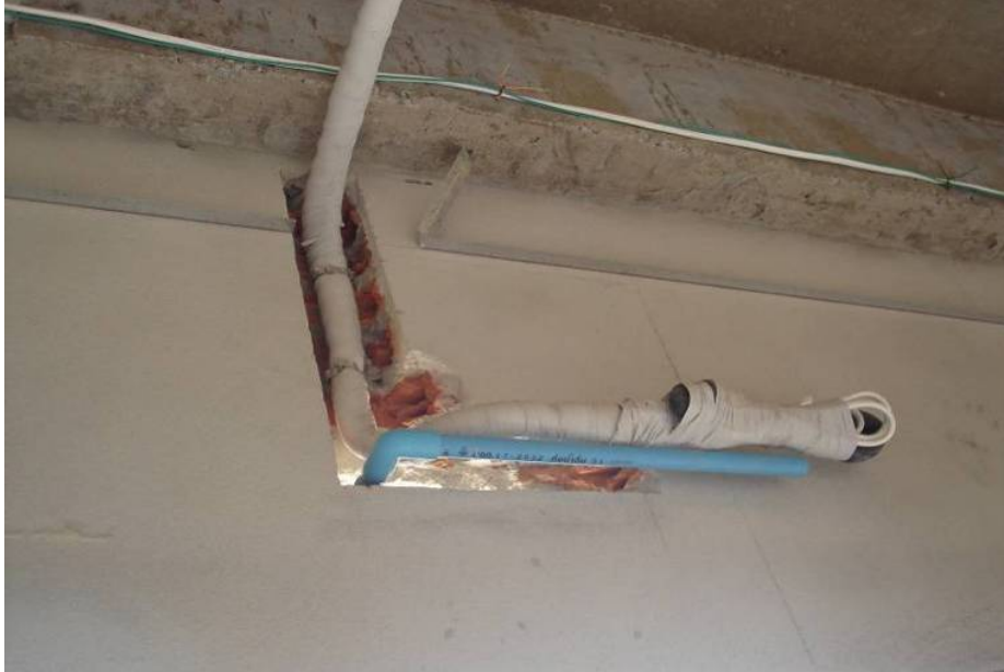
ภาพที่ 5.83 ข้อบกพร่องเนื่องจากงานระบบที่คลาดเคลื่อน
