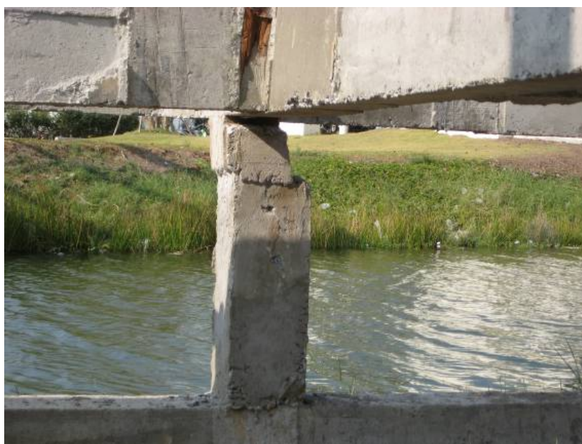
ภาพที่ 5.36 ข้อบกพร่องเสาตอม่อผิดตำแหน่งทำให้ไม่ตรงกับตำแหน่งคาน
