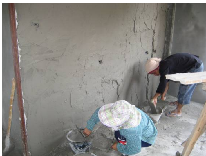
ภาพที่ 5.15 การฉาบผนังหนามากกว่าข้อกำหนดเนื่องจากการปรับแก้แนวการก่อกำแพง
