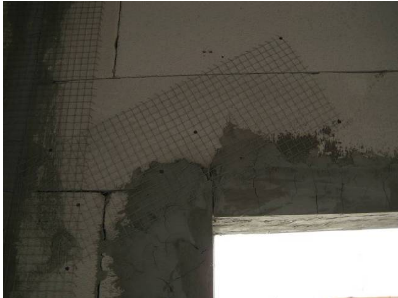
ภาพที่ 5.25 การใส่ตะแกรงกันแตกบริเวณมุมวงกบหน้าต่าง
