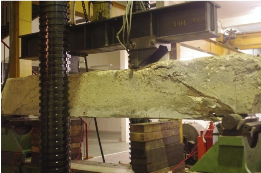
รูปที่ 5-58 การวิบัติของคาน B120F
