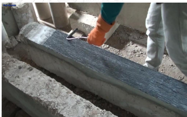
รูปที่ 4-11 การติดตั้งแผ่น FRP
