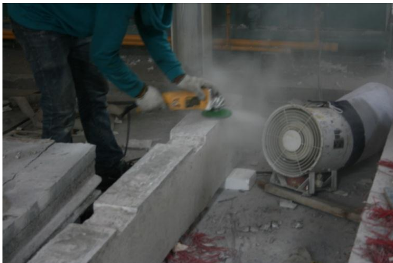
รูปที่ 4-10 การเตรียมผิวคอนกรีตก่อนซ่อมแซมด้วย FRP
