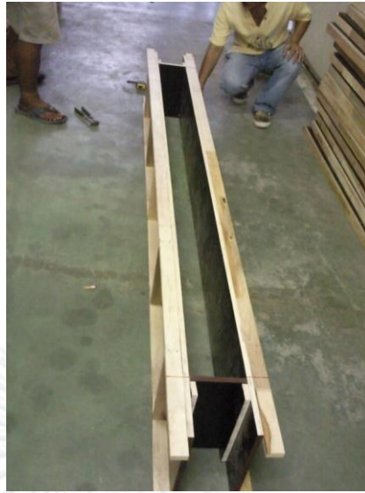
รูปที่ 4-1 การเตรียมแบบหล่อชิ้นงาน
