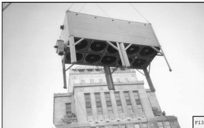
รูปที่ 2.8 หอหล่อเย็นแบบบังคับทางลม (Forced draft)
