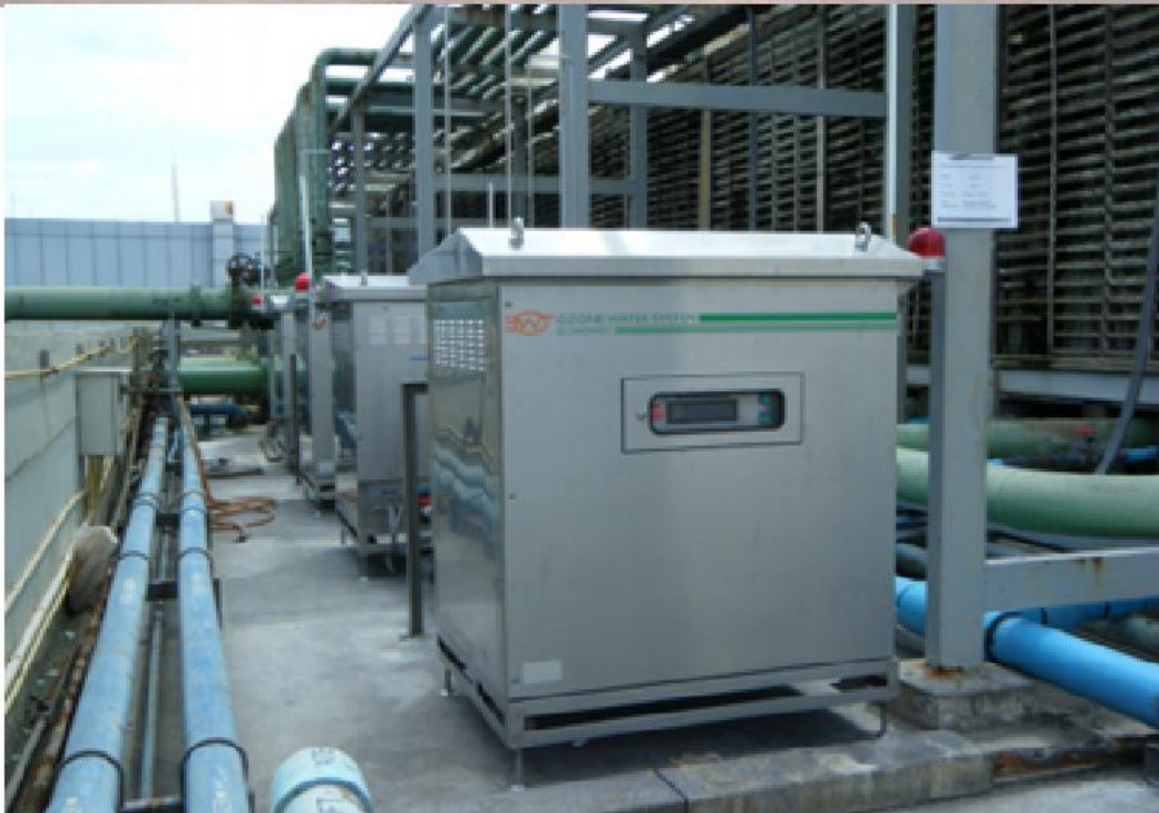
รูปที่ 2.29 การใช้โอโซนกับหอหล่อเย็นในสถานที่จริง ที่มา: www.econowatt.co.th
