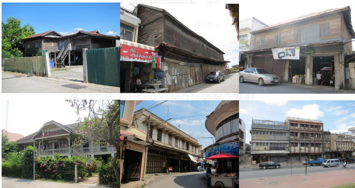
ภาพที่ 6.21 รูปแบบอาคารที่พบส่วนใหญ่ในย่านการค้า
