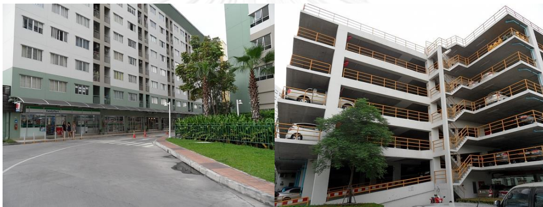
ภาพ 4. 13 แสดงรูปอาคารภายนอกและอาคารจอดรถของโครงการ ลุมพินีวิลล์ รามอินทรา-หลักสี่
