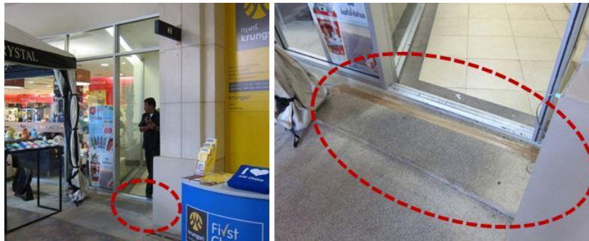
ภาพที่ 5.22 แสดงทางเข้าห้องน้ำ WC1-1 ภายในโครงการ The Crystal
