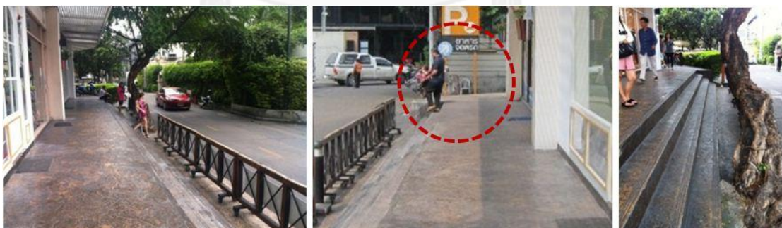
ภาพที่ 5.5 แสดงบันไดทางเชื่อมบริเวณทางเข้า C ภายในโครงการ J Avenue
