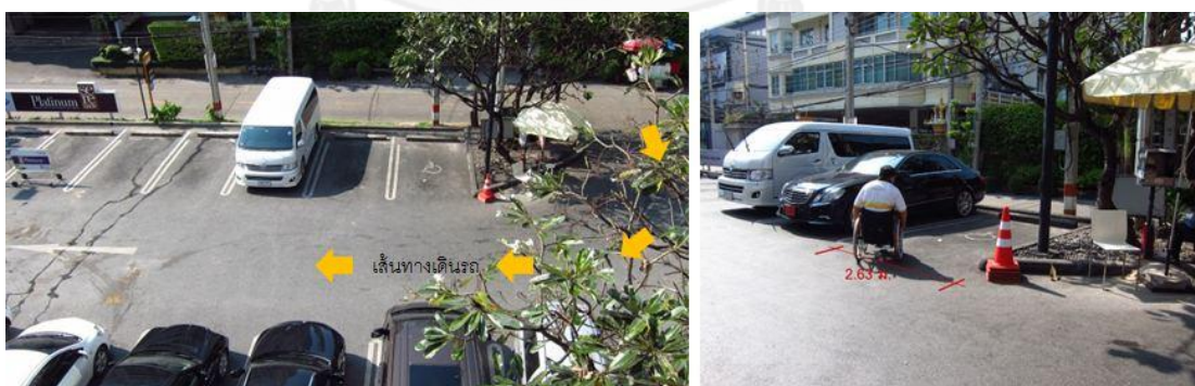
ภาพที่ 5.2 แสดงที่จอดรถคนพิการและทางลาดภายนอกโครงการ J Avenue
