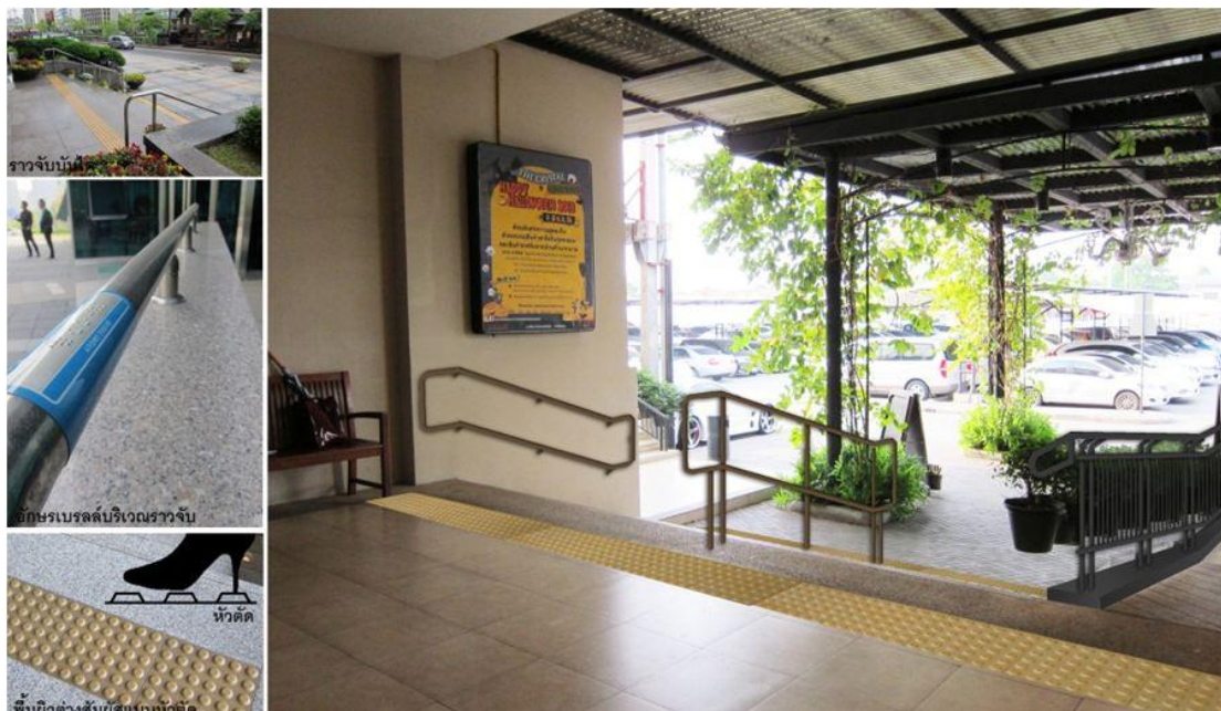
ภาพที่ 5.39 แสดงแนวทางการปรับปรุงบันไดบริเวณทางเข้า C โครงการ The Crystal
