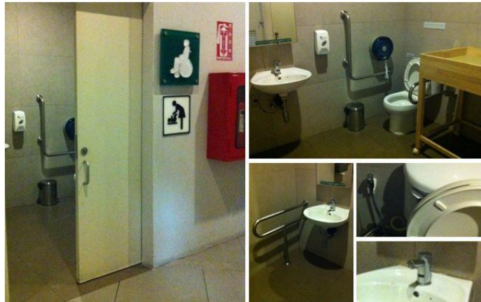
ภาพที่ 2.9 แสดงห้องน้ำคนพิการและจุดเปลี่ยนผ้าอ้อมภายในโครงการ K Village
