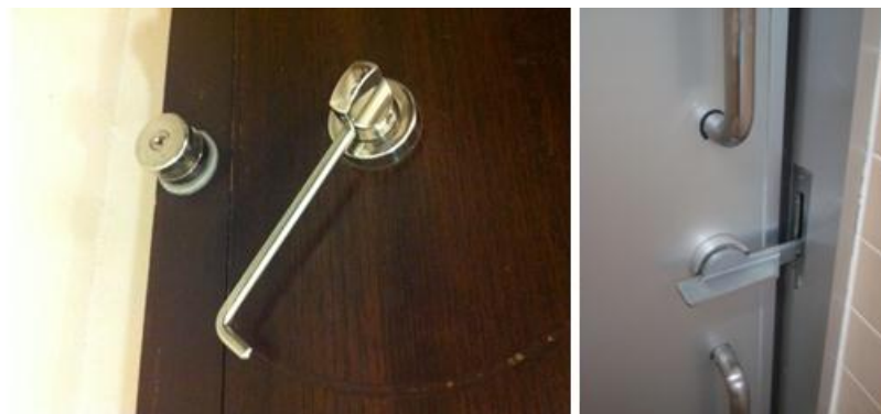
ภาพที่ 6.22 แสดงตัวล็อคแบบตะขอสับ 19
