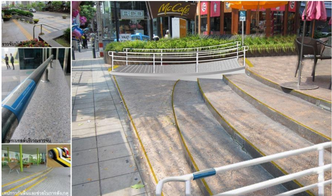
ภาพที่ 5.34 แสดงแนวทางการปรับปรุงทางเข้า A โครงการ J Avenue
