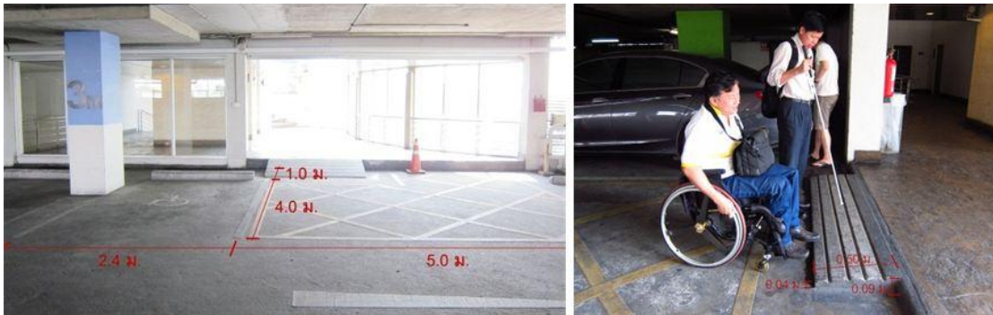
ภาพที่ 5.3 แสดงที่จอดรถคนพิการและทางลาดภายในอาคารจอดรถโครงการ J Avenue
