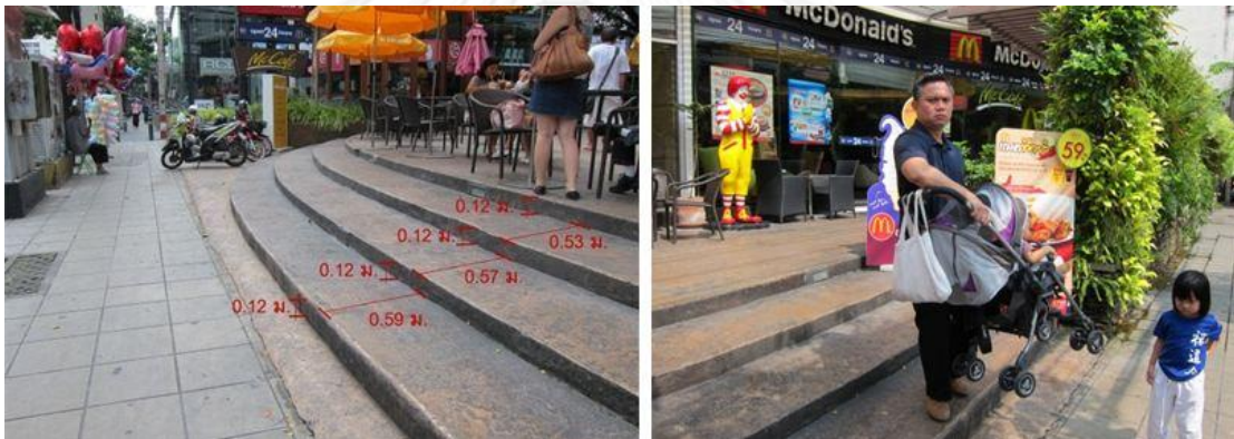
ภาพที่ 5.4 แสดงบันไดทางเชื่อมบริเวณทางเข้า A ภายในโครงการ J Avenue
