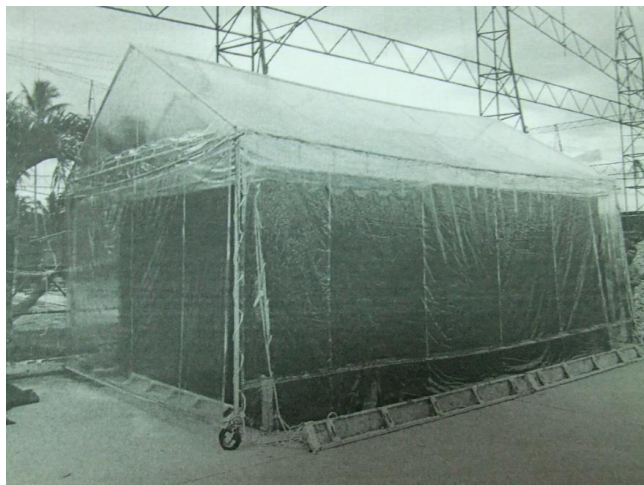
ภาพที่ 6- 6 Solar Greenhouse drying ทำด้วยแผ่นผ้าโปร่งแสง
