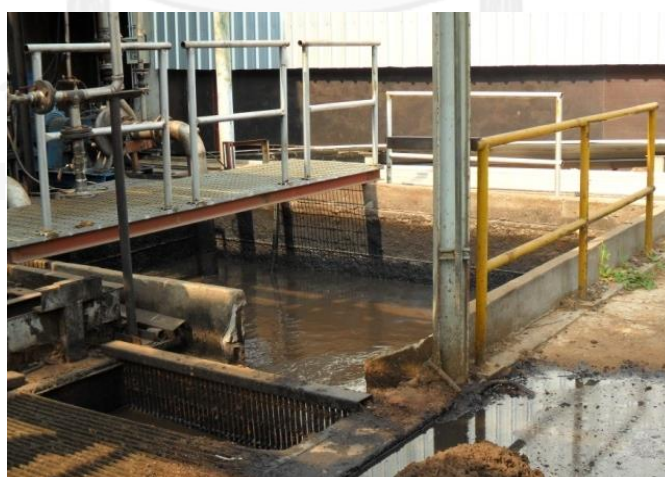
ภาพที่ 2- 5 บ่อรวมน้ำเสียโรงงานไม้อัดแผ่นเรียบ
