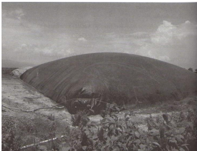
ภาพที่ 2- 13 ระบบบ่อแอนแอโรบิกแบบปิด (Covered Anaerobic Lagoon)
