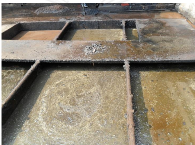
ภาพที่ 2- 4 บ่อดักไขมันโรงงานไม้อัดแผ่นเรียบ
