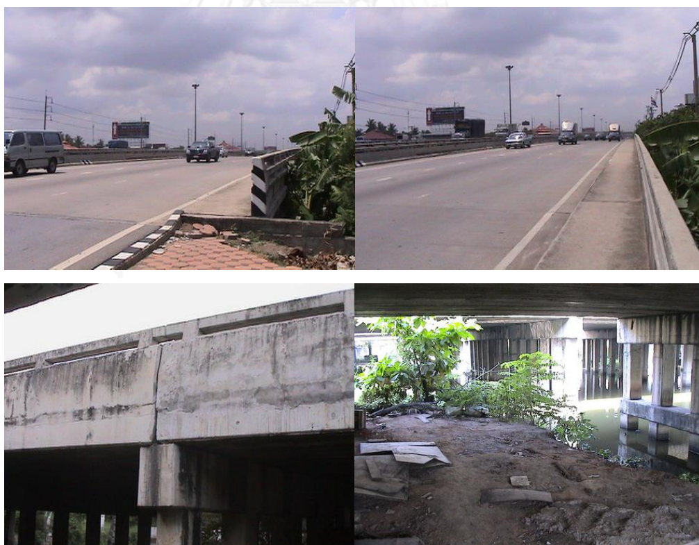
รูปที่ 4.4 สะพานที่ทำการเก็บค่าน้ำหนักรถบรรทุก บริเวณวงแหวนตะวันตก กม.28+170.31 ข้ามคลองบางน้อย เขตบางแค กรุงเทพมหานคร
