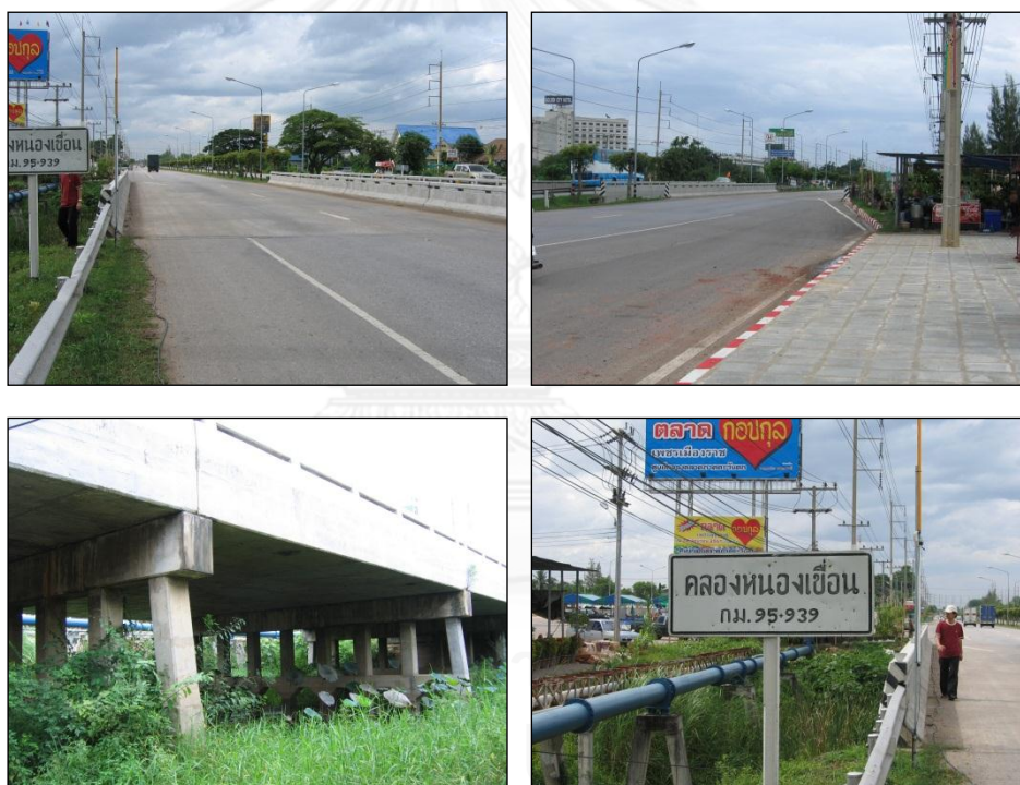
รูปที่ 4.1 สะพานทดสอบที่ตรวจวัดน้ำหนักรถบรรทุก
