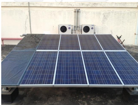
ภาพที่ 7.2 เซลล์แสงอาทิตย์จากบริษัท โซลาร์ตรอน จำกัด (มหาชน) รุ่น SP120
