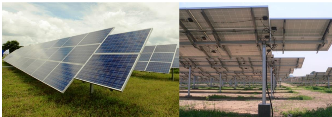
ภาพที่ 3.2 การติดตั้งอาร์เรย์เซลล์แสงอาทิตย์แบบติดตาม
