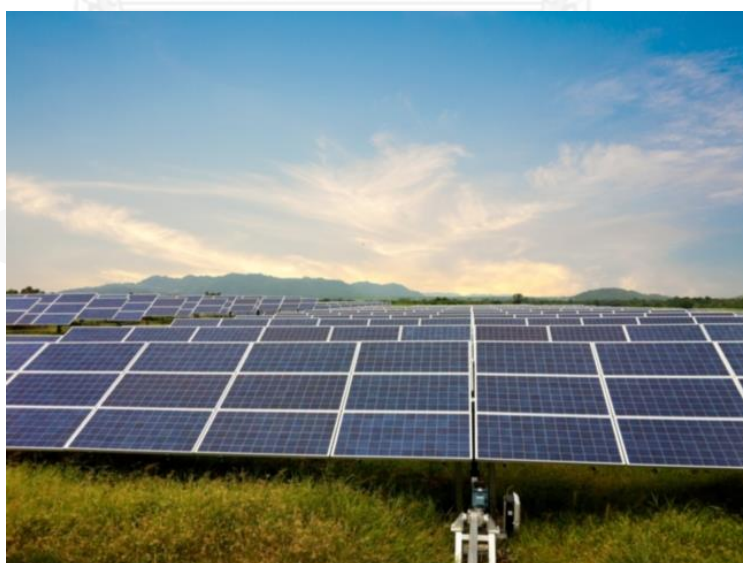
ภาพที่ 7.11 โรงไฟฟ้าของระบบทดสอบระบบผลิตไฟฟ้าเซลล์แสงอาทิตย์ ระบบที่ 3
