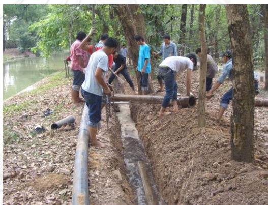
ภาพที่ 3. 46 งานซ่อมระบบประปาและสุขาภิบาล
