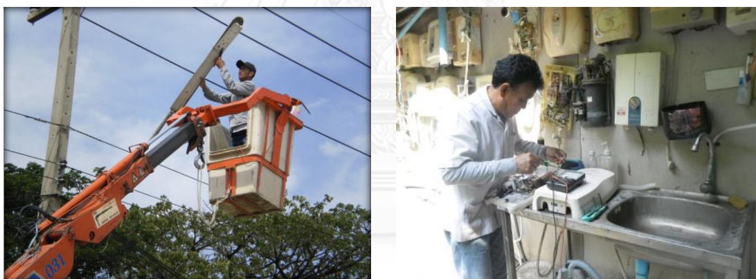
ภาพที่ 3. 44 งานซ่อมระบบไฟฟ้า
