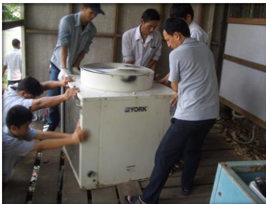
ภาพที่ 3. 48 งานซ่อมระบบปรับอากาศ
