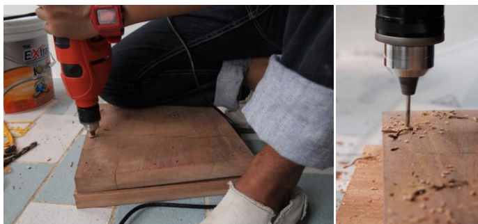
ภาพที่ 5.10 เจาะรูที่เครื่องหมายที่ทำไว้ โดยให้ระวังการเจาะไม่ได้ฉาก
