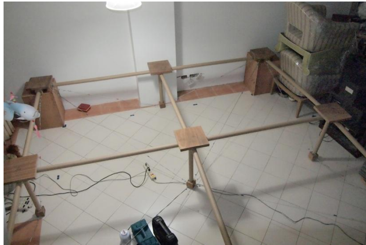
ภาพที่ 5.44 สภาพเมื่อขึงตั้งโครงสร้างทั้งหมดแล้ว
