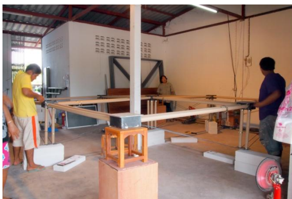
ภาพที่ 5.67 ตรวจสอบระดับของโครงสร้างท่อกระดาศ
