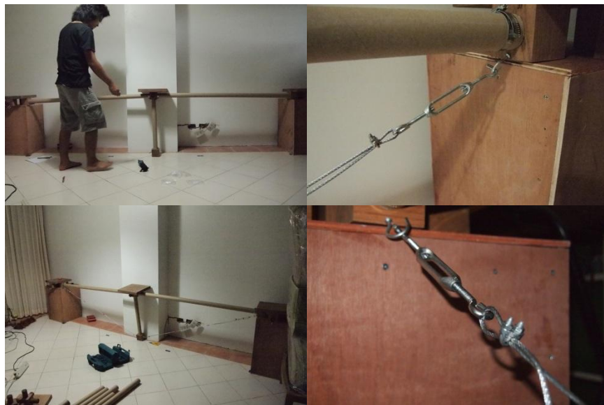
ภาพที่ 5.43 การขึงตึงใช้เกลียวแรงขันสลิงให้ตึง
