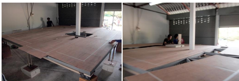
ภาพที่ 5.69 การวางไม้อัดบนโครงสร้าง
