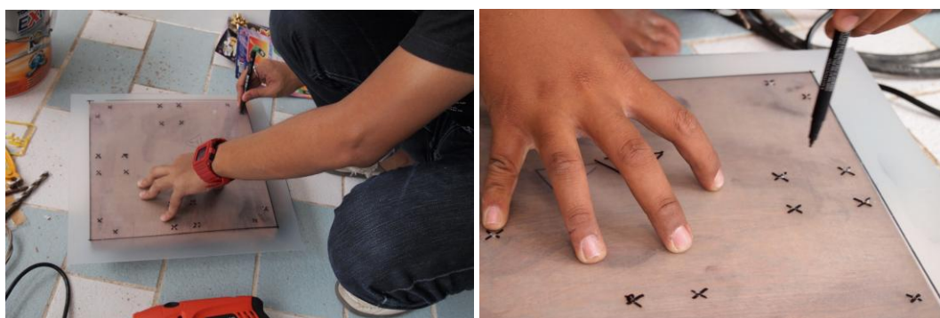
ภาพที่ 5.9 นำแผ่นพลาสติกแม่แบบวางทาบและทำเครื่องหมายลงบนแผ่นไม้
