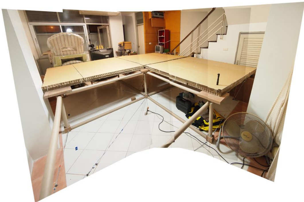
ภาพที่ 5.48 การปูแผ่นพื้นกระดานล่าง
