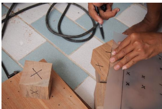
ภาพที่ 5.14 ทำเครื่องหมายที่บล็อกไม้เพื่อเจาะรูตรงจุดกึ่งกลาง
