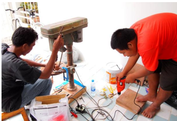
ภาพที่ 5.7 การก่อสร้างโดยใช้เครื่องมือที่มีทั่วไป
