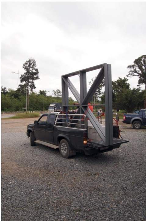
ภาพที่ 5.61 โครงเหล็กกล่องซึ่งใช้เป็นโครงสร้างรับพื้น สำหรับโครงที่นำมาใช้เป็นพื้นนั้นเป็นโครงเหล็กกล่องสำเร็จรูปมาจากโรงงาน
