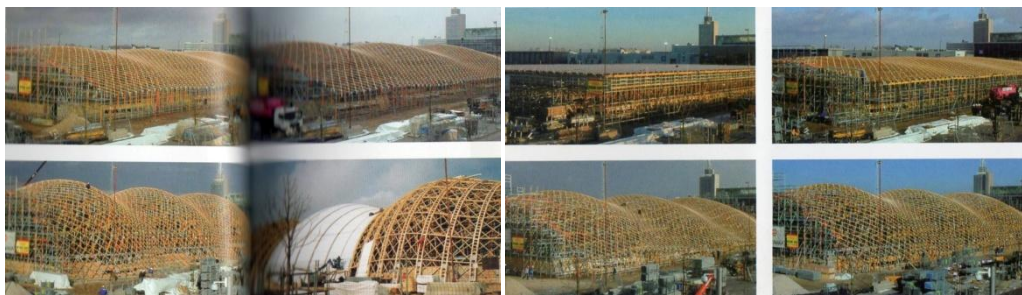
ภาพที่ 2.25 การก่อสร้างโครงสร้างของ Japan Pavilion Expo 2000 เมืองฮันโนเวอร์ ประเทศเยอรมัน
