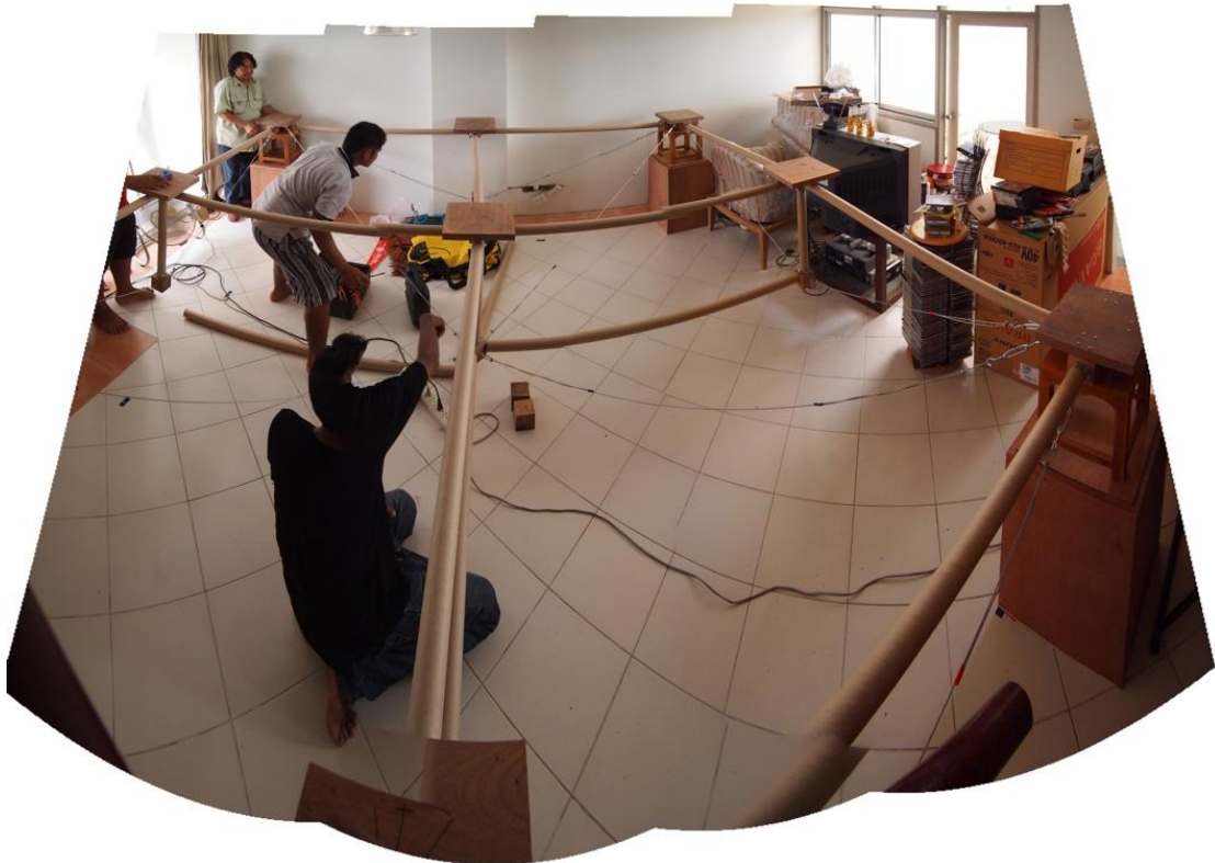
ภาพที่ 5.47 ทำการยกโครงสร้างทั้งหมดให้ลอยขึ้นเพื่อเตรียมบันทึกลง
