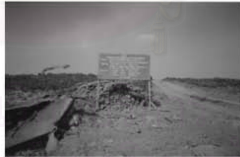
(1) โครงการปรับปรุงพื้นที่หนองกลางแจ้งส่วนที่สอง
