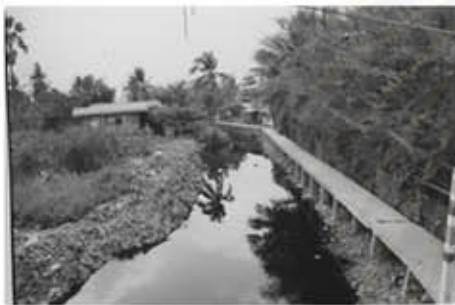
(3) บริเวณคลองสองห้องที่เชื่อมต่อกับ ตำรางสาธารณะส่วนในสภาพน้ำมีกลิ่นเหม็น มีสีดำ
